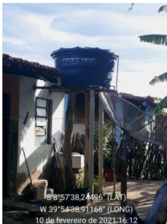
Figura 224 – Reservatório Fonte: INSTITUTO GESOIS, 2021.
