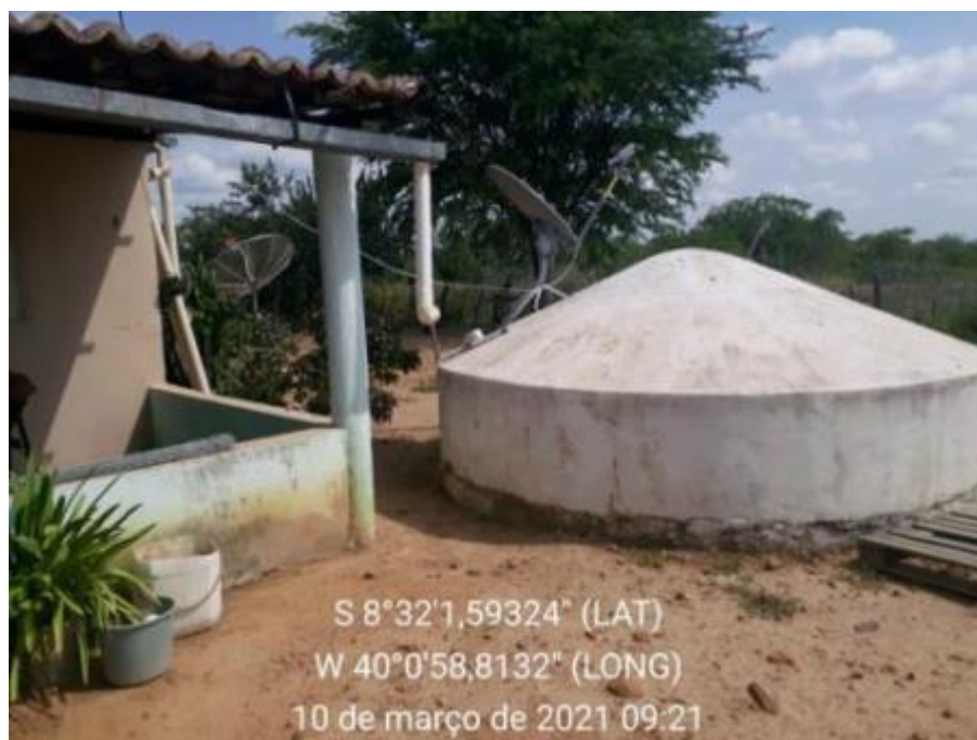
Figura 37 – Cisterna Fonte: INSTITUTO GESOIS, 2021.
