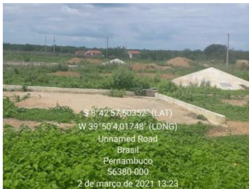
Figura 149 – Cisterna Calçadão Fonte: INSTITUTO GESOIS, 2021.
