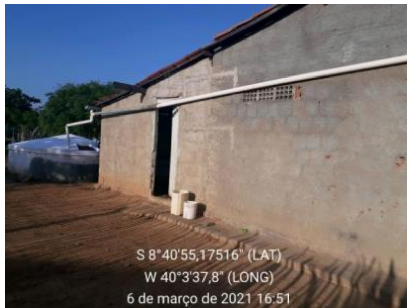
Figura 183 – Cisterna Fonte: INSTITUTO GESOIS, 2021.
