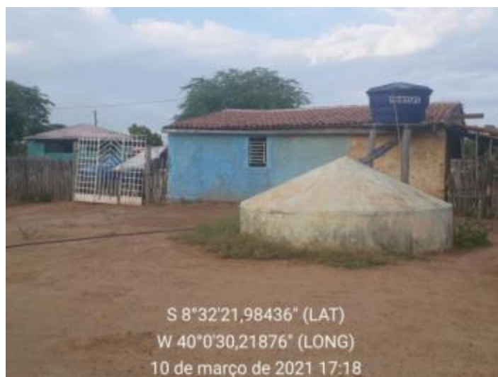
Figura 35 – Captação de Água de Chuva Fonte: INSTITUTO GESOIS, 2021.
