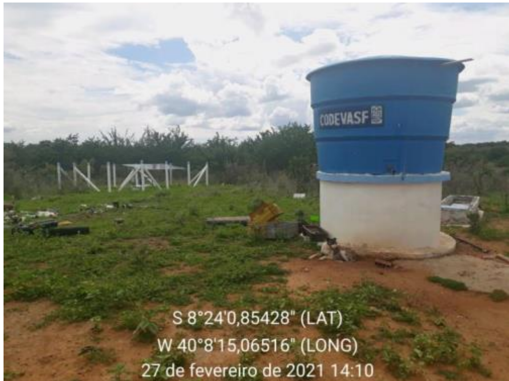
Figura 50 – Poço Subterrâneo, Reservatório 5.000 L (Funciona com Energia Solar)
