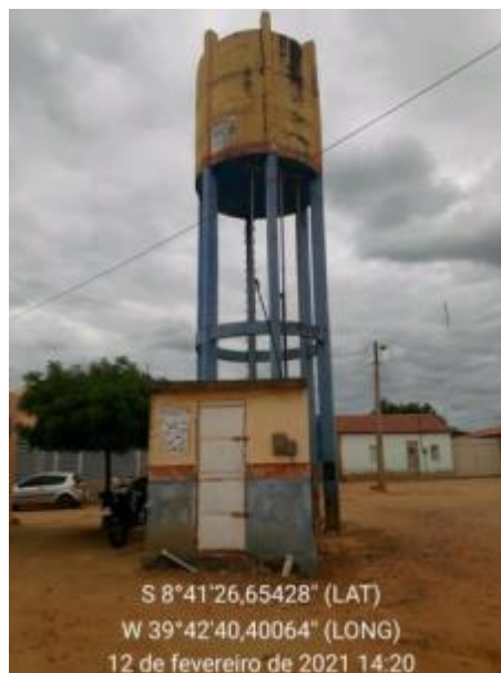
Figura 228 – Reservatório Fonte: INSTITUTO GESOIS, 2021.
