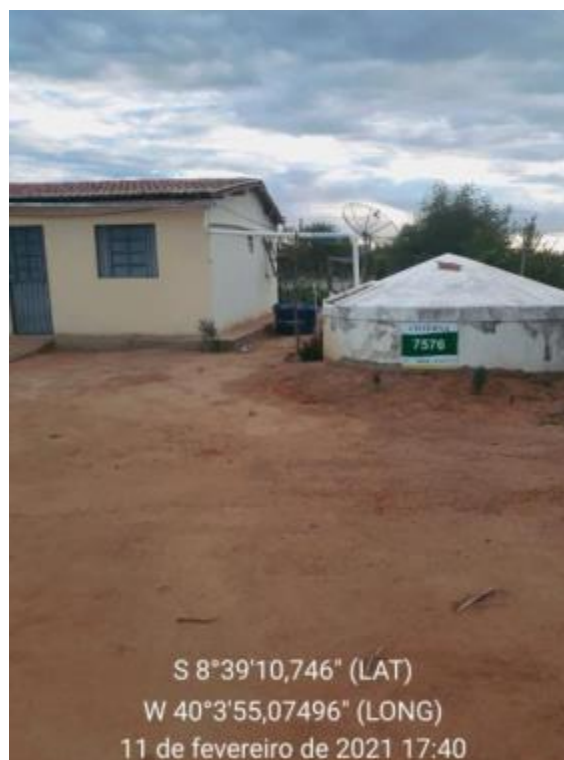
Figura 137 – Cisterna Fonte: INSTITUTO GESOIS, 2021.
