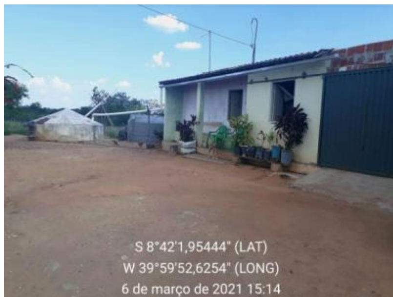
Figura 154 – Cisterna Fonte: INSTITUTO GESOIS, 2021.
