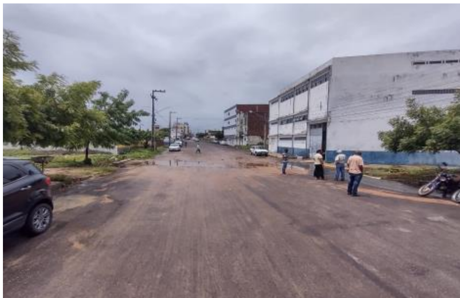
Figura 420 – Aspecto da via sem dispositivos de drenagem e acúmulo de água Fonte: INSTITUTO GESOIS, 2020.
