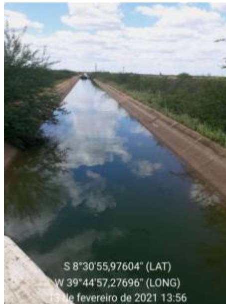
Figura 276 – Canal de Aproximação Fonte: INSTITUTO GESOIS, 2021.
