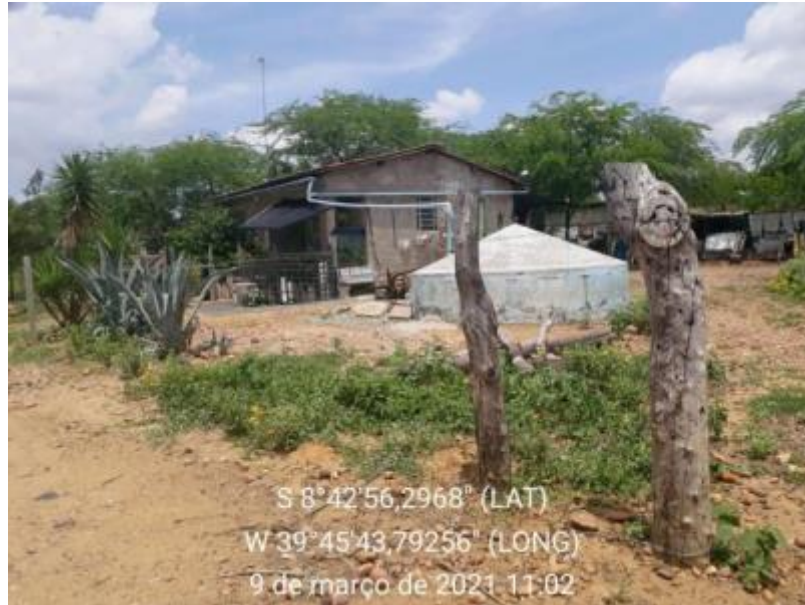
Figura 72 – Cisterna Fonte: INSTITUTO GESOIS, 2021.
