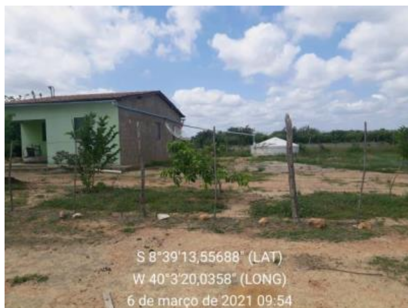
Figura 127 – Cisterna Fonte: INSTITUTO GESOIS, 2021.
