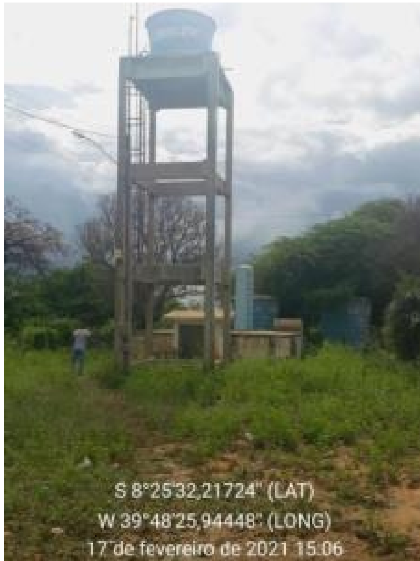
Figura 339 – Reservatório Fonte: INSTITUTO GESOIS, 2021.
