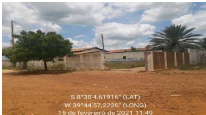
Figura 266 – Escola Desativada Fonte: INSTITUTO GESOIS, 2021.
