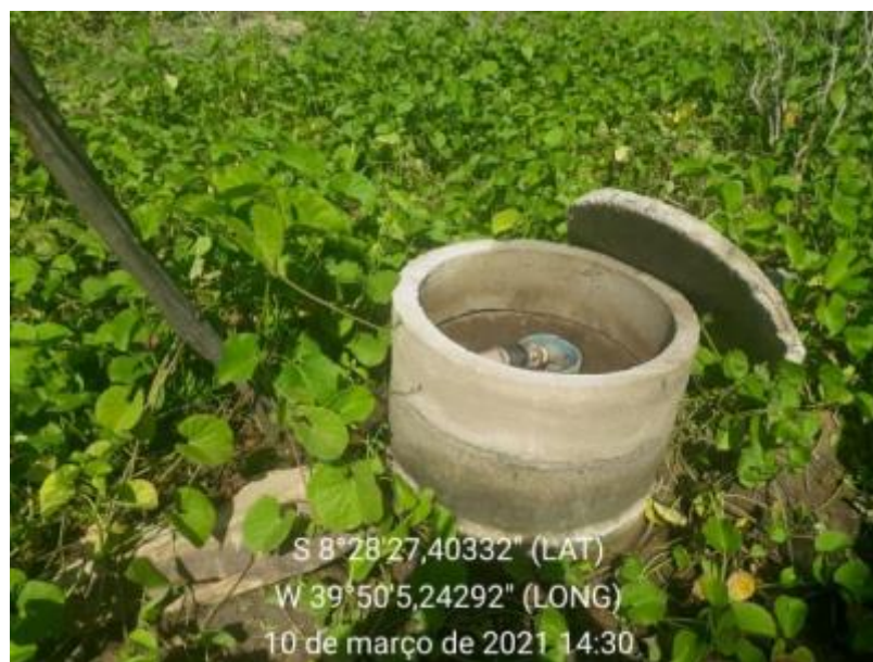
Figura 170 – Poço Subterrâneo Fonte: INSTITUTO GESOIS, 2021.
