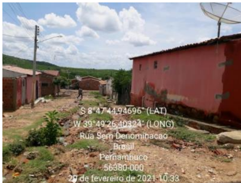
Figura 354 – Esgoto a Céu Aberto Fonte: INSTITUTO GESOIS, 2021.
