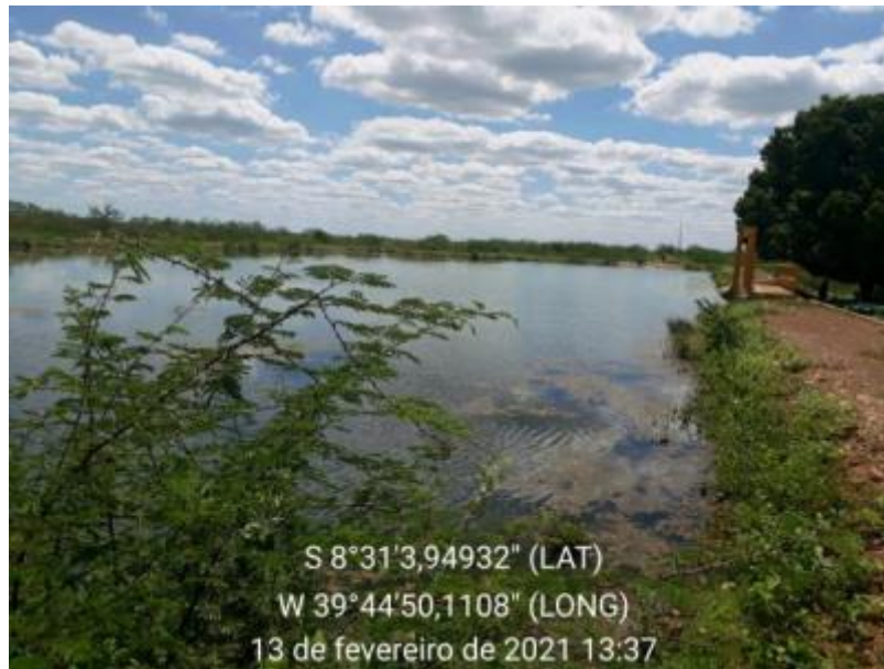
Figura 272 – Reservatório de Água I Fonte: INSTITUTO GESOIS, 2021.
