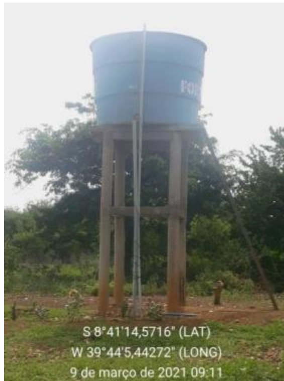
Figura 215 – Reservatório Fonte: INSTITUTO GESOIS, 2021.
