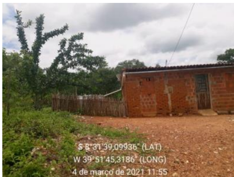
Figura 97 – Cisterna Fonte: INSTITUTO GESOIS, 2021.
