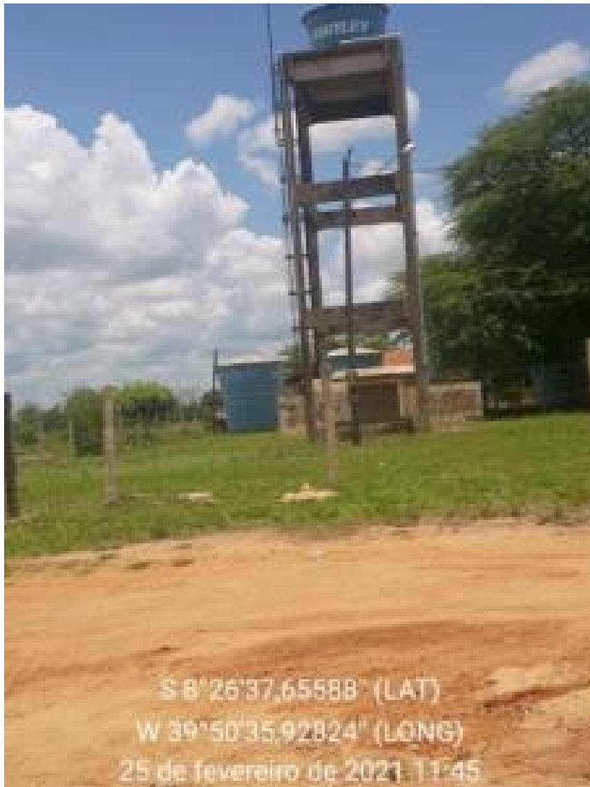
Figura 332 – Reservatório Fonte: INSTITUTO GESOIS, 2021.
