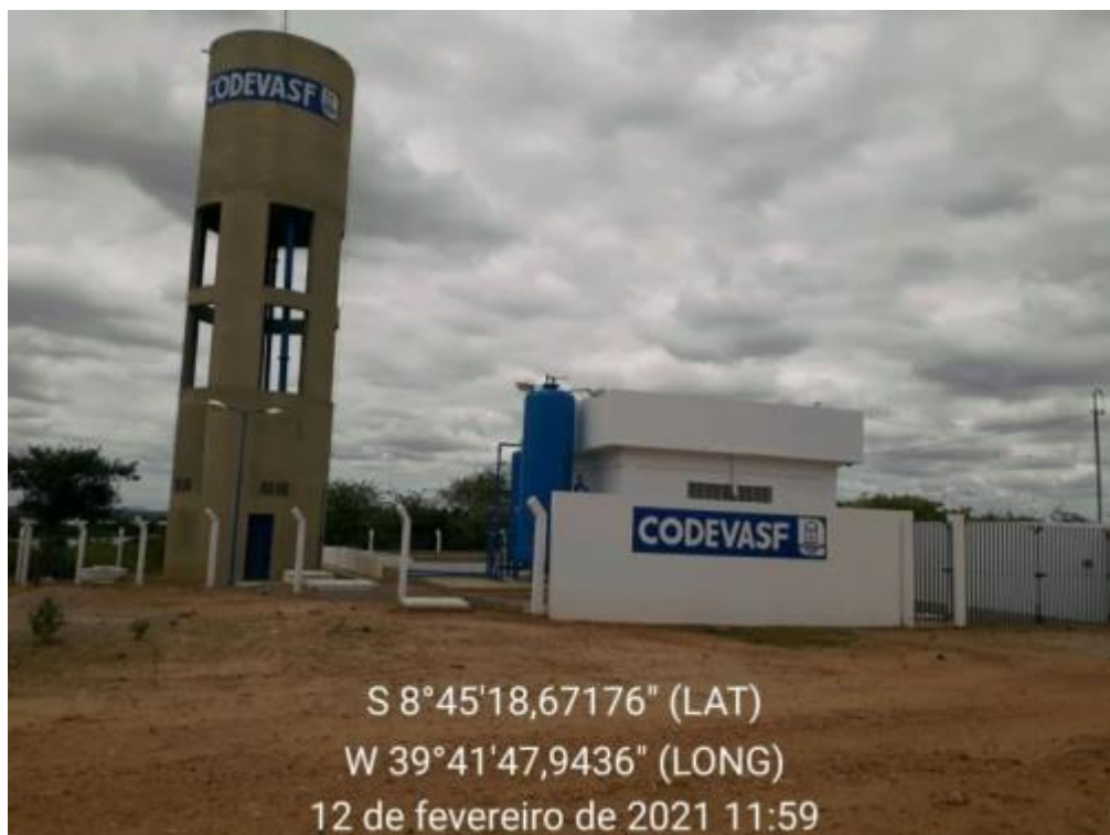
Figura 110 – Reservatório Serrote (CODEVASF) Fonte: INSTITUTO GESOIS, 2021.
