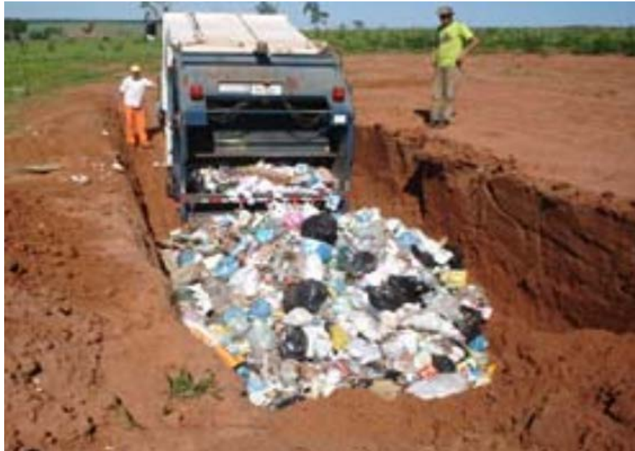
Figura 389 – Aterro Controlado. Fonte: GESOIS, 2017.
