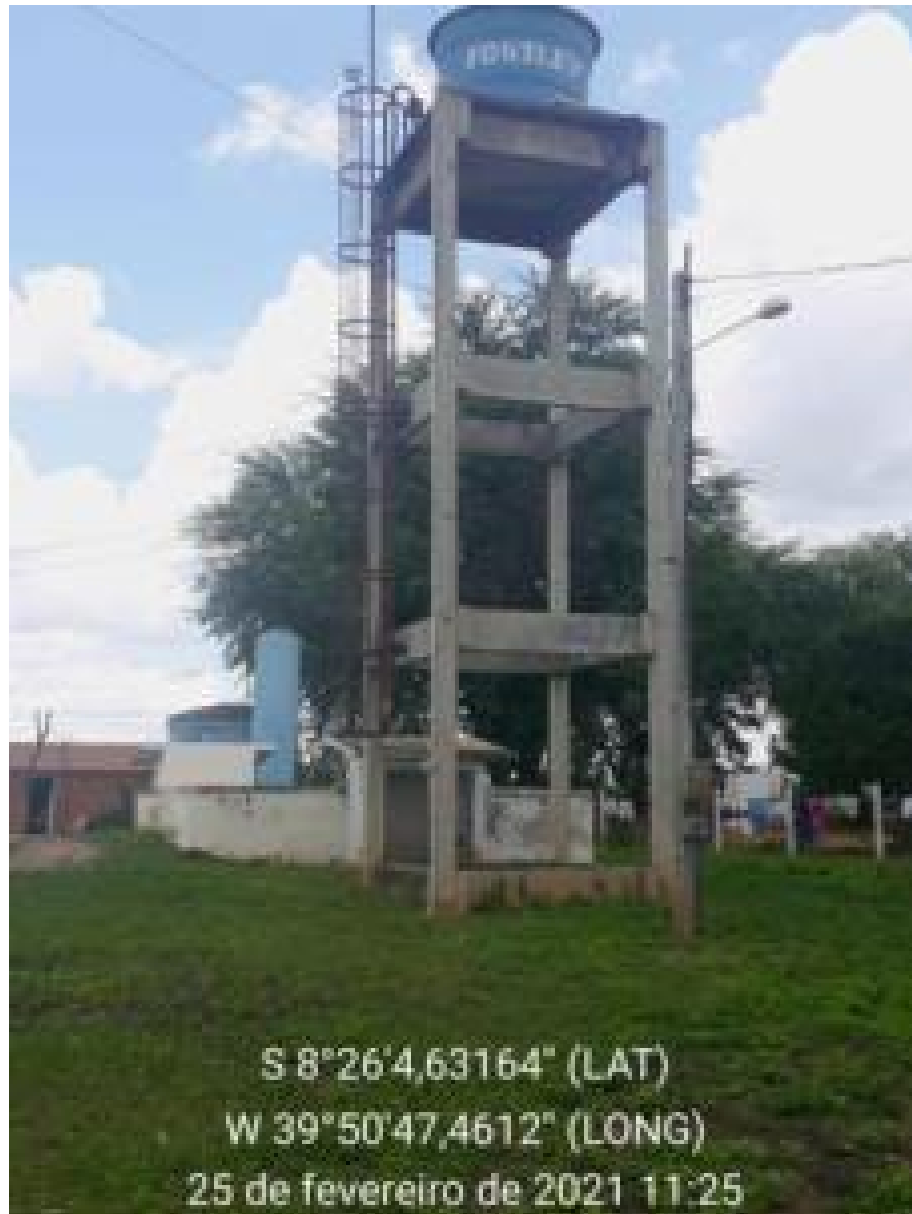
Figura 333 – Reservatório Fonte: INSTITUTO GESOIS, 2021.
