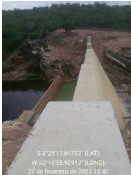
Figura 85 – Barragem de São Joaquim (CODEVASF) Fonte: INSTITUTO GESOIS, 2021.
