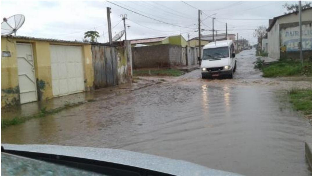
Figura 421 – Alagamento em cruzamento de vias Fonte: INSTITUTO GESOIS, 2020.
