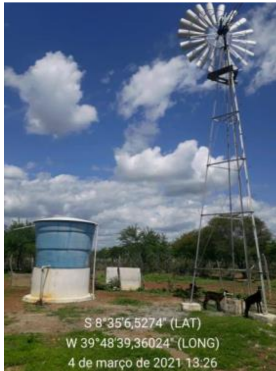
Figura 165 – Poço Catavento, Vazão 1.500 L/h Fonte: INSTITUTO GESOIS, 2021.
