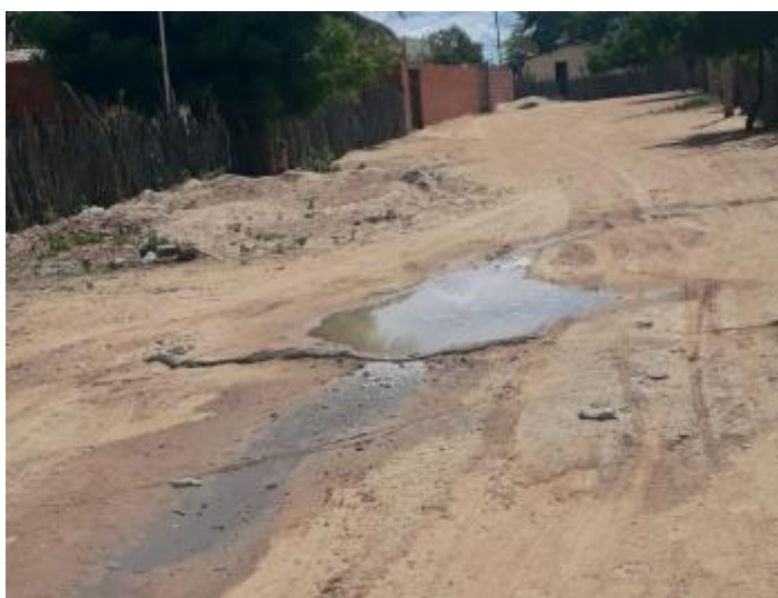
Figura 445 - Acúmulo de água das chuvas na via do Assentamento Aquarius Fonte: INSTITUTO GESOIS, 2020.
