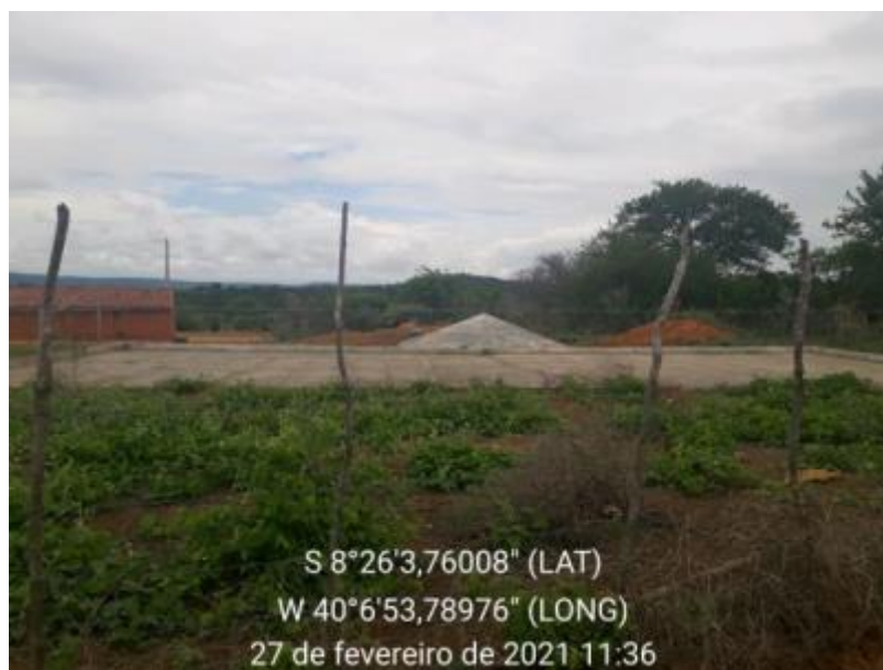
Figura 94 – Cisterna Calçadão Fonte: INSTITUTO GESOIS, 2021.
