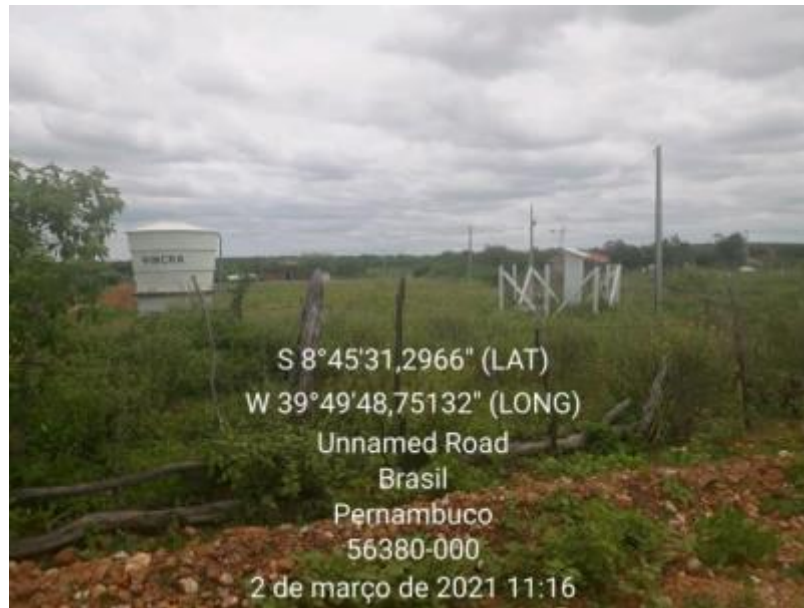
Figura 148 – Poço Catavento Fonte: INSTITUTO GESOIS, 2021.
