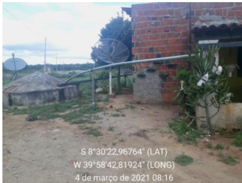
Figura 61 – Cisterna Fonte: INSTITUTO GESOIS, 2021.
