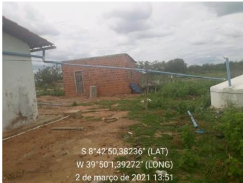
Figura 130 – Cisterna Fonte: INSTITUTO GESOIS, 2021.
