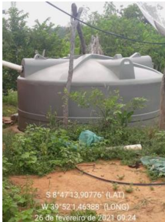
Figura 161 – Cisterna Fonte: INSTITUTO GESOIS, 2021.
