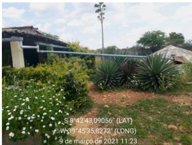
Figura 73 – Cisterna Fonte: INSTITUTO GESOIS, 2021.
