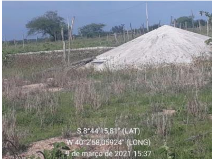
Figura 160 – Cisterna Calçadão Fonte: INSTITUTO GESOIS, 2021.
