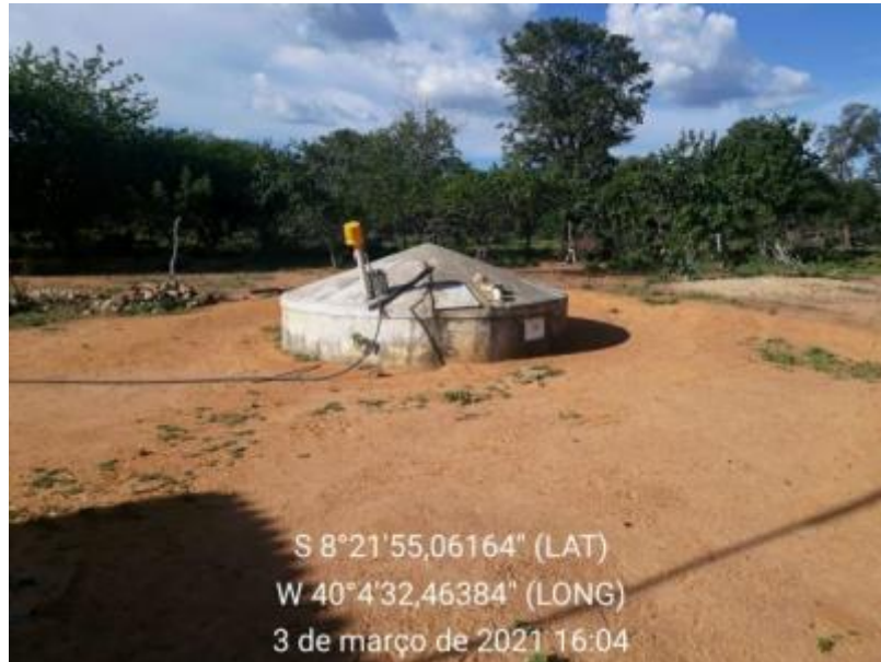
Figura 68 – Cisterna Fonte: INSTITUTO GESOIS, 2021.
