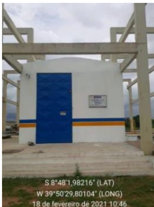
Figura 33 – Captação do Garças Fonte: INSTITUTO GESOIS, 2021.
