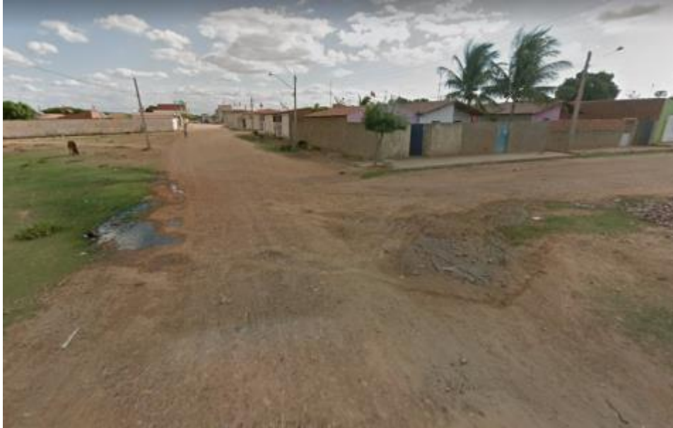
Figura 417 - Aspecto de via sem pavimentação na sede municipal Fonte: INSTITUTO GESOIS, 2020.
