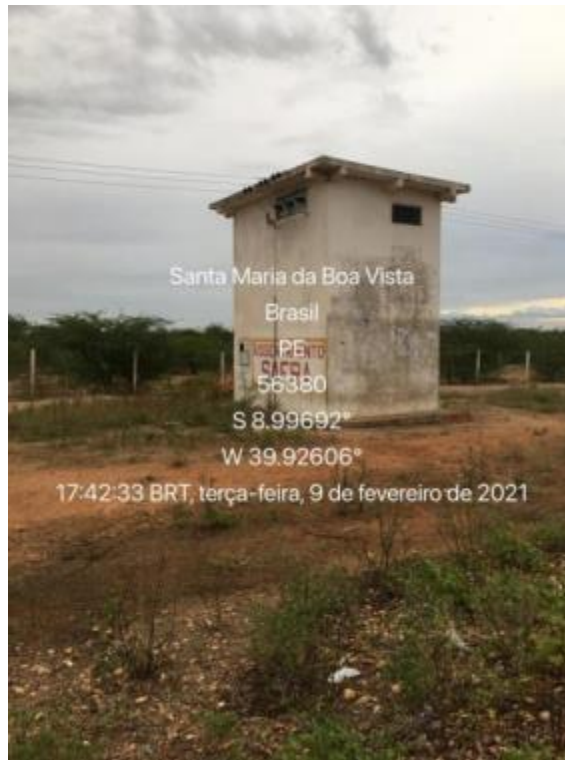
Figura 197 – Casa de Força Fonte: INSTITUTO GESOIS, 2021.
