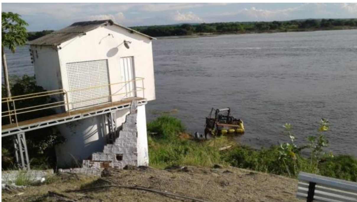
Figura 20 – Captação COMPESA Fonte: INSTITUTO GESOIS, 2021.
