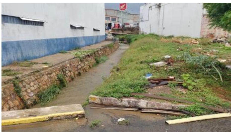
Figura 424 - Canal de macrodrenagem na Avenida Doutor Oscár Sampaio Fonte: INSTITUTO GESOIS, 2020.
