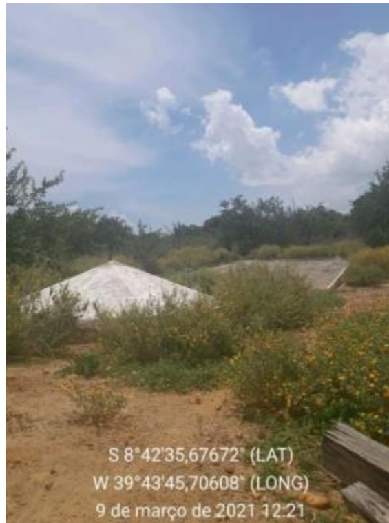
Figura 158 – Cisterna Calçadão Fonte: INSTITUTO GESOIS, 2021.
