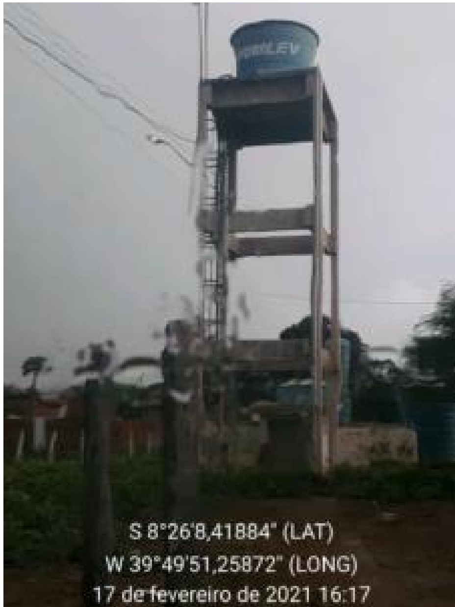
Figura 334 – Reservatório Fonte: INSTITUTO GESOIS, 2021.
