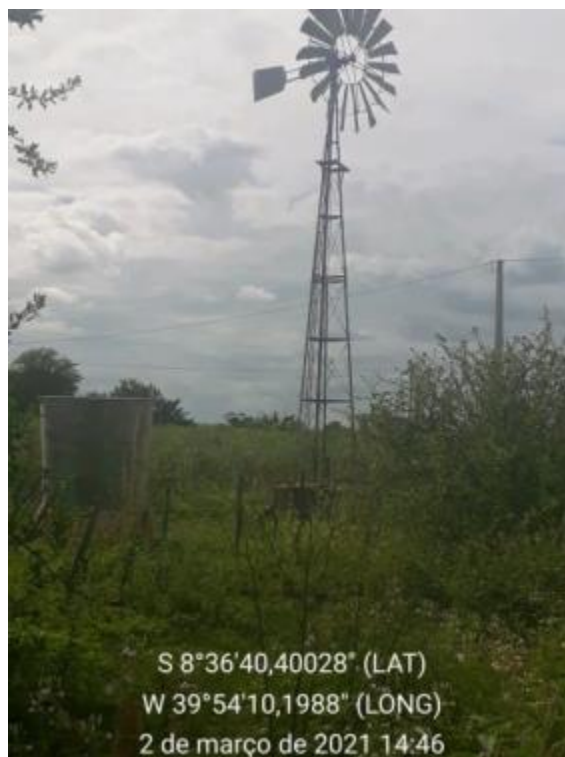
Figura 144 – Poço Catavento Fonte: INSTITUTO GESOIS, 2021.
