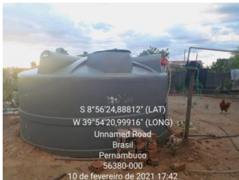
Figura 188 – Cisterna Fonte: INSTITUTO GESOIS, 2021.
