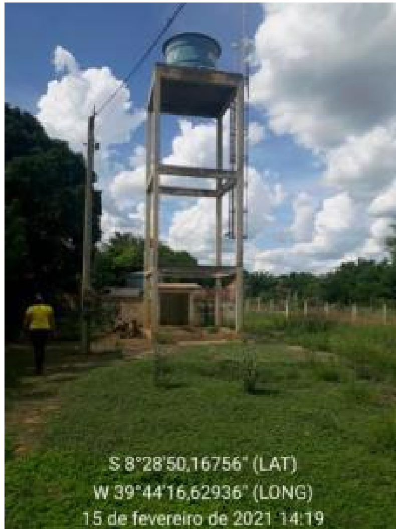
Figura 303 – Reservatório Fonte: INSTITUTO GESOIS, 2021.
