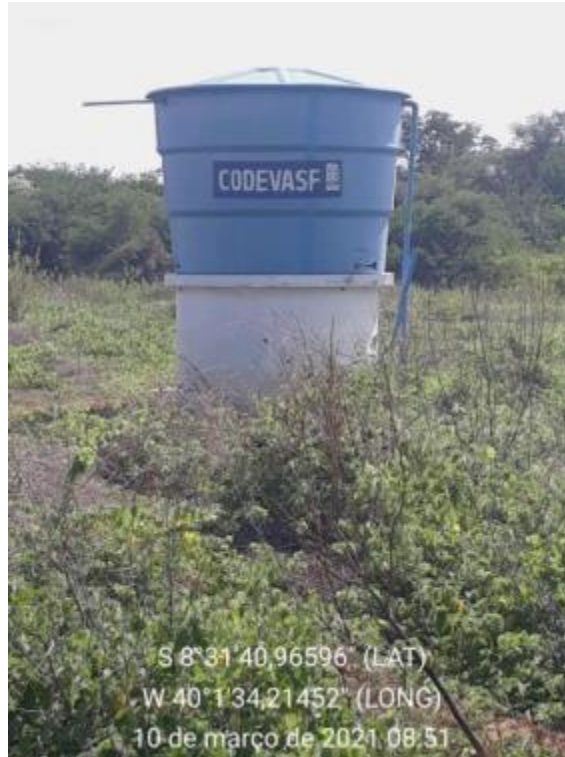
Figura 51 – Poço Subterrâneo, Fazenda Ponta da Serra, Reservatório 5.000 L Fonte: INSTITUTO GESOIS, 2021.
