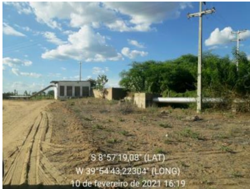
Figura 204 – Adutora Desativada Fonte: INSTITUTO GESOIS, 2021.
