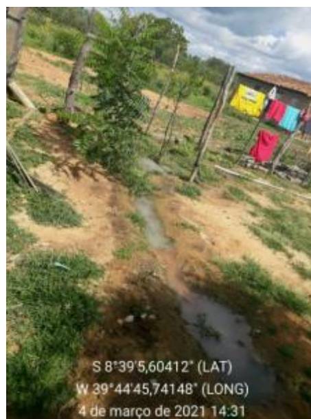
Figura 361 – Esgoto a céu aberto, Comunidade Barra Nova Fonte: INSTITUTO GESOIS, 2021.
