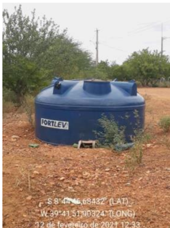
Figura 114 – Cisterna Fonte: INSTITUTO GESOIS, 2021.
