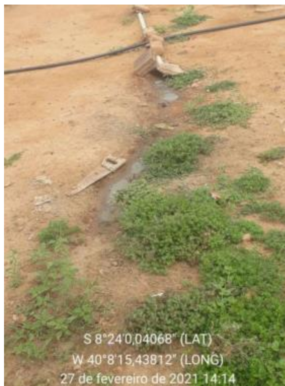
Figura 363 – Esgoto a Céu Aberto Faz. Salina Fonte: INSTITUTO GESOIS, 2021.
