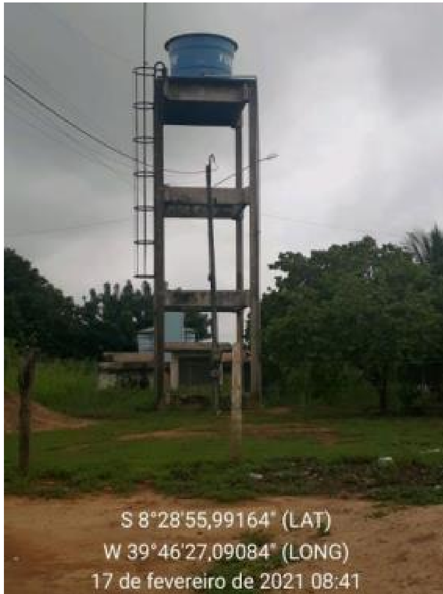
Figura 314 – Reservatório Fonte: INSTITUTO GESOIS, 2021.
