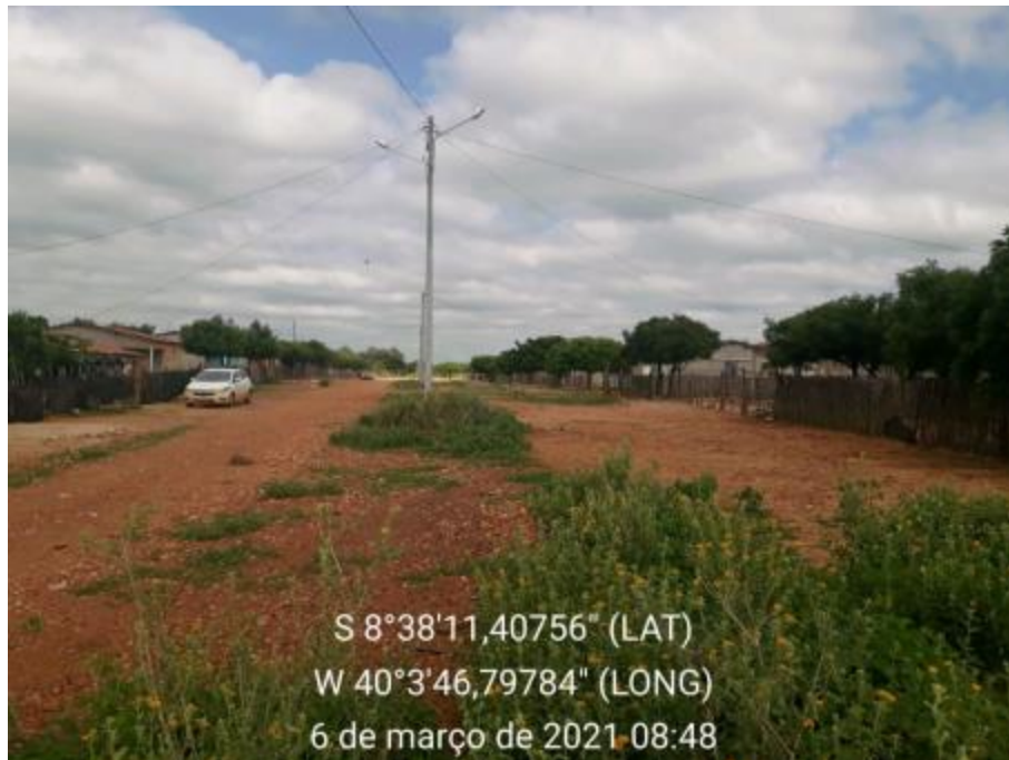
Figura 451 - Ponto de alagamento Assentamento Begard Fonte: INSTITUTO GESOIS, 2020.
