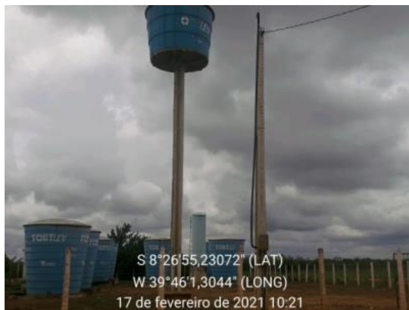
Figura 322 – Sistema de Tratamento Desativado Fonte: INSTITUTO GESOIS, 2021.
