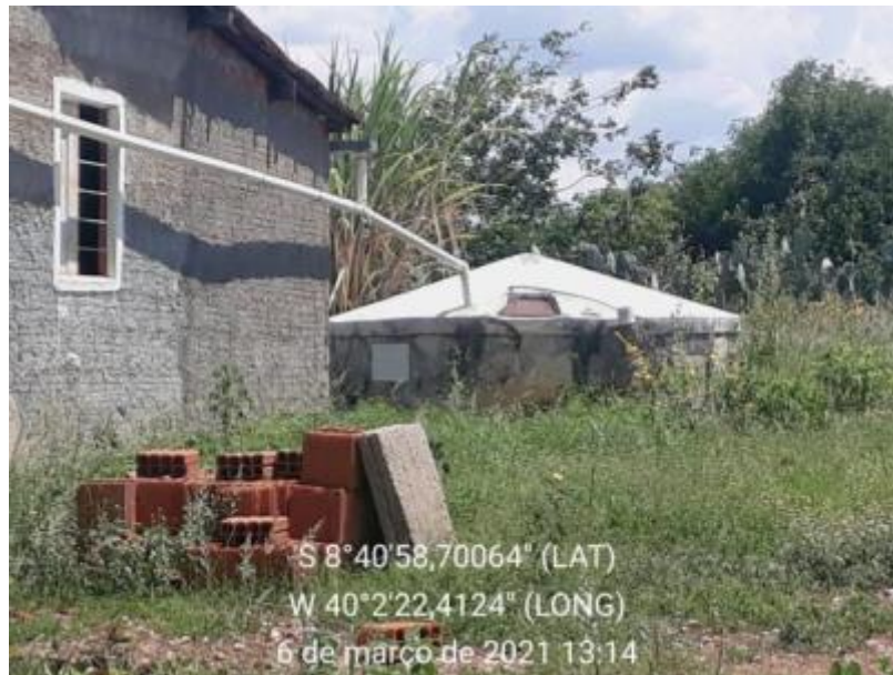
Figura 167 – Cisterna Fonte: INSTITUTO GESOIS, 2021.
