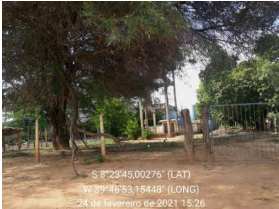
Figura 344 – Estação Elevatória Fonte: INSTITUTO GESOIS, 2021.
