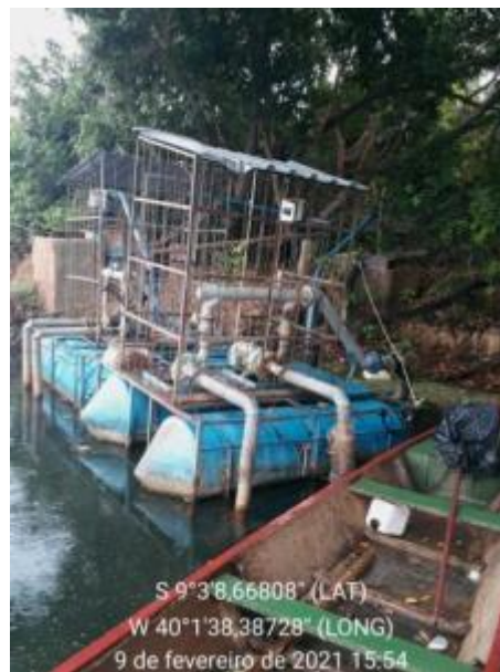
Figura 176 – Captação Fonte: INSTITUTO GESOIS, 2021.
