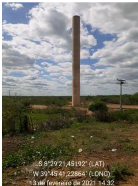
Figura 283 – Elevatória Fonte: INSTITUTO GESOIS, 2021.
