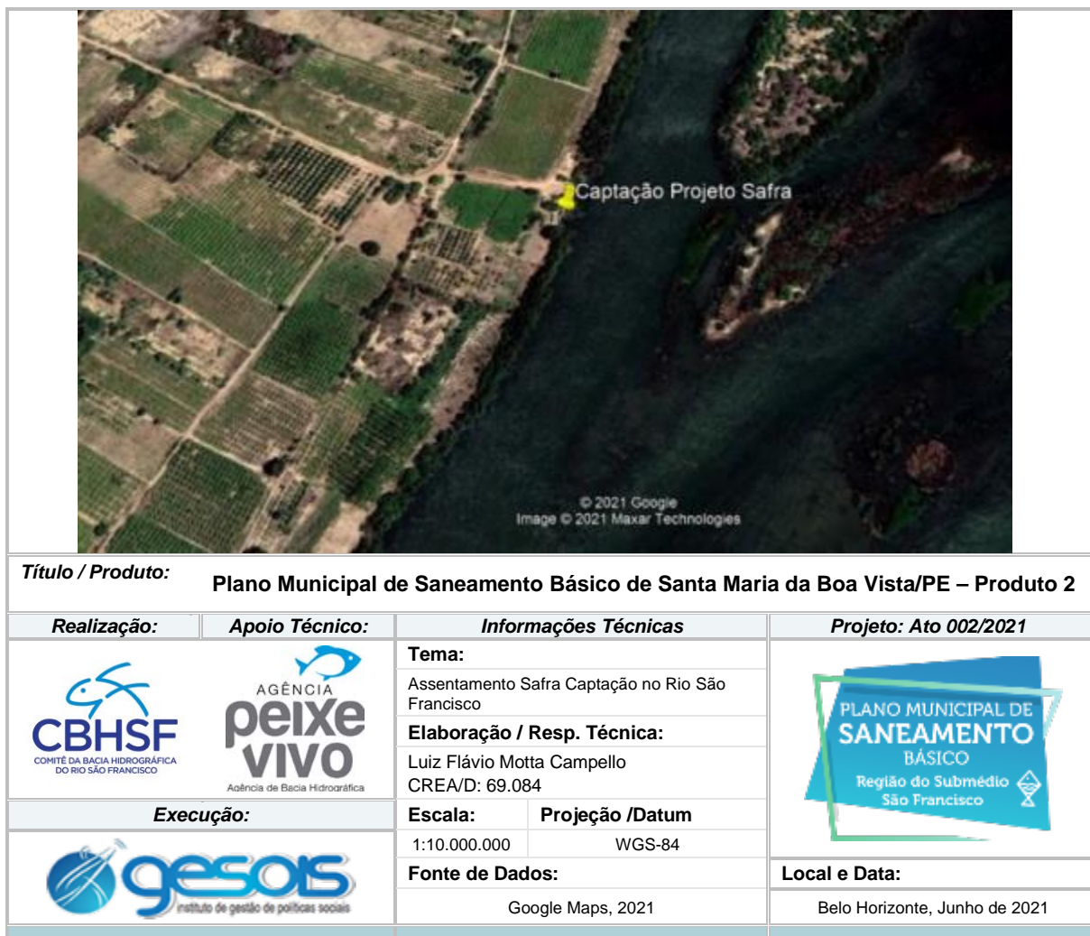
Figura 190 – Captação no Rio São Francisco Fonte: INSTITUTO GESOIS, 2021.
