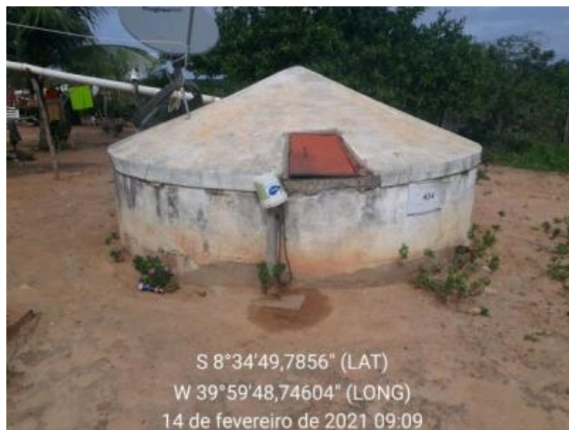
Figura 140 – Cisterna Fonte: INSTITUTO GESOIS, 2021.
