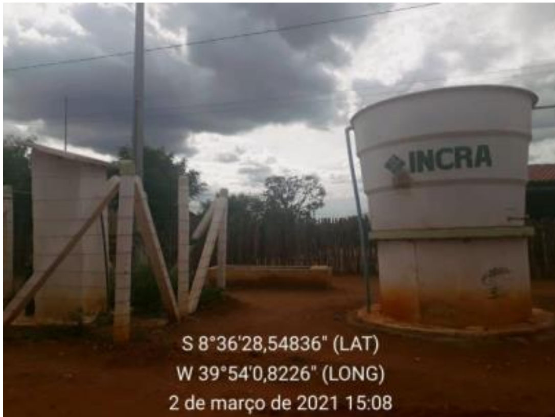
Figura 145 – Poço Subterrâneo Fonte: INSTITUTO GESOIS, 2021.
