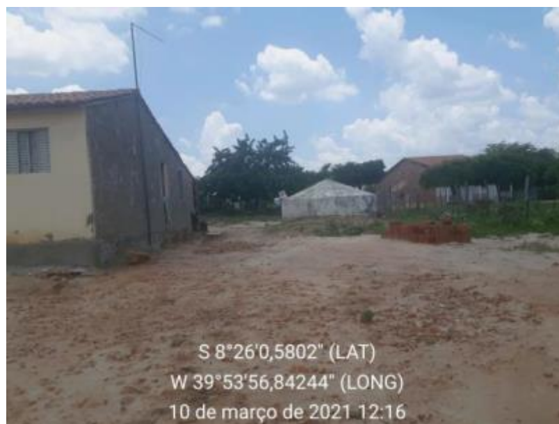
Figura 84 – Cisterna Fonte: INSTITUTO GESOIS, 2021.
