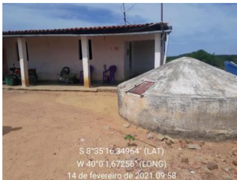
Figura 118 – Cisterna Fonte: INSTITUTO GESOIS, 2021.
