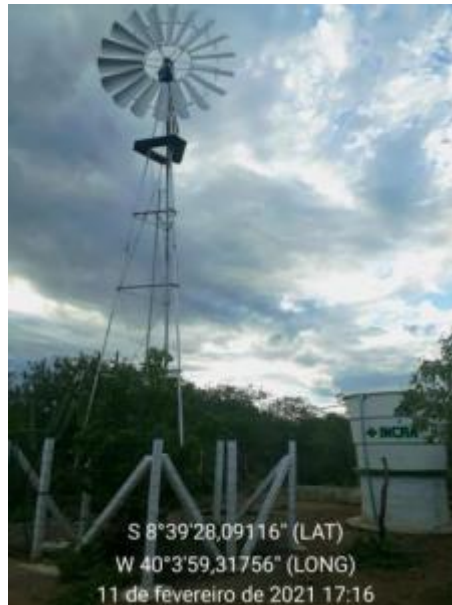
Figura 134 – Poço Subterrâneo Fonte: INSTITUTO GESOIS, 2021.
