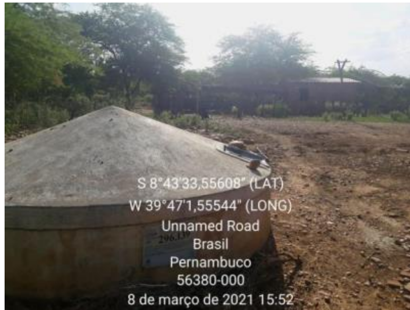
Figura 66 – Cisterna Fonte: INSTITUTO GESOIS, 2021.
