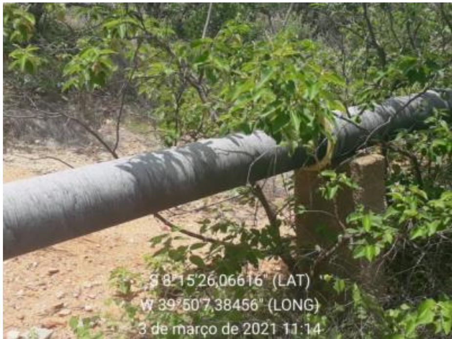
Figura 41 – Adutora em FoFo Fonte: INSTITUTO GESOIS, 2021.
