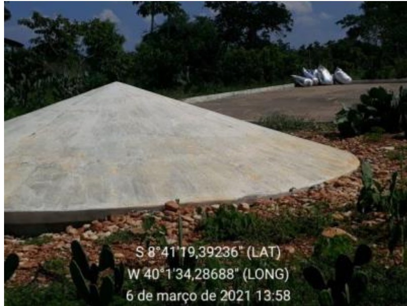
Figura 55 – Cisterna Calçadão Fonte: INSTITUTO GESOIS, 2021.
