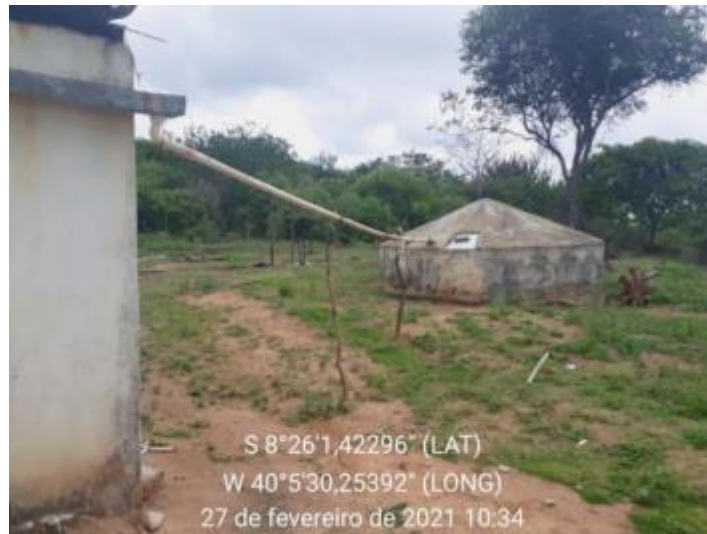
Figura 46 – Cisterna Fonte: INSTITUTO GESOIS, 2021.
