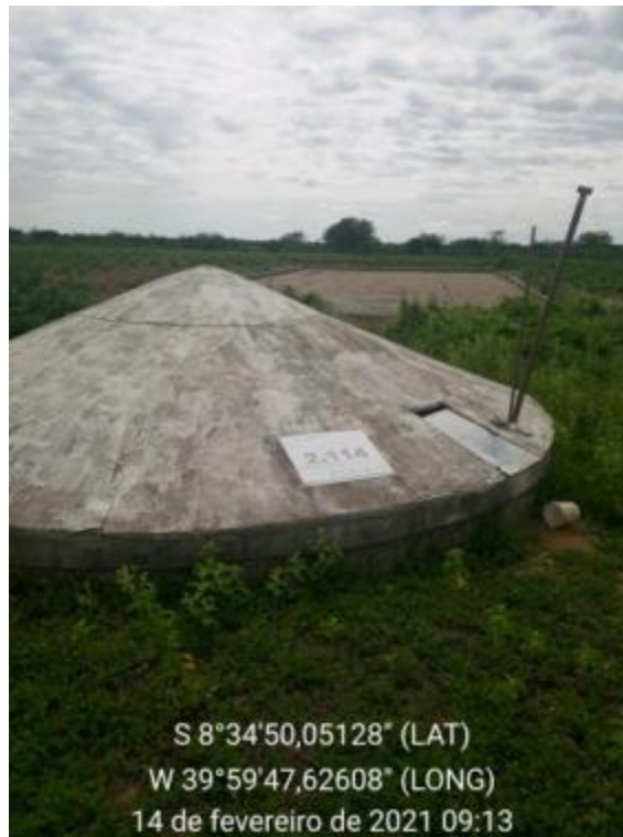
Figura 139 – Cisterna Fonte: INSTITUTO GESOIS, 2021.
