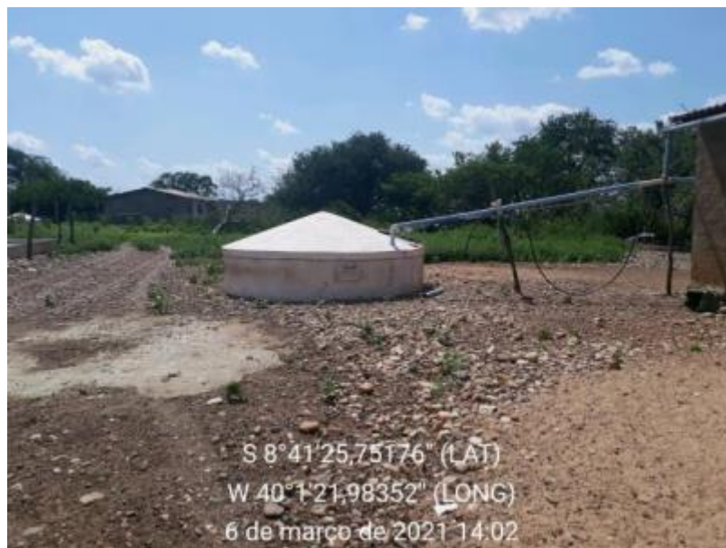
Figura 56 – Cisterna Fonte: INSTITUTO GESOIS, 2021.
