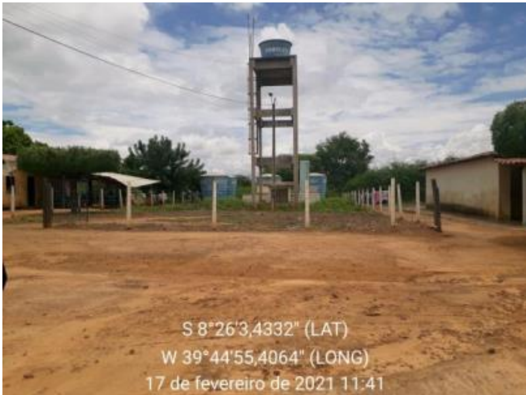
Figura 324 – Reservatório Fonte: INSTITUTO GESOIS, 2021.
