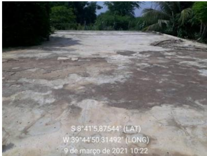
Figura 76 – Cisterna Calçadão Fonte: INSTITUTO GESOIS, 2021.
