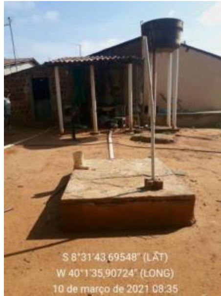
Figura 364 – Fossa negra Faz. Ponta da Serra Fonte: INSTITUTO GESOIS, 2021.
