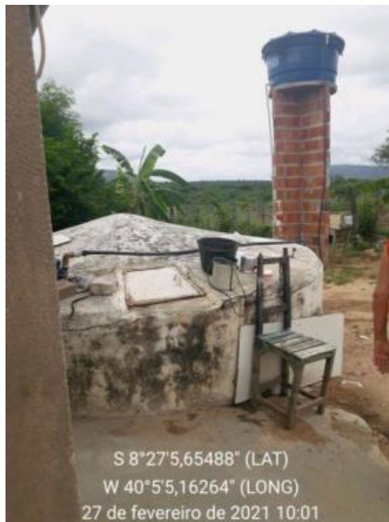
Figura 49 – Cisterna de Placas Fonte: INSTITUTO GESOIS, 2021.
