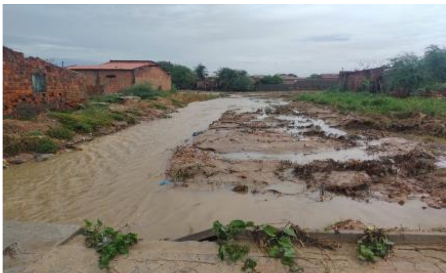
Figura 428 - Escoamento de águas pluviais em córrego Fonte: INSTITUTO GESOIS, 2020.
