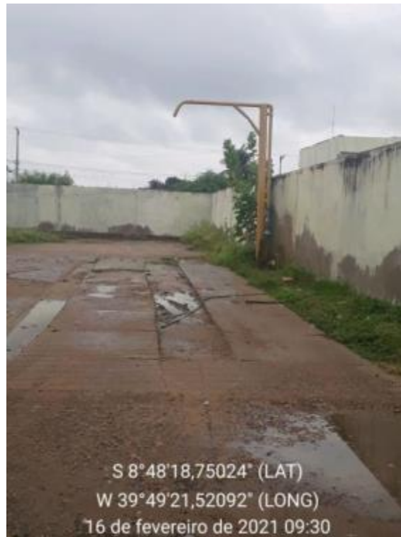
Figura 28 – Ponto de Abastecimento de Carros-pipa Fonte: INSTITUTO GESOIS, 2021.
