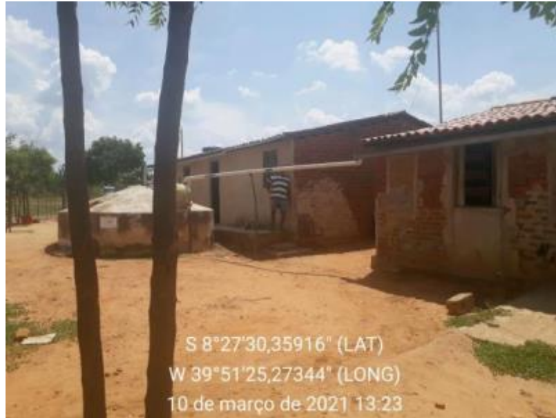
Figura 102 – Cisterna Fonte: INSTITUTO GESOIS, 2021.
