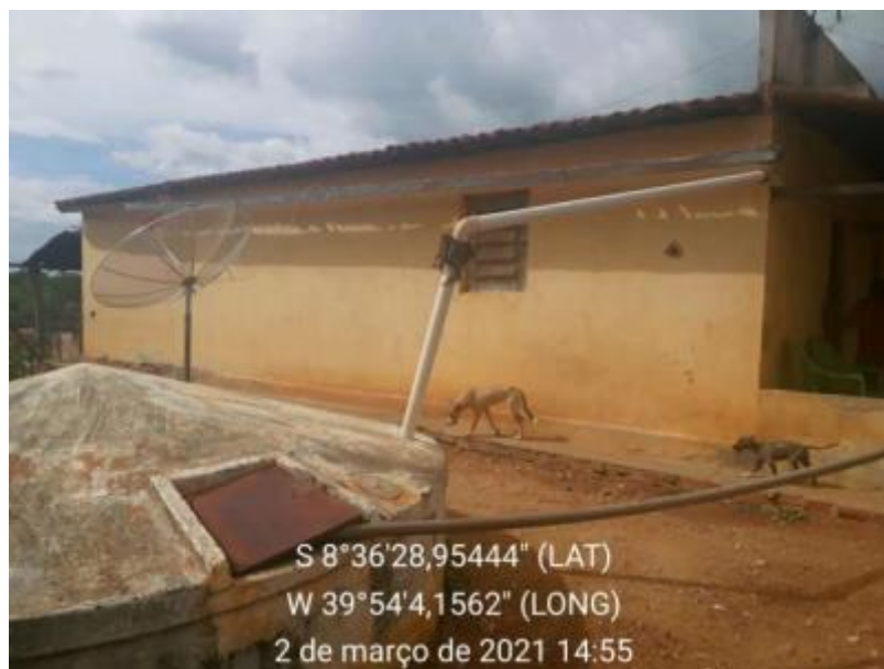
Figura 141 – Cisterna Fonte: INSTITUTO GESOIS, 2021.
