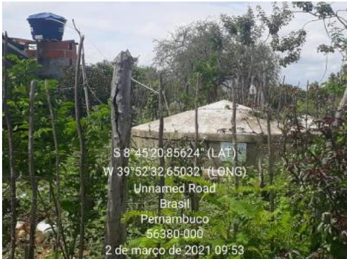
Figura 132 – Cisterna Fonte: INSTITUTO GESOIS, 2021.
