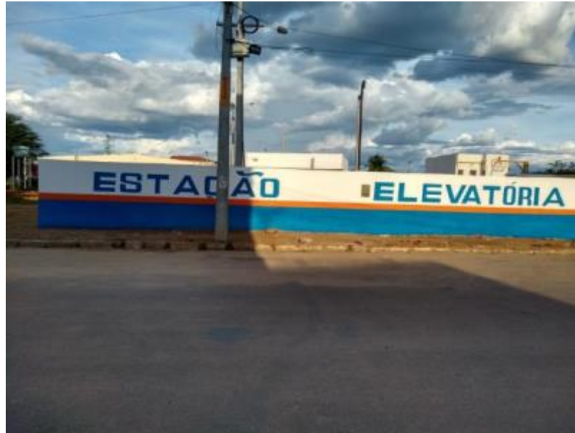
Figura 26 – EEBB, Ponto de Abastecimento dos Carros-pipa Fonte: INSTITUTO GESOIS, 2021.
