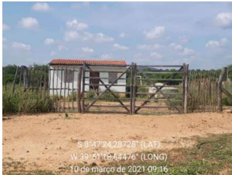
Figura 53 – Cisterna Fonte: INSTITUTO GESOIS, 2021.
