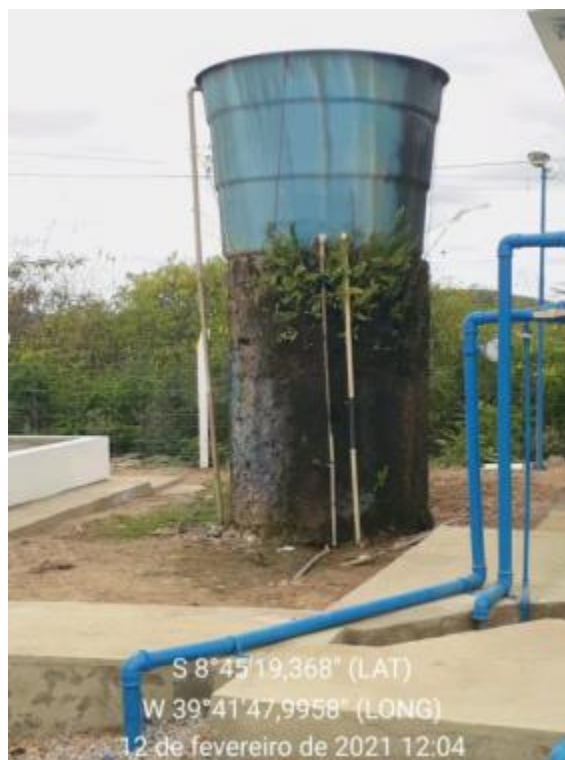
Figura 112 – Reservatório Serrote (CODEVASF) Fonte: INSTITUTO GESOIS, 2021.
