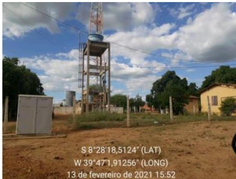
Figura 318 – Reservatório Fonte: INSTITUTO GESOIS, 2021.
