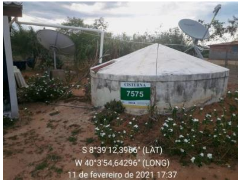
Figura 136 – Cisterna Fonte: INSTITUTO GESOIS, 2021.
