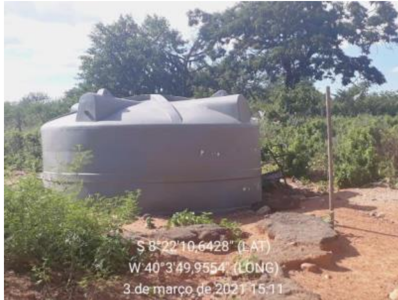
Figura 78 – Cisterna Fonte: INSTITUTO GESOIS, 2021.
