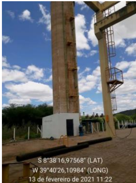
Figura 262 – Elevatória Fonte: INSTITUTO GESOIS, 2021.
