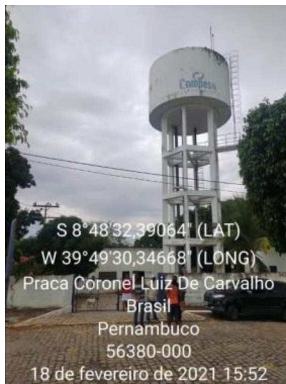
Figura 22 – Reservatório COMPESA Fonte: INSTITUTO GESOIS, 2021.
