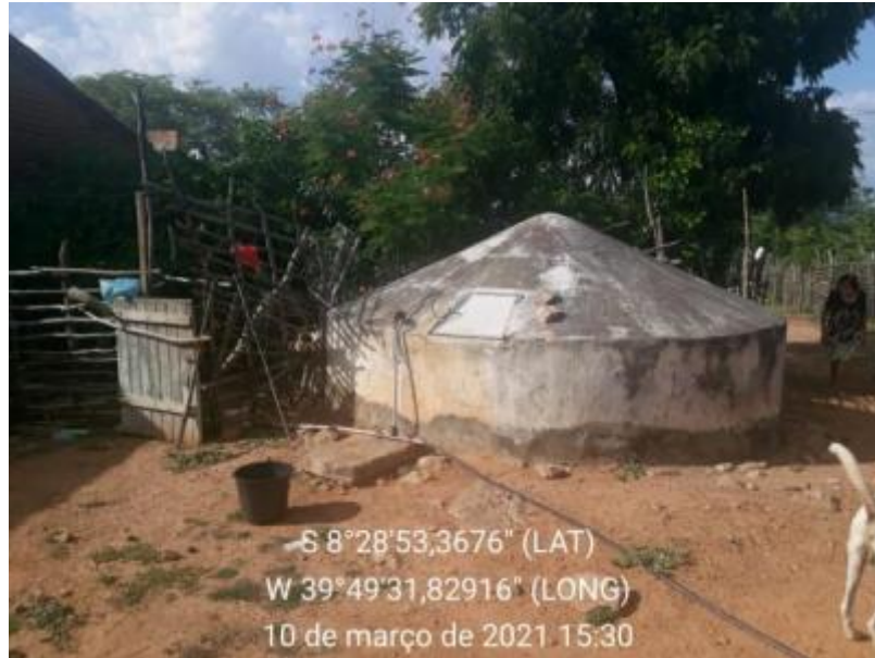
Figura 106 – Cisterna Fonte: INSTITUTO GESOIS, 2021.
