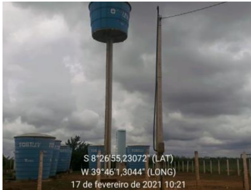
Figura 286 – Sistema de Tratamento Desativado Fonte: INSTITUTO GESOIS, 2021.
