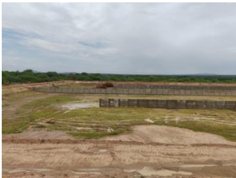
Figura 350 – ETE, Lagoa de Maturação Fonte: ANA, 2021.
