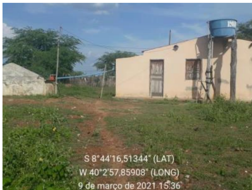
Figura 159 – Cisterna Fonte: INSTITUTO GESOIS, 2021.
