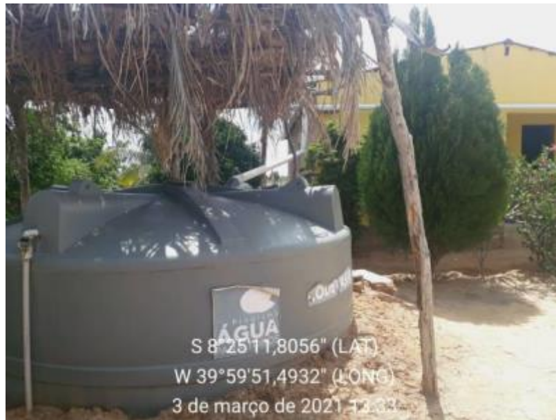
Figura 64 – Cisterna Fonte: INSTITUTO GESOIS, 2021.
