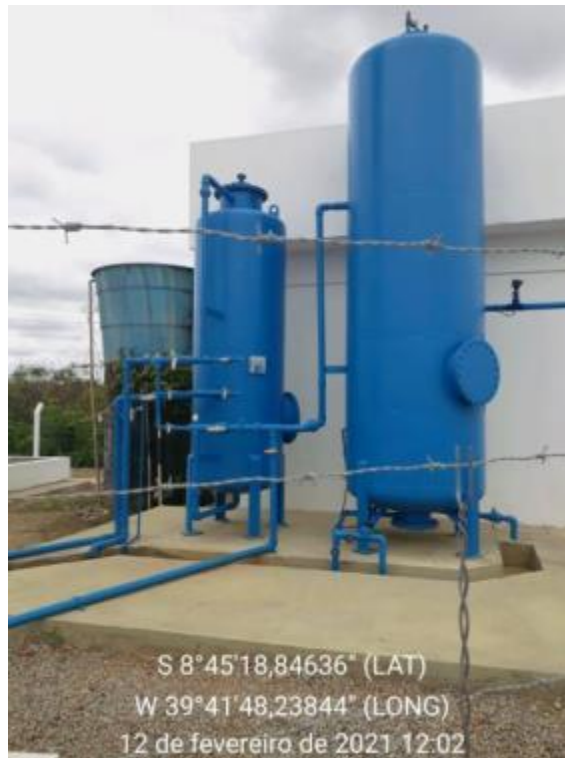
Figura 111 – Filtros Serrote (CODEVASF) Fonte: INSTITUTO GESOIS, 2021.
