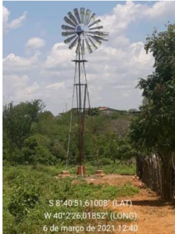
Figura 89 — Poço Catavento Fonte: INSTITUTO GESOIS, 2021.
