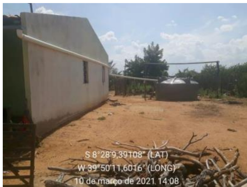
Figura 172 – Cisterna Fonte: INSTITUTO GESOIS, 2021.
