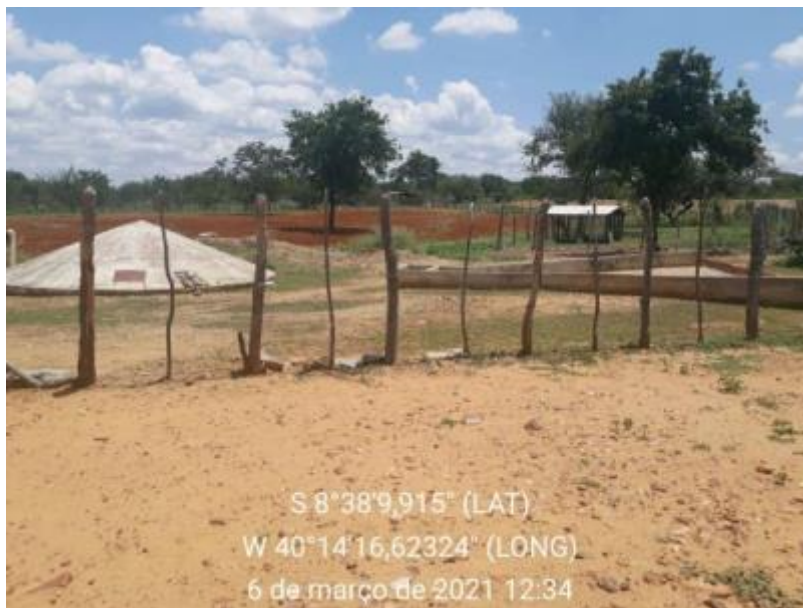
Figura 87 – Cisterna Fonte: INSTITUTO GESOIS, 2021.
