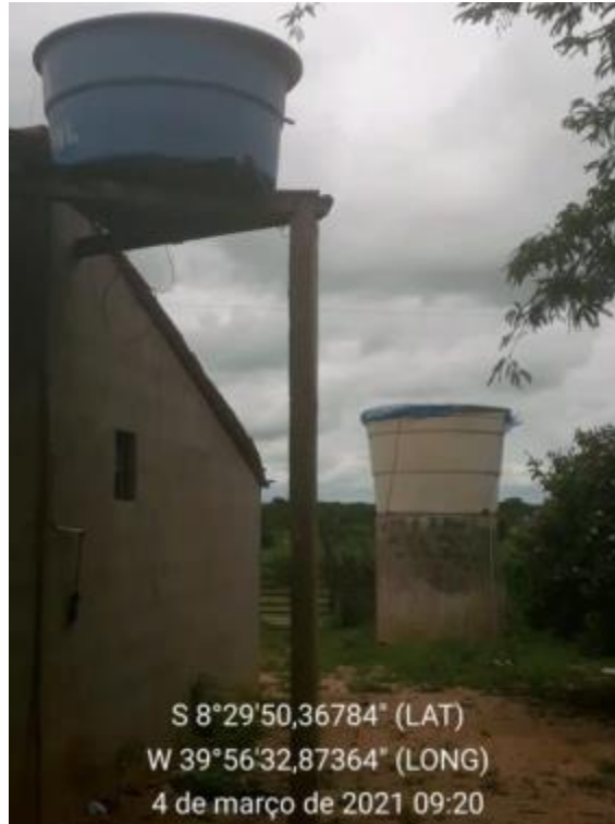
Figura 60 – Reservatórios, 5.000 L Fonte: INSTITUTO GESOIS, 2021.
