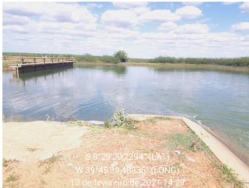
Figura 282 – Reservatório de Compensação III Fonte: INSTITUTO GESOIS, 2021.
