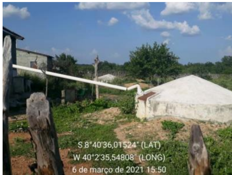
Figura 185 – Cisterna Fonte: INSTITUTO GESOIS, 2021.
