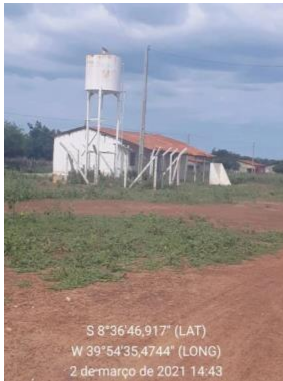
Figura 152 – Sistema Desativado Fonte: INSTITUTO GESOIS, 2021.
