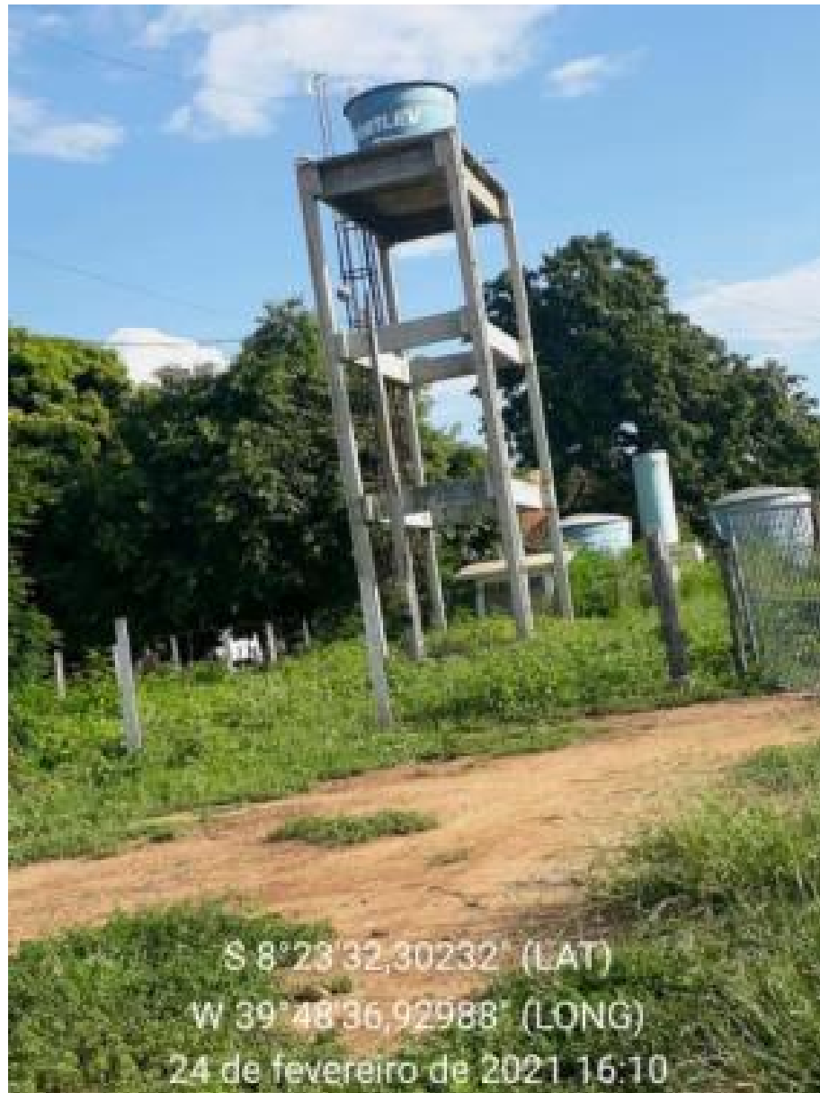
Figura 340 – Reservatório Fonte: INSTITUTO GESOIS, 2021.
