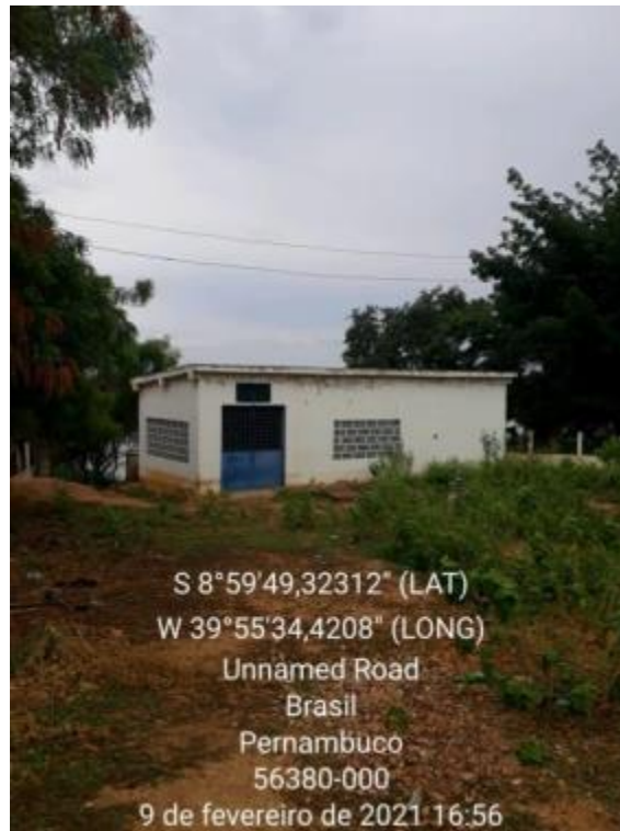
Figura 195 – Casa de Bombas Fonte: INSTITUTO GESOIS, 2021.
