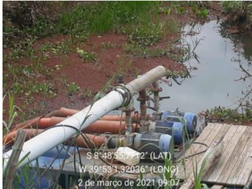
Figura 221 – Captação Fonte: INSTITUTO GESOIS, 2021.
