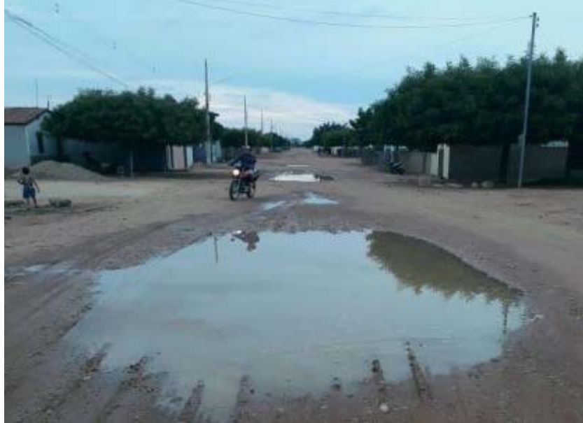
Figura 449 - Acúmulo de água das chuvas no Assentamento Safra Fonte: INSTITUTO GESOIS, 2020.
