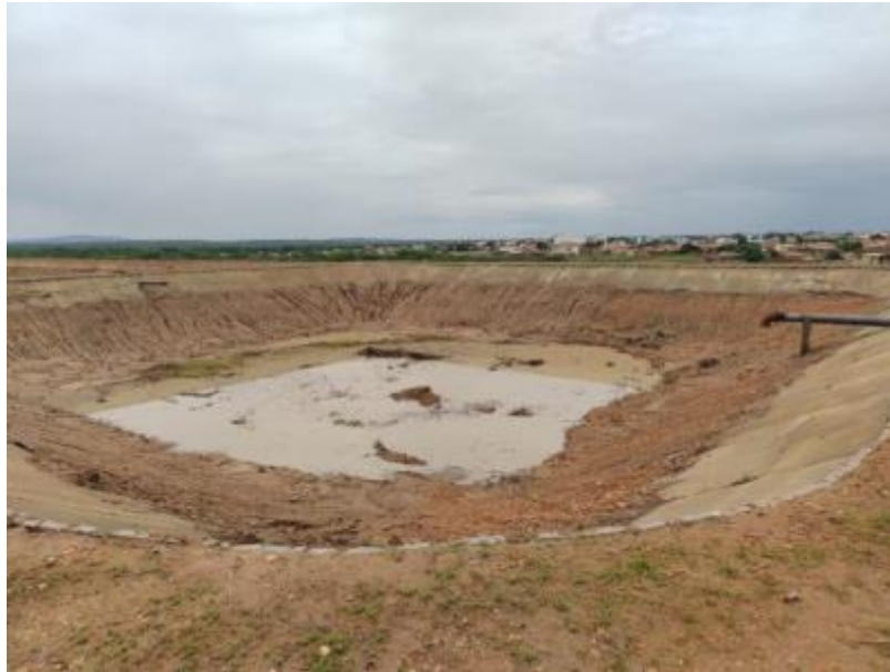
Figura 349 – ETE, Lagoa de Estabilização Fonte: INSTITUTO GESOIS, 2021.
