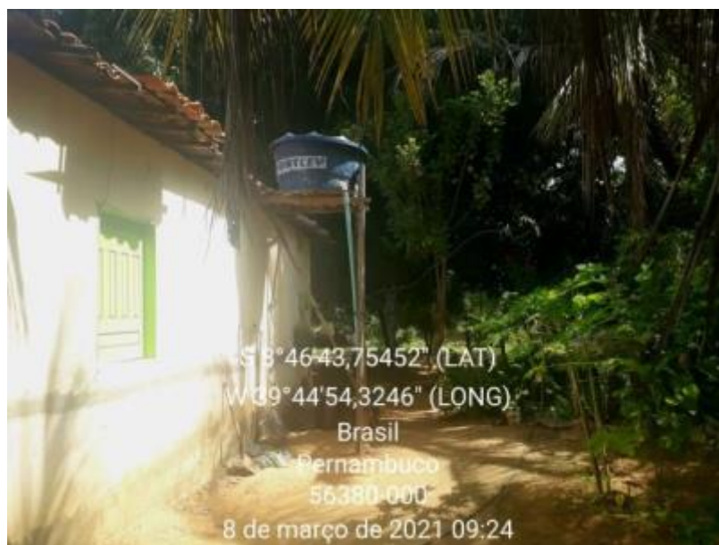
Figura 243 – Caixa D'água 500 L Fonte: INSTITUTO GESOIS, 2021.
