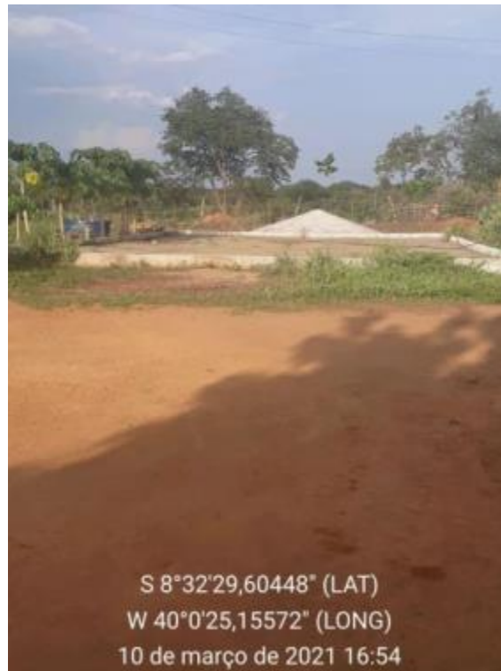
Figura 36 – Cisterna Calçadão Fonte: INSTITUTO GESOIS, 2021.
