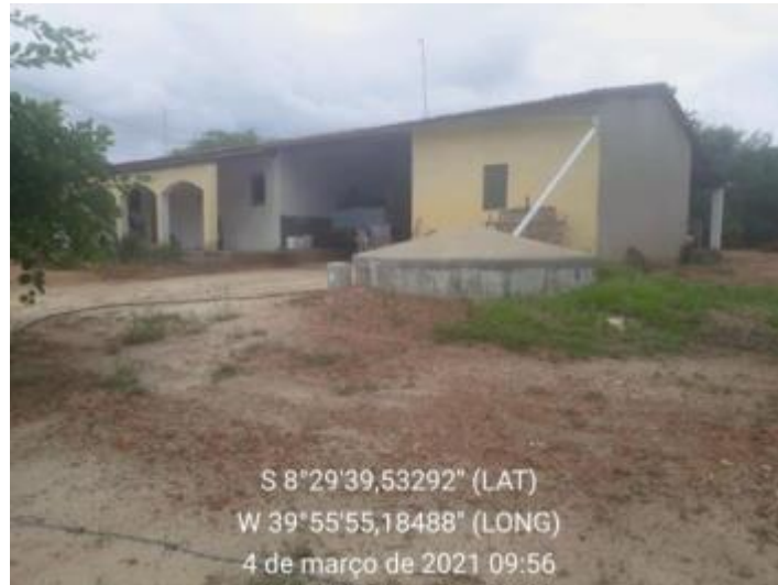
Figura 70 – Cisterna Fonte: INSTITUTO GESOIS, 2021.
