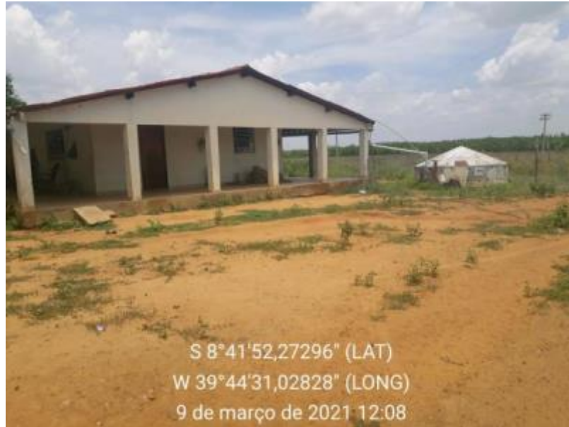
Figura 57 – Cisterna Fonte: INSTITUTO GESOIS, 2021.
