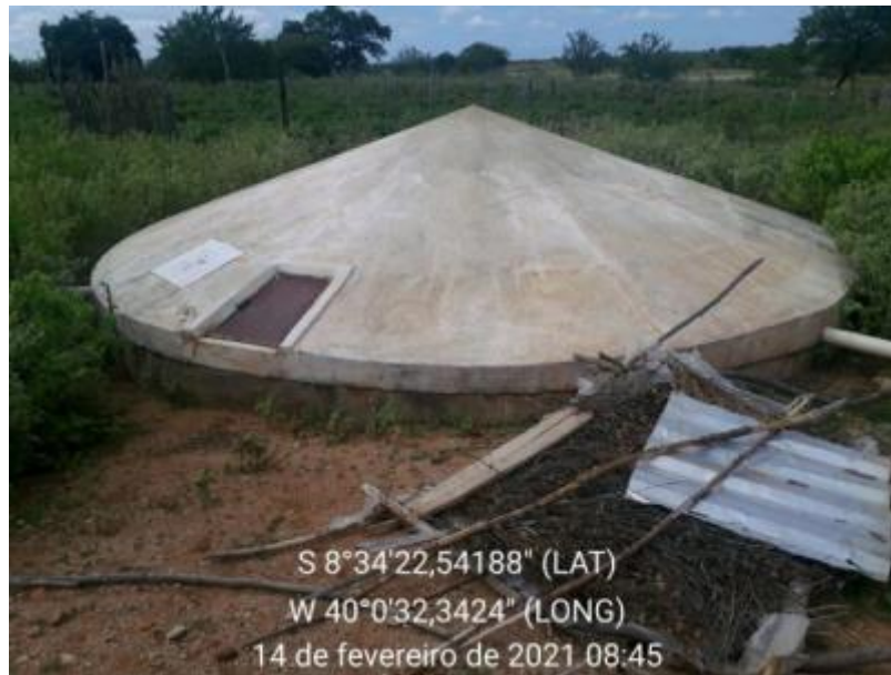
Figura 117 – Cisterna Fonte: INSTITUTO GESOIS, 2021.
