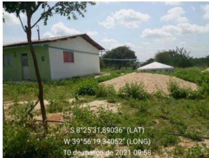
Figura 103 – Cisterna Fonte: INSTITUTO GESOIS, 2021.
