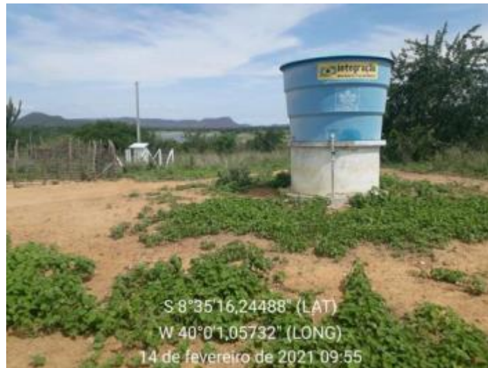
Figura 115 – Reservatório Fonte: INSTITUTO GESOIS, 2021.
