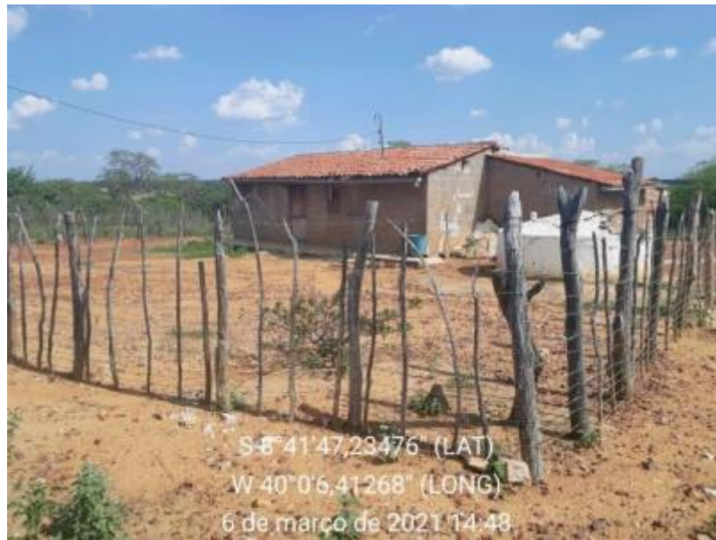
Figura 153 – Cisterna Fonte: INSTITUTO GESOIS, 2021.
