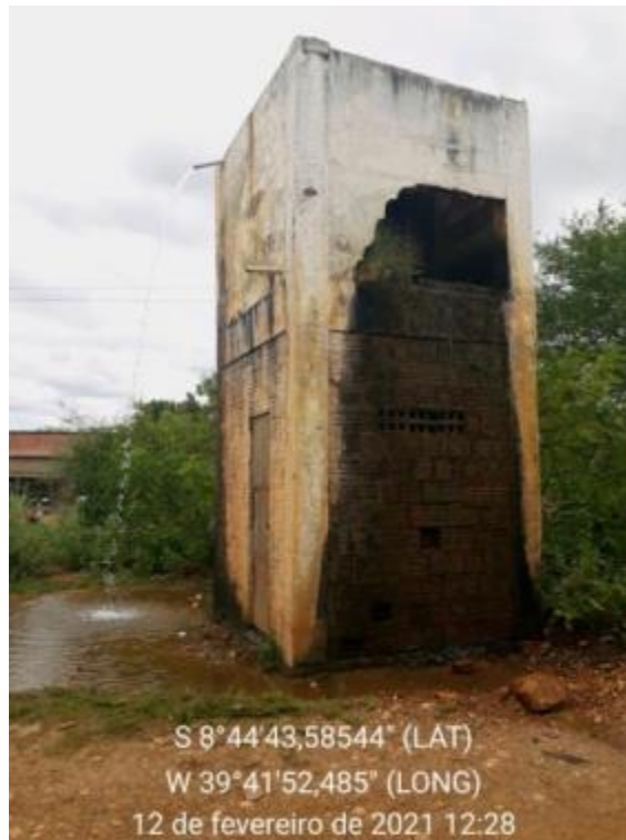
Figura 113 – Reservatório Serrote (CODEVASF) Fonte: INSTITUTO GESOIS, 2021.
