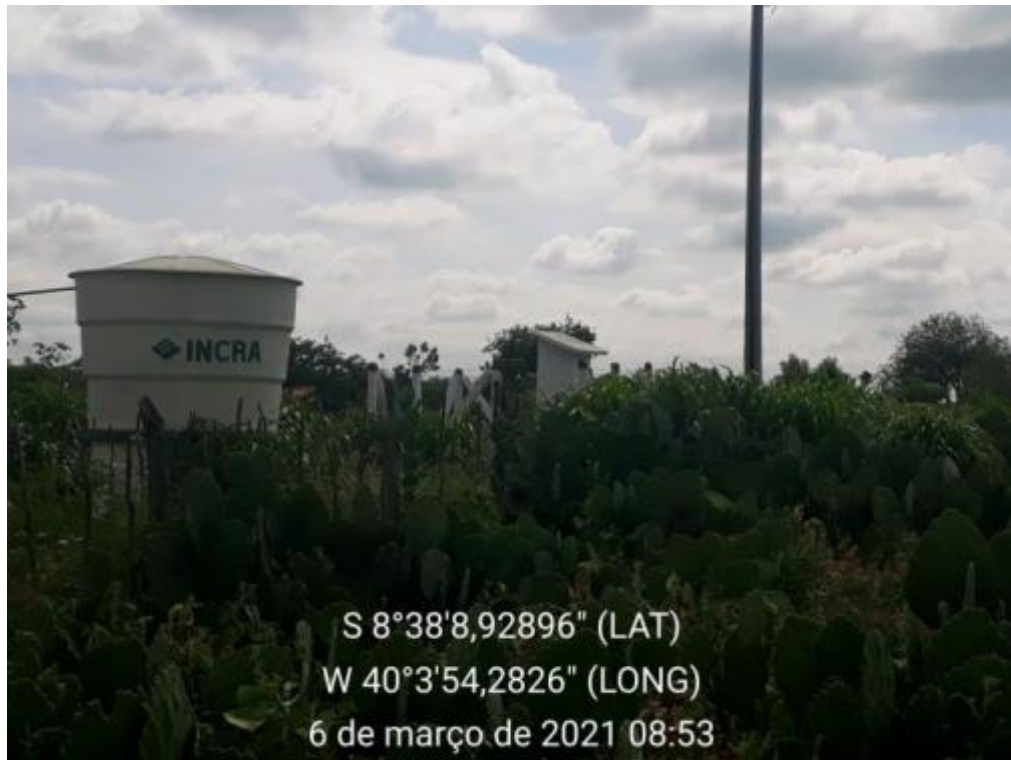
Figura 157 – Poço, Reservatório 10.000 L Fonte: INSTITUTO GESOIS, 2021.
