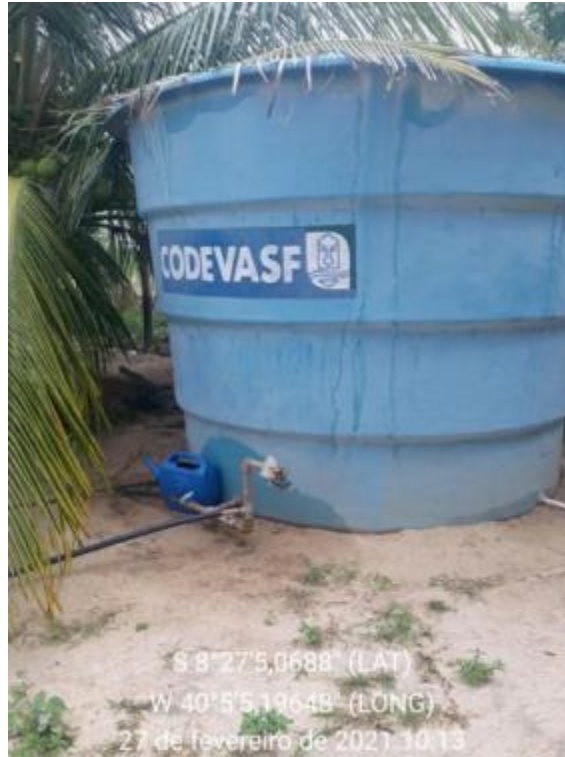
Figura 48 – Reservatório, 5.000 L, e Poço Subterrâneo 1.000 L/h Fonte: INSTITUTO GESOIS, 2021.
