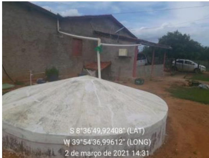
Figura 150 – Cisterna Fonte: INSTITUTO GESOIS, 2021.
