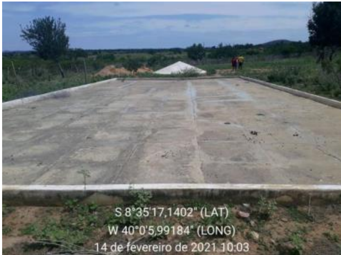
Figura 119 – Cisterna Calçadão Fonte: INSTITUTO GESOIS, 2021.
