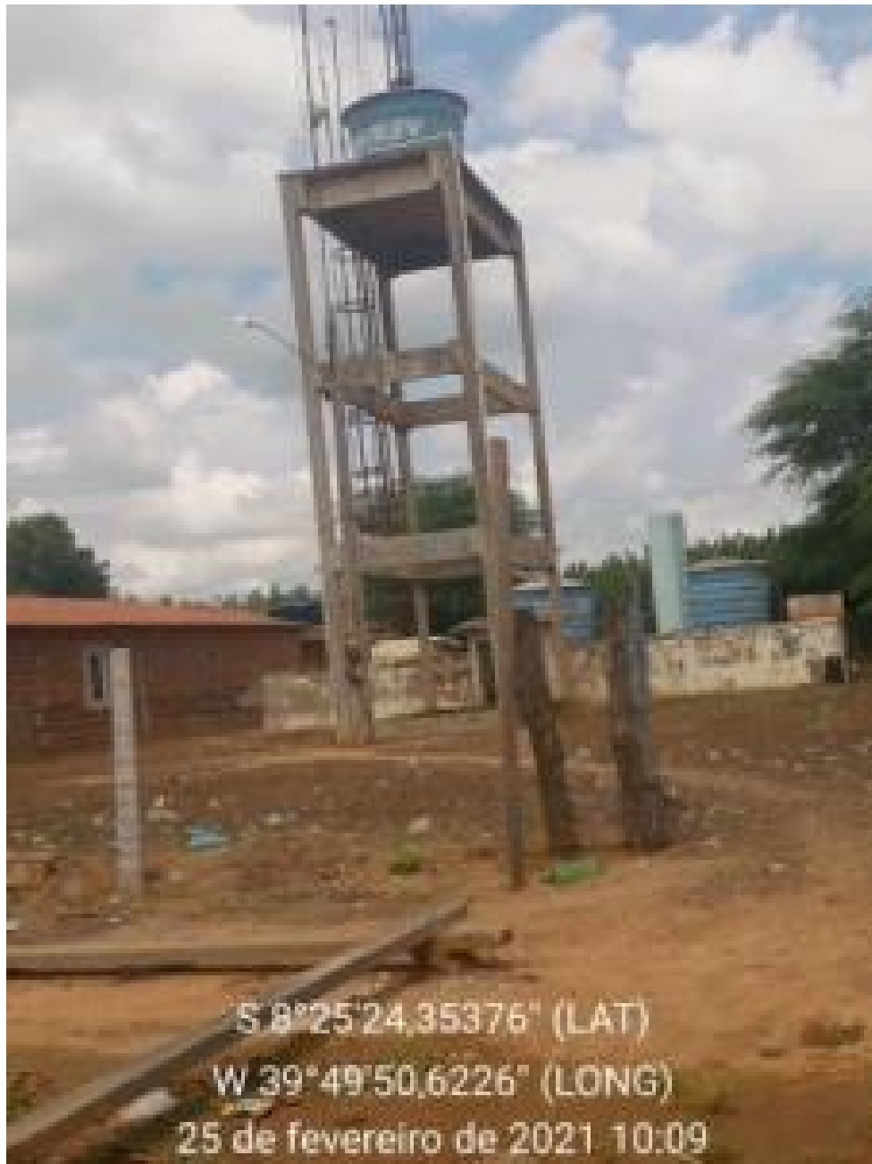
Figura 336 – Reservatório Fonte: INSTITUTO GESOIS, 2021.
