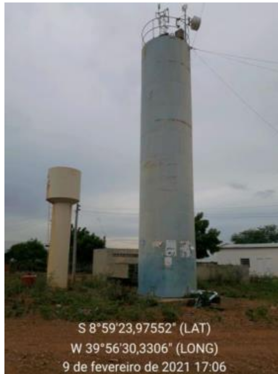
Figura 193 – Reservatório Fonte: INSTITUTO GESOIS, 2021.
