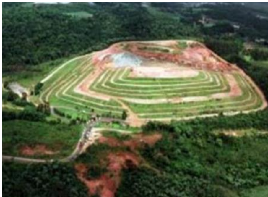
Figura 390– Aterro Sanitário. Fonte: GESOIS, 2017.
