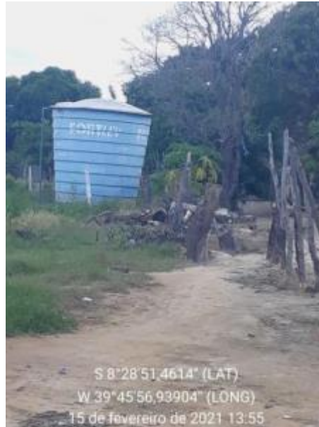
Figura 301 – Reservatório Fonte: INSTITUTO GESOIS, 2021.
