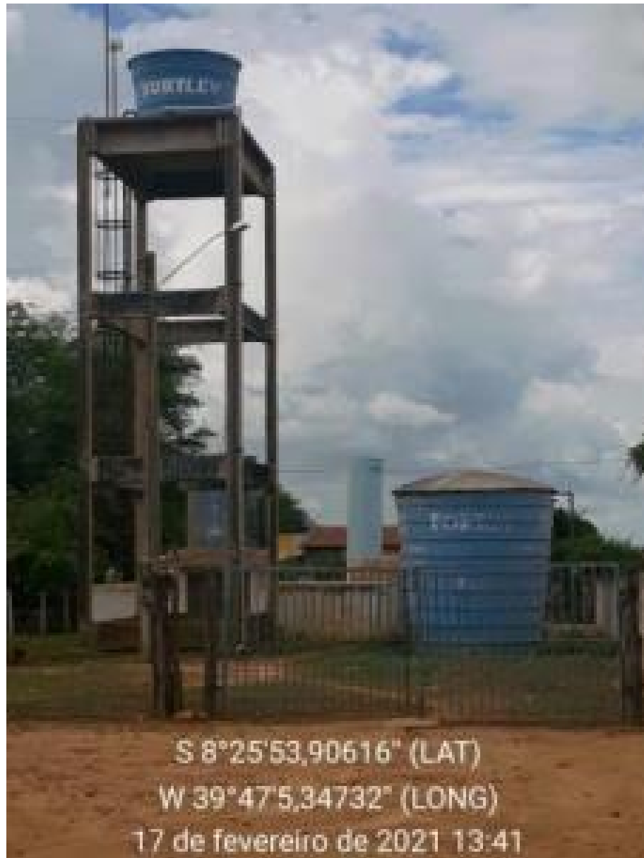
Figura 328 – Reservatório Fonte: INSTITUTO GESOIS, 2021.
