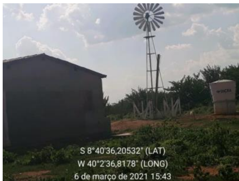
Figura 184 – Poço Catavento Fonte: INSTITUTO GESOIS, 2021.
