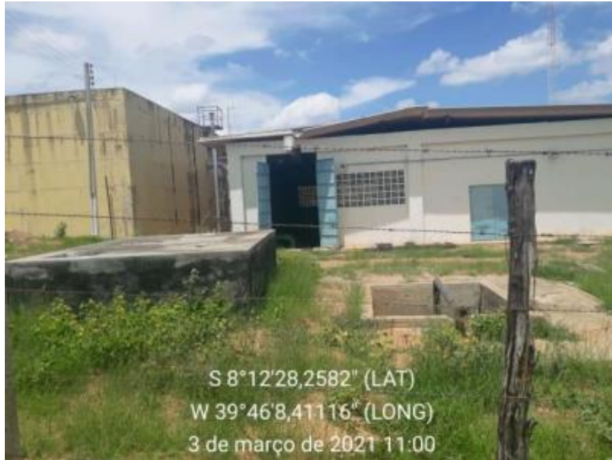
Figura 40 – Sistema de Bombeamento da Adutora do Oeste Fonte: INSTITUTO GESOIS, 2021.
