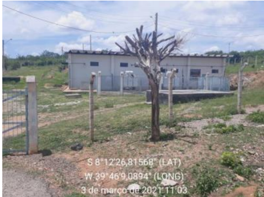
Figura 38 – Estação da Adutora do Oeste, em Parnamirim, com 35 km para Povoado de Urimamã Fonte: INSTITUTO GESOIS, 2021.
