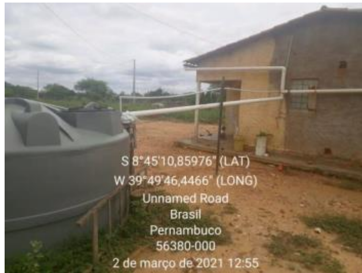
Figura 146 – Cisterna Fonte: INSTITUTO GESOIS, 2021.
