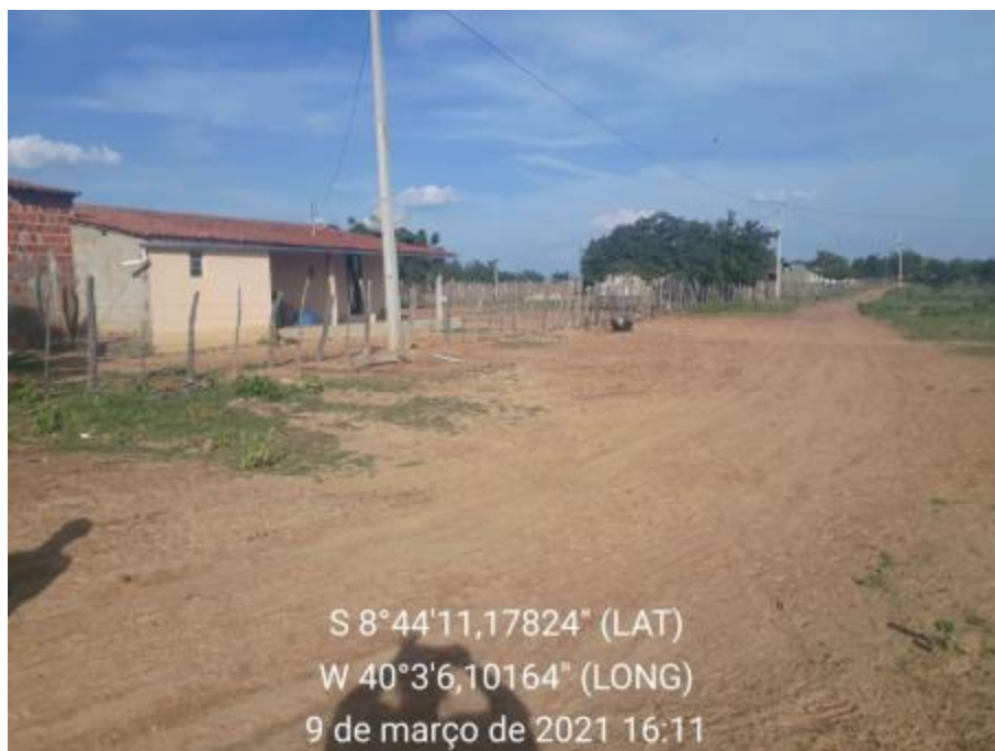
Figura 440 - Vias Assentamento Jatubarana Fonte: INSTITUTO GESOIS, 2020.
