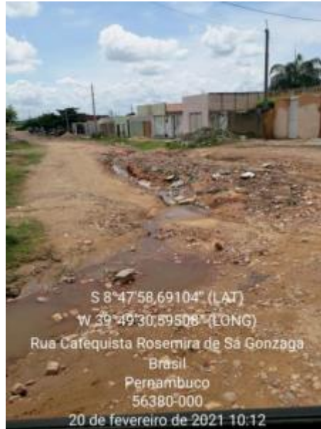
Figura 353 – Esgoto a Céu Aberto Fonte: INSTITUTO GESOIS, 2021.
