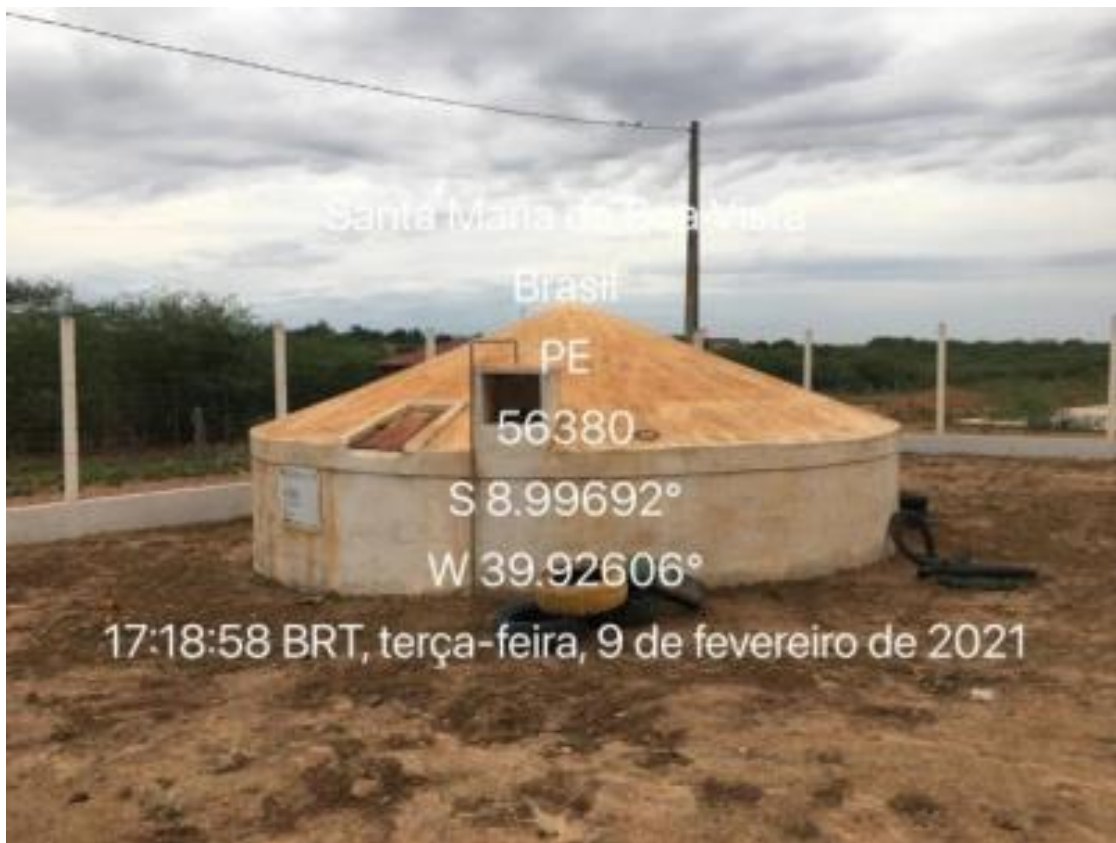
Figura 201 – Cisterna Fonte: INSTITUTO GESOIS, 2021.
