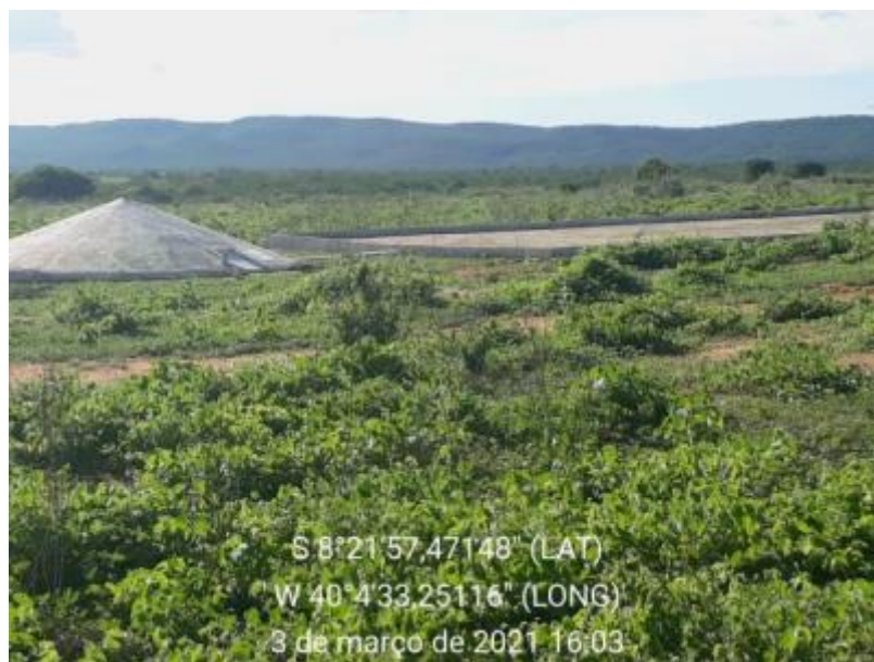
Figura 69 – Cisterna Calçadão, 52.000 L Fonte: INSTITUTO GESOIS, 2021.
