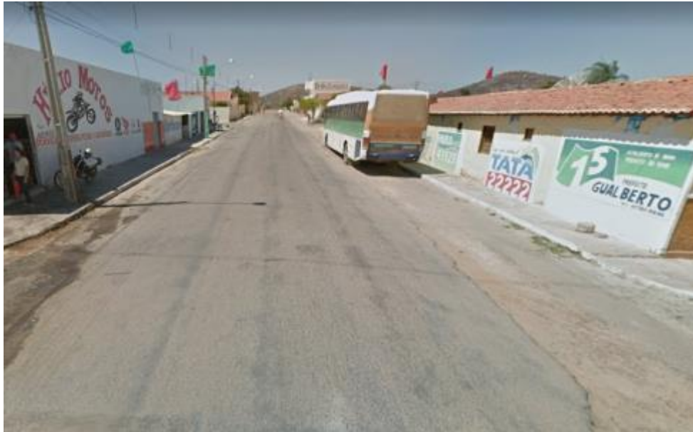
Figura 415 - Aspecto de via com pavimentação asfáltica Fonte: INSTITUTO GESOIS, 2020.
