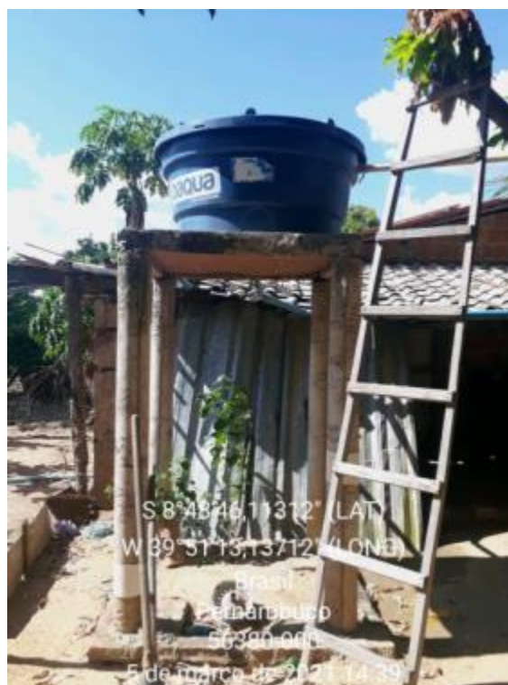
Figura 248 – Reservatório Fonte: INSTITUTO GESOIS, 2021.
