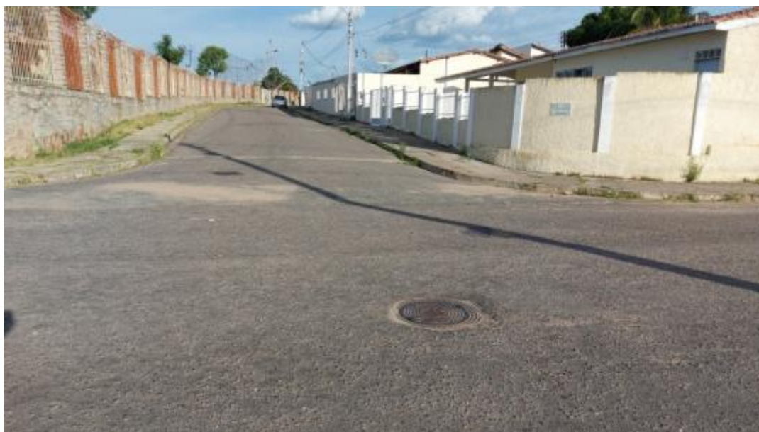
Figura 331 – Vista Ampla de Cruzamento (Bairro Itaparica) Fonte: INSTITUTO GESOIS, 2020.
