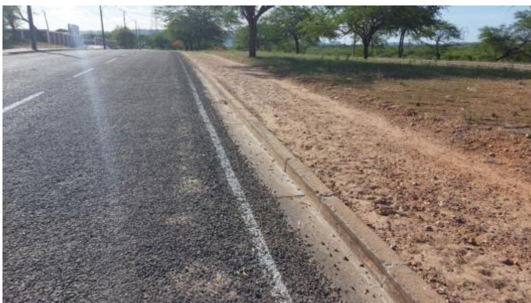
Figura 318 – Sarjeta Localizada na Avenida Eletrobrás Sul Fonte: INSTITUTO GESOIS, 2020.
