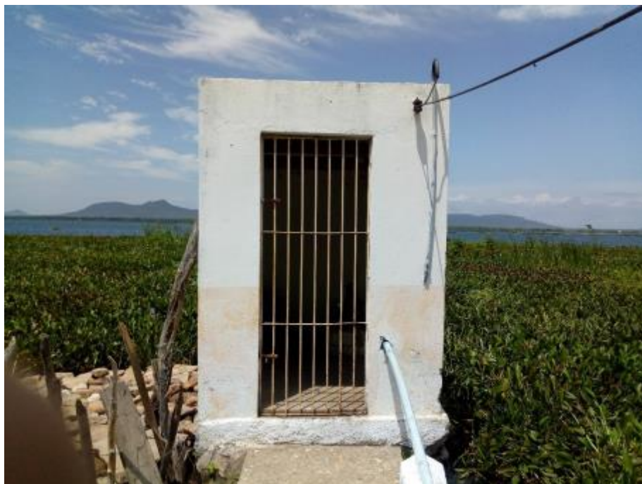
Figura 159 – Captação no Rio São Francisco Fonte: INSTITUTO GESOIS, 2021.
