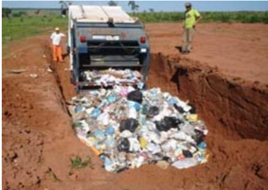
Figura 263 – Aterro Controlado. Fonte: INSTITUTO GESOIS, 2017.
