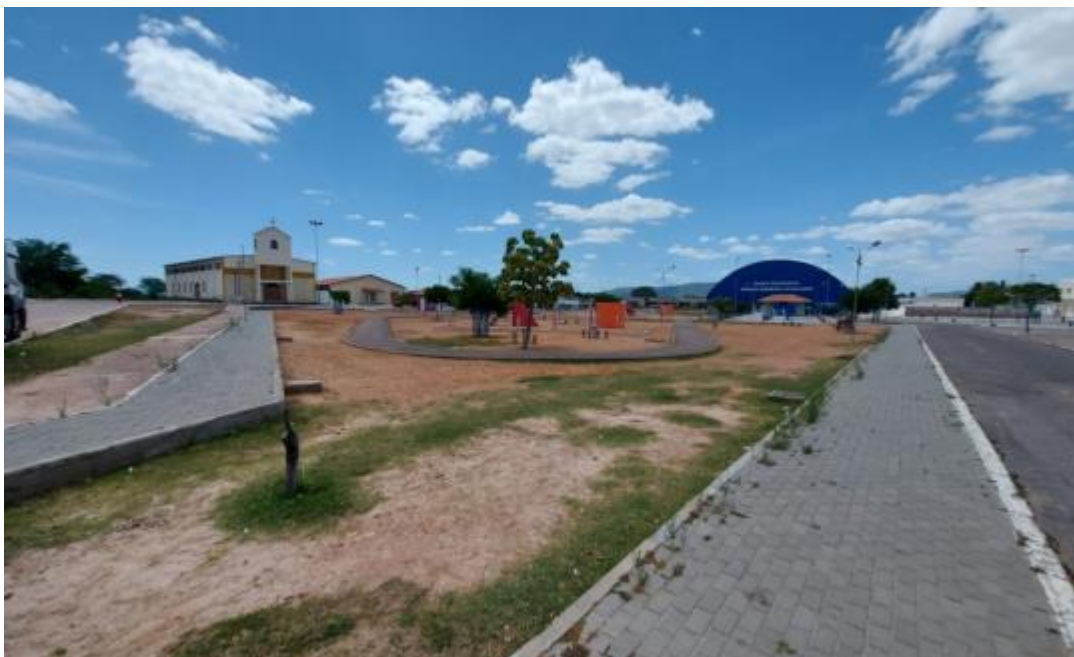
Figura 303 – Aspecto das Vias e Pavimentação na Área do Ginásio Poliesportivo Fonte: INSTITUTO GESOIS, 2020.
