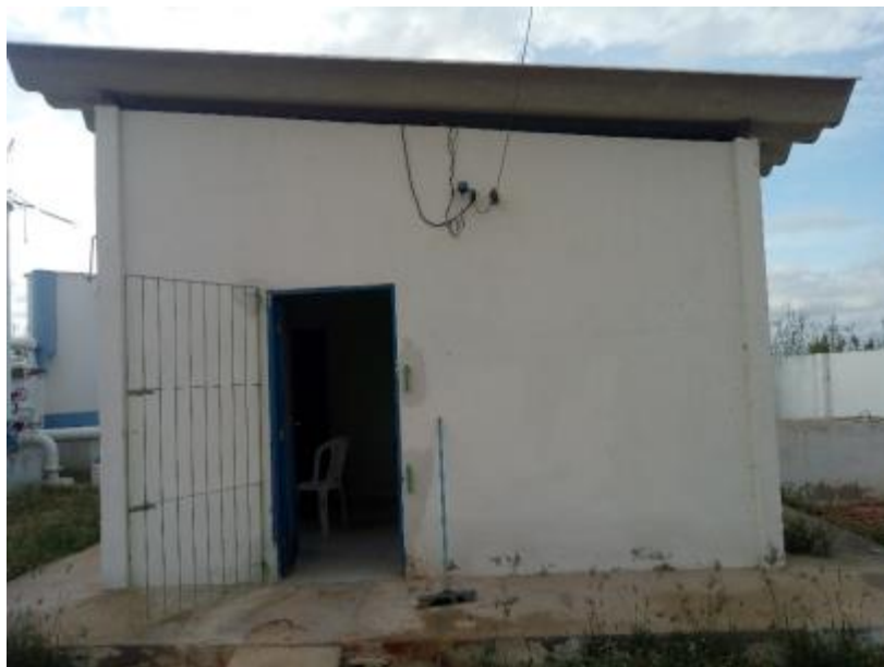
Figura 59 – ETA na Localidade Volta do Moxotó Fonte: INSTITUTO GESOIS, 2021.
