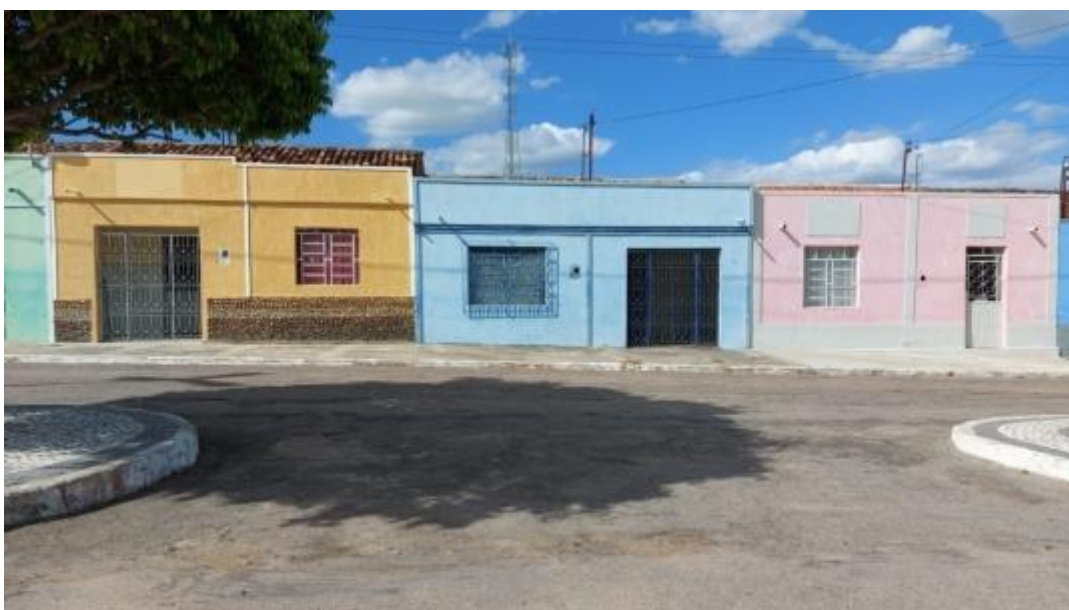
Figura 345 – Vias Centrais no Distrito de Volta do Moxotó sem Elementos de Drenagem Fonte: INSTITUTO GESOIS, 2020.
