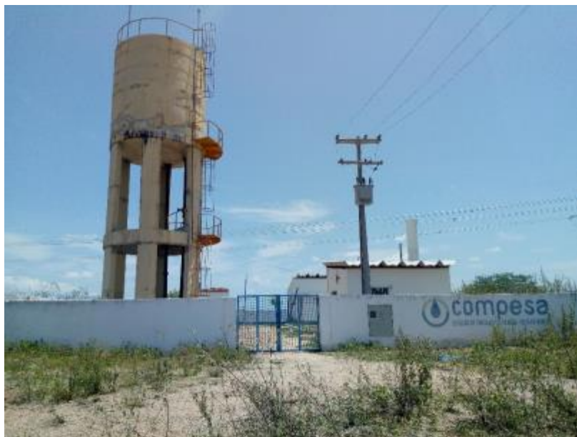
Figura 68 – ETA na Localidade Volta do Moxotó Fonte: INSTITUTO GESOIS, 2021.
