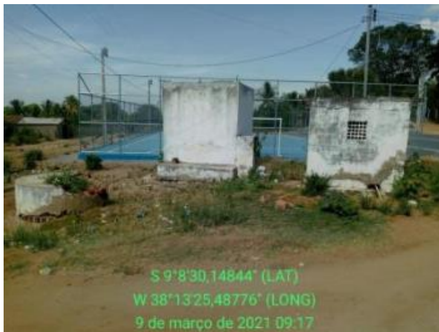
Figura 115 – Poço Subterrâneo Aldeia Bem Querere de Cima Fonte: INSTITUTO GESOIS, 2021.
