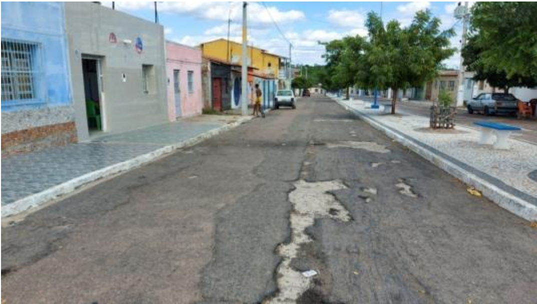
Figura 342 – Detalhe de Desgaste nas Vias Centrais de Volta do Moxotó Fonte: INSTITUTO GESOIS, 2020.
