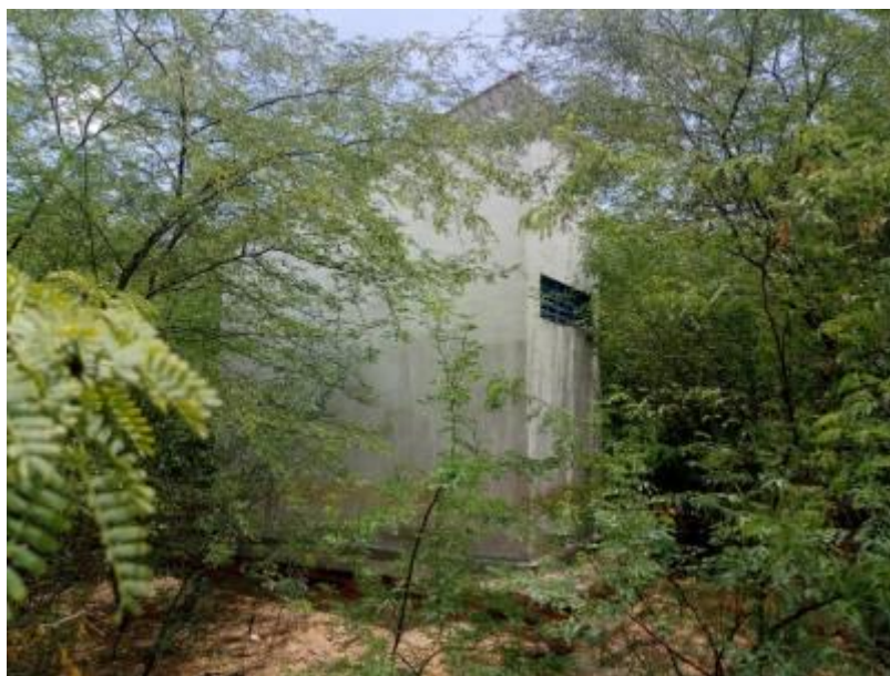
Figura 209 – Captação do SAA CODEVASF Desativada Fonte: INSTITUTO GESOIS, 2021.
