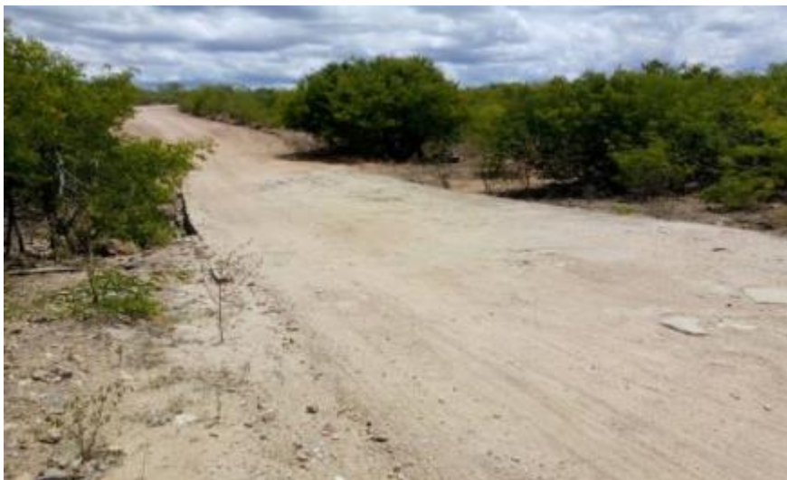
Figura 358 – Passagem Molhada na Localidade Barra do Moxotó Fonte: INSTITUTO GESOIS, 2020.
