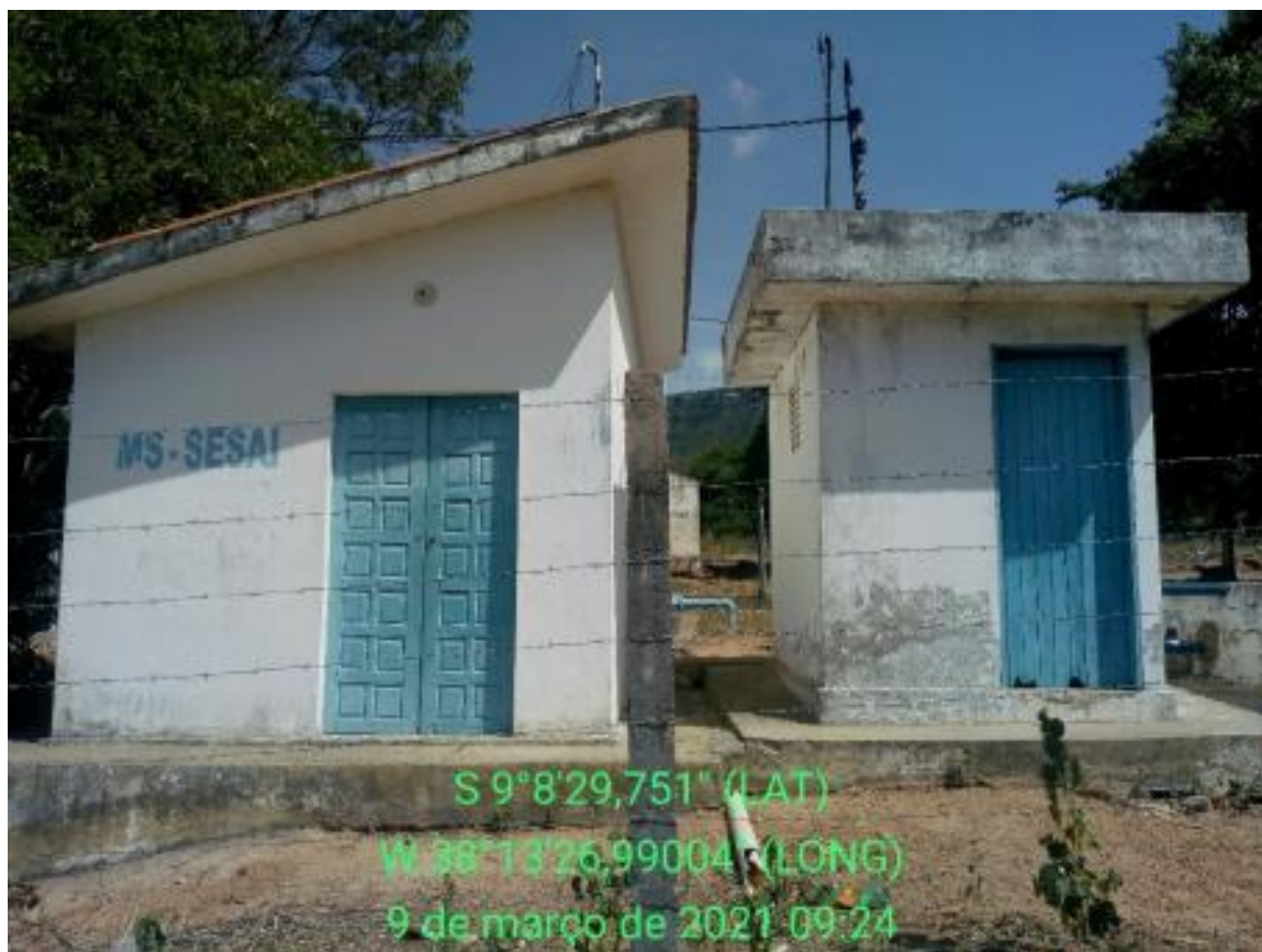
Figura 117 – ETA Paralisada na Aldeia Bem Querer de Cima Fonte: INSTITUTO GESOIS, 2021.
