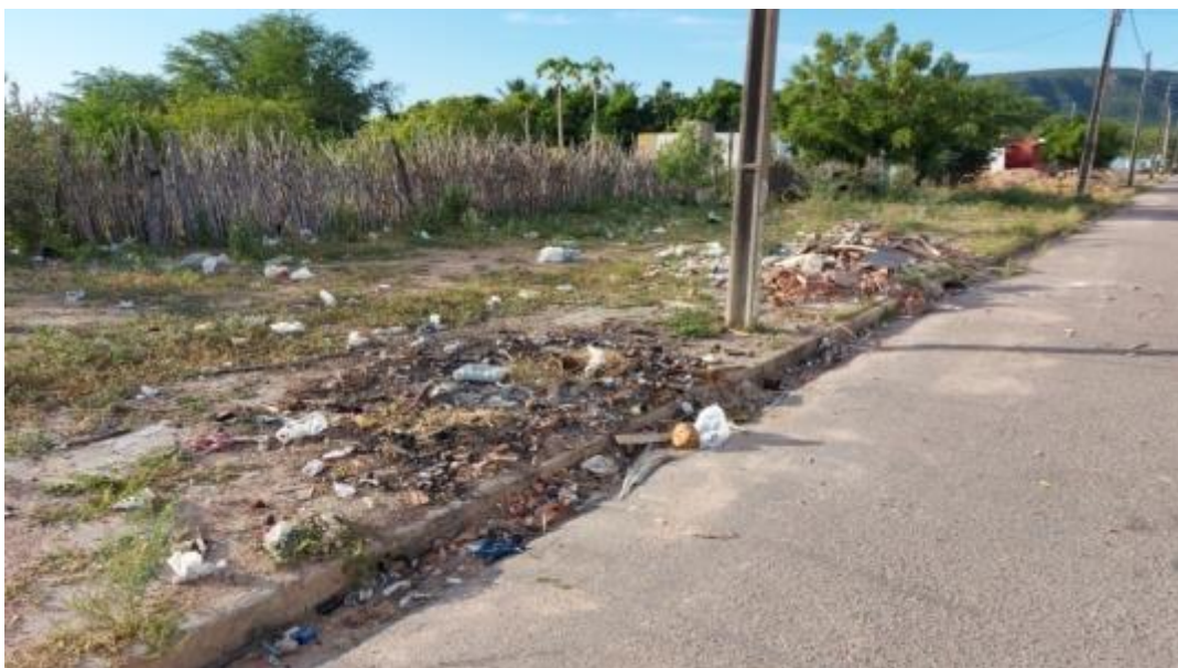
Figura 334 – Prejuízo ao Sistema de Microdrenagem Causado por Descarte Inadequado de Resíduos Sólidos Fonte: INSTITUTO GESOIS, 2020.
