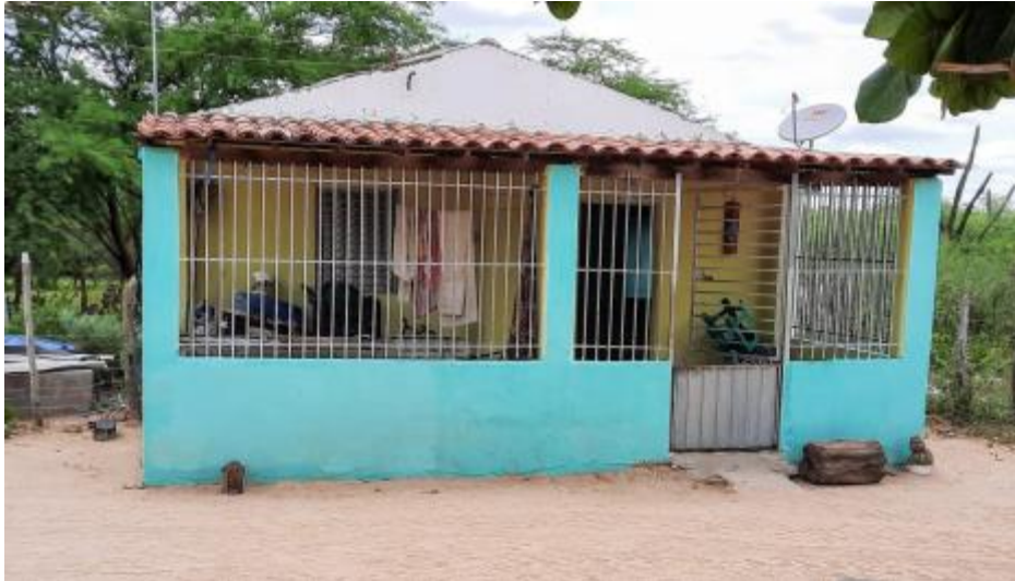
Figura 92 – Residência Comunidade Maçu Fonte: INSTITUTO GESOIS, 2021.
