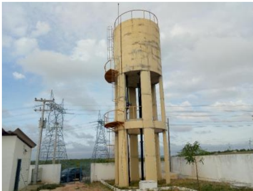
Figura 57 – ETA na Localidade Volta do Moxotó Fonte: INSTITUTO GESOIS, 2021.
