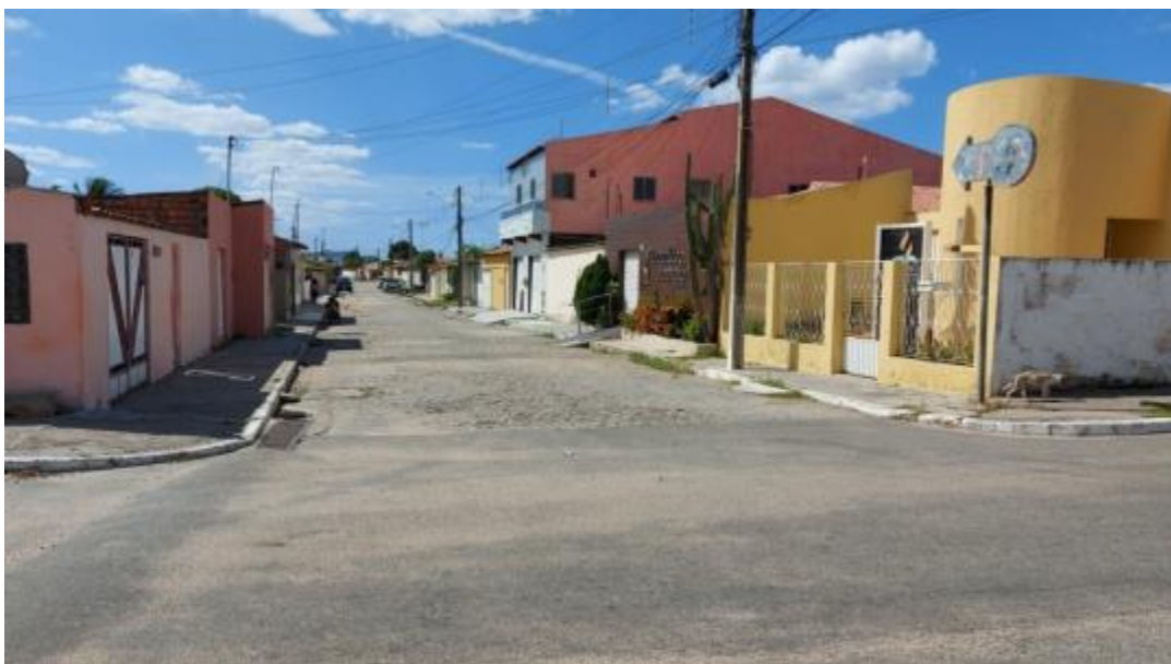
Figura 317 – Presença de Rampas ao Longo do Meio-fio Fonte: INSTITUTO GESOIS, 2020.
