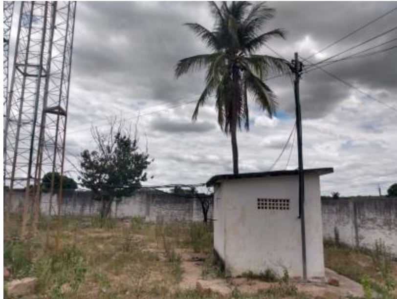
Figura 79 – Caixa D'água Inoperante da Localidade Volta do Moxotó Fonte: INSTITUTO GESOIS, 2021.
