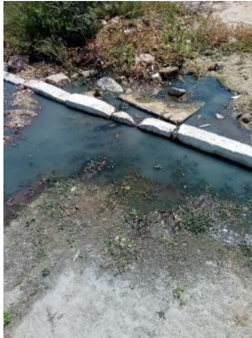
Figura 227 – Lançamento de Esgoto às Margens do Rio Moxotó na Volta do Moxotó
