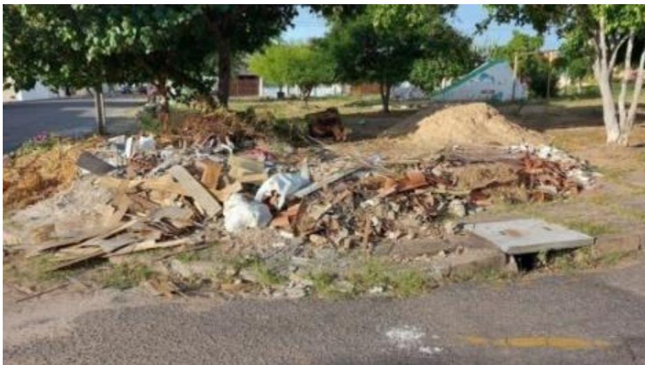
Figura 324 – Resíduos de Demolição Obstruindo a Sarjeta Fonte: INSTITUTO GESOIS, 2020.
