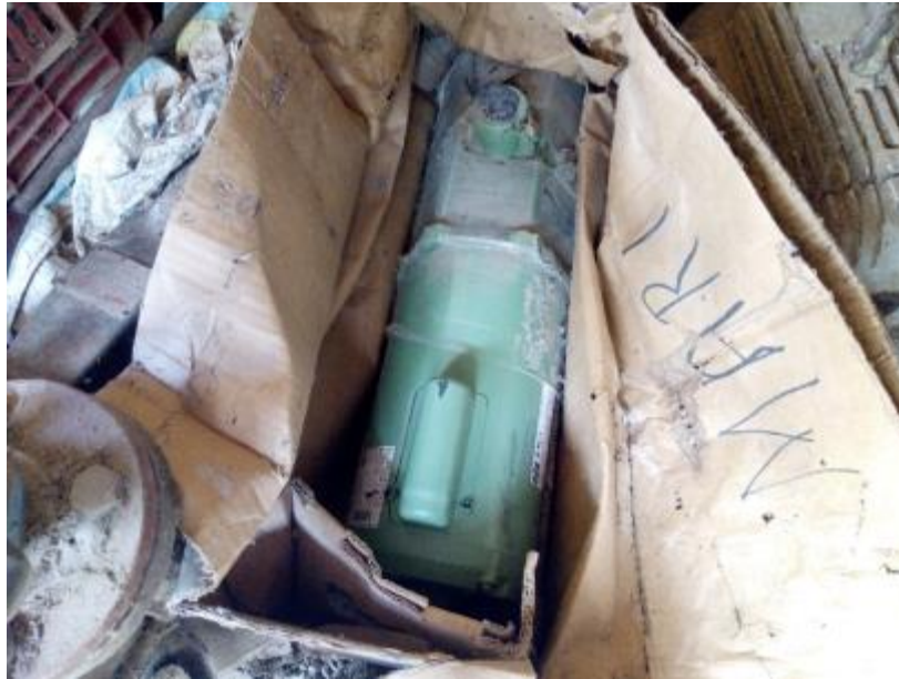
Figura 169 – Bomba D'água da Captação Fonte: INSTITUTO GESOIS, 2021.
