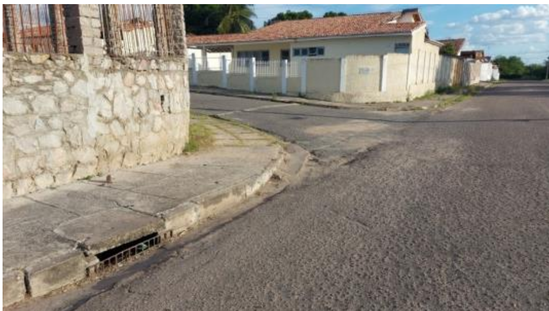
Figura 332 – Detalhe da Boca de Lobo (Bairro Itaparica) Fonte: INSTITUTO GESOIS, 2020.
