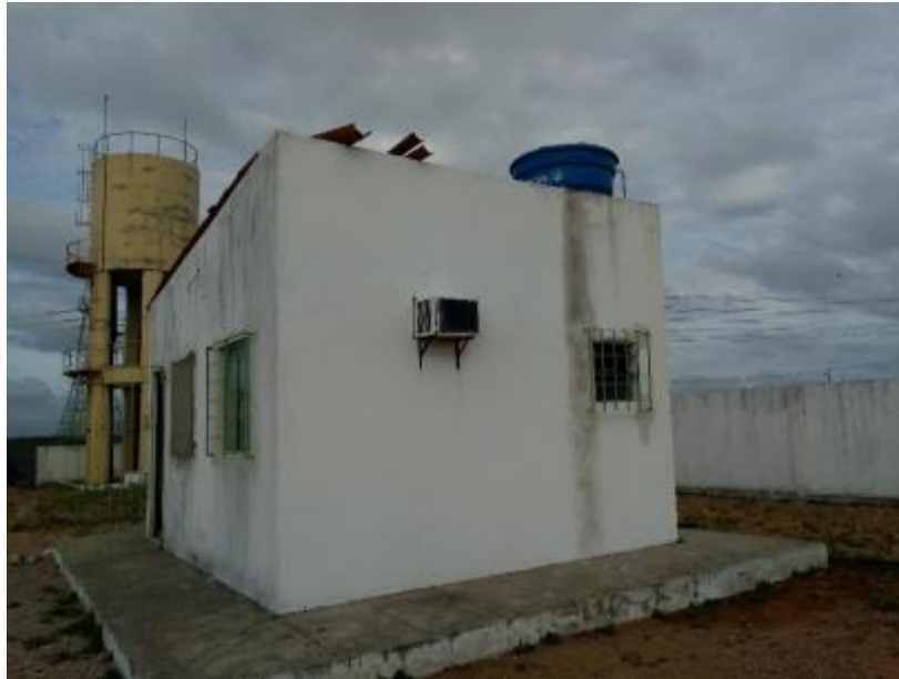
Figura 66 – ETA na Localidade Volta do Moxotó Fonte: INSTITUTO GESOIS, 2021.
