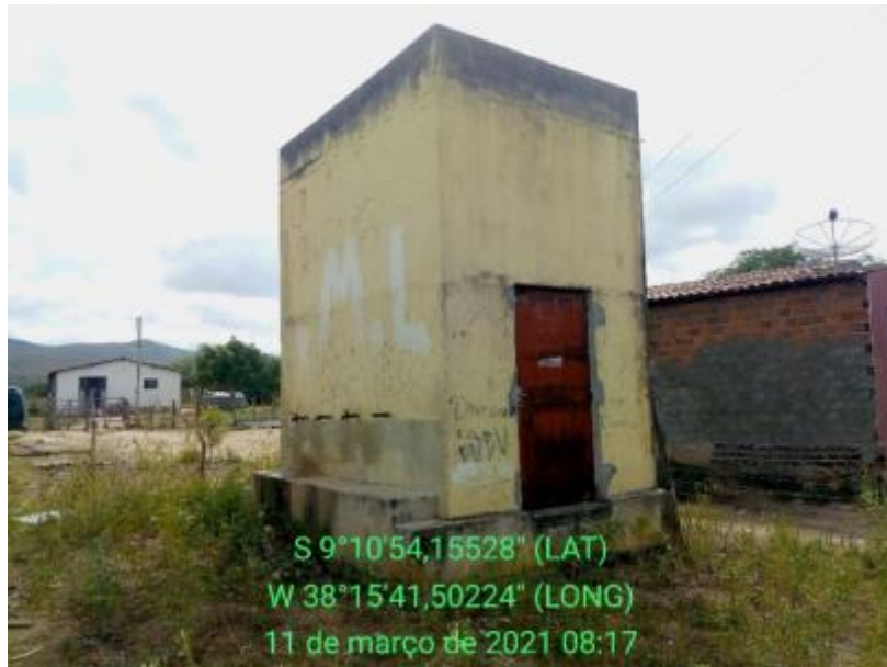
Figura 125 – Chafariz na Aldeia Caldeirão Fonte: INSTITUTO GESOIS, 2021.
