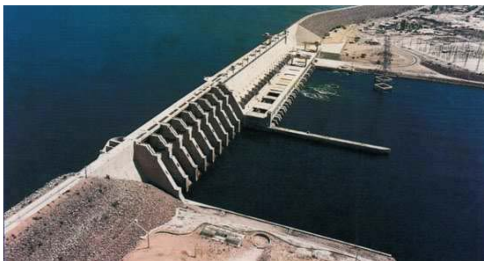
Figura 213 – Usina Hidroelétrica Luiz Gonzaga (Ex-Itaparica) Fonte: CUNHA, 2012.
