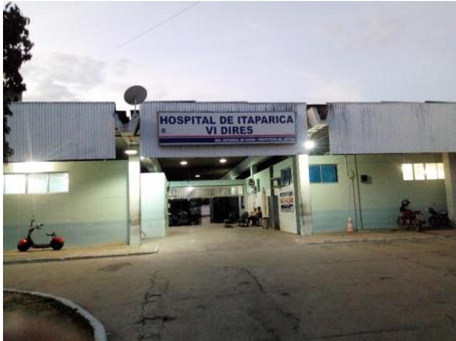
Figura 277- Hospital Municipal Fonte: INSTITUTO GESOIS, 2021.
