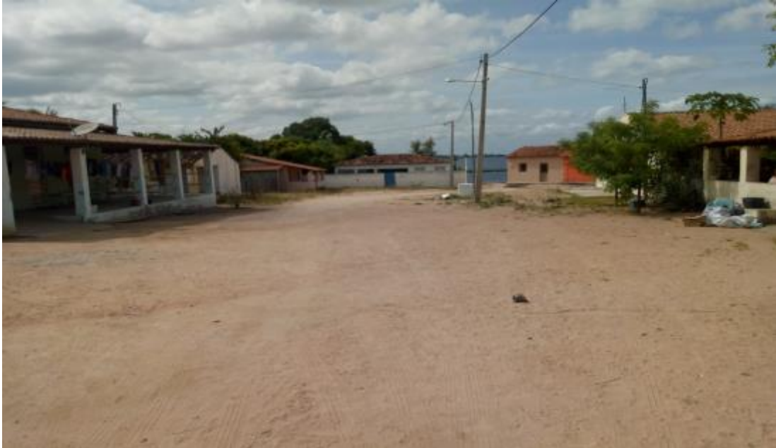
Figura 353 – Perspectiva da Via Principal e Ausência de Revestimento e Sistema de Drenagem na Localidade Mari Fonte: INSTITUTO GESOIS, 2020.
