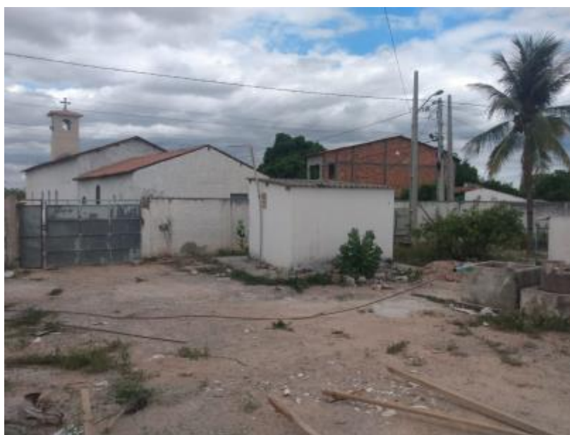
Figura 76 – Reservatório Inoperante da Volta do Moxotó Fonte: INSTITUTO GESOIS, 2021.
