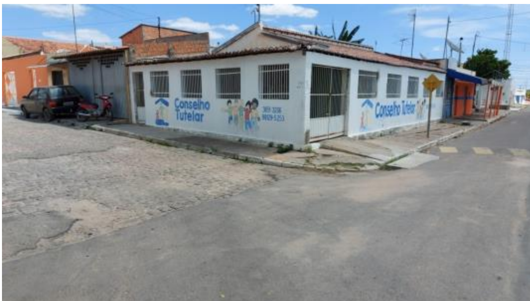
Figura 315 – Construção de Rampa na Área da Sarjeta Fonte: INSTITUTO GESOIS, 2020.
