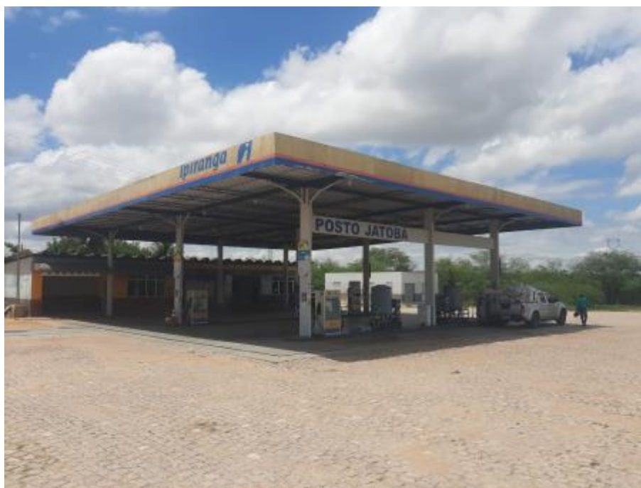
Figura 296 – Posto de Gasolina Fonte: INSTITUTO GESOIS, 2021.
