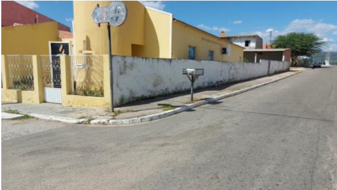
Figura 316 – Vias com Ausência de Sistema de Microdrenagem Fonte: INSTITUTO GESOIS, 2020.
