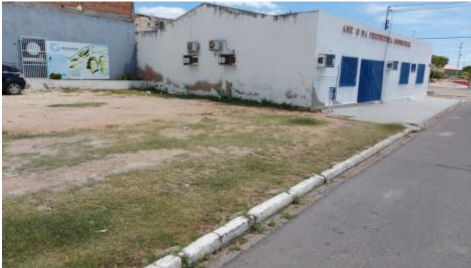
Figura 306 – Falta de Cobertura Vegetal em Lotes Vagos Fonte: INSTITUTO GESOIS, 2020.
