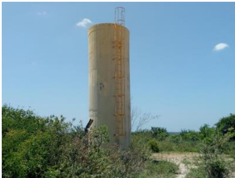
Figura 85 – Reservatório Desativado na Aldeia Pankaiwká Fonte: INSTITUTO GESOIS, 2021.
