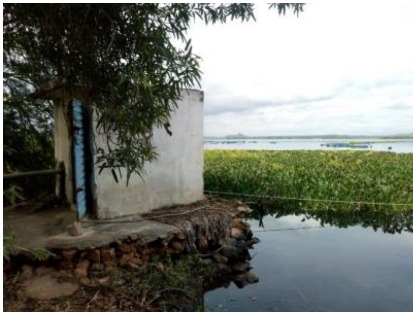
Figura 183 – Captação de Água Fonte: INSTITUTO GESOIS, 2021.
