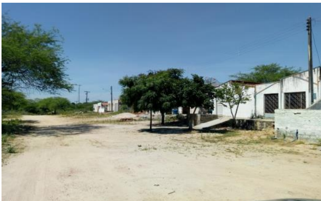
Figura 364 – Ausência de Pavimentação e Sistema de Drenagem na Localidade Maçu
