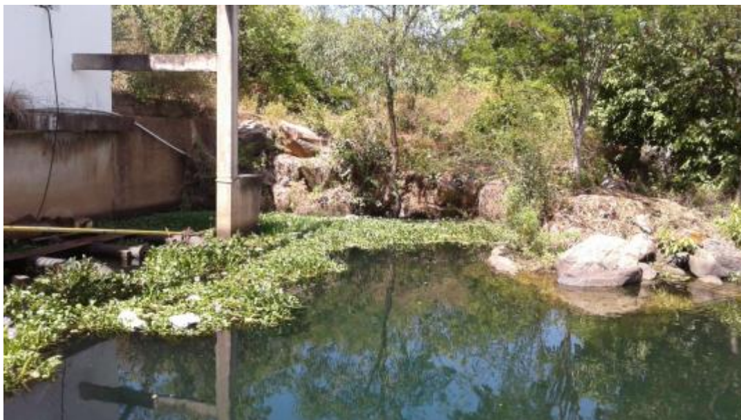
Figura 27 – Captação COMPESA Fonte: INSTITUTO GESOIS, 2021.
