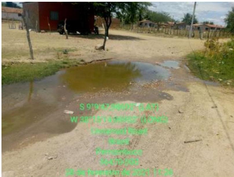
Figura 103 – Vazamento de Água na Localidade Logradouro Fonte: INSTITUTO GESOIS, 2021.
