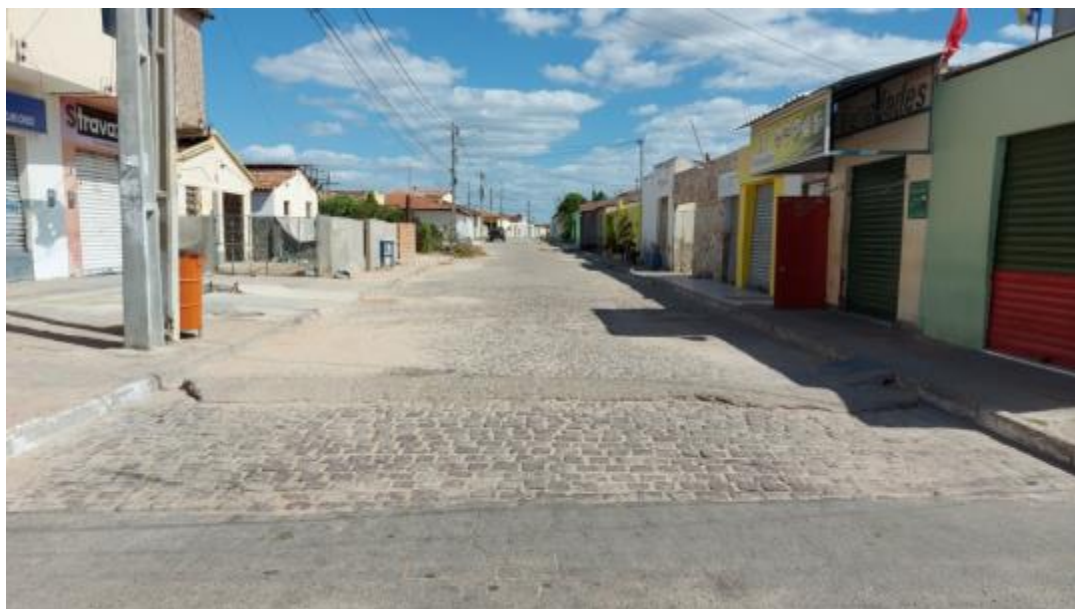
Figura 311 – Via da Sede com Ausência de Microdrenagem Fonte: INSTITUTO GESOIS, 2020.
