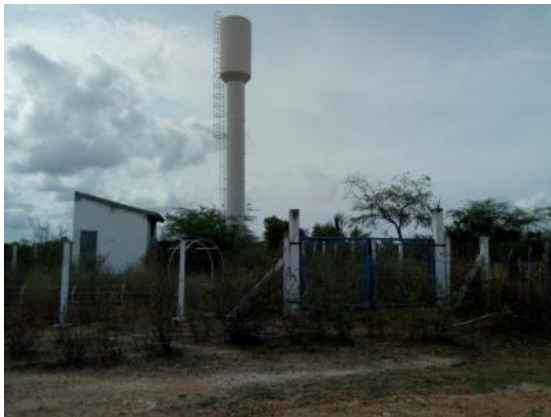
Figura 192 – REL do SAA CODEVASF Inoperante Fonte: INSTITUTO GESOIS, 2021.
