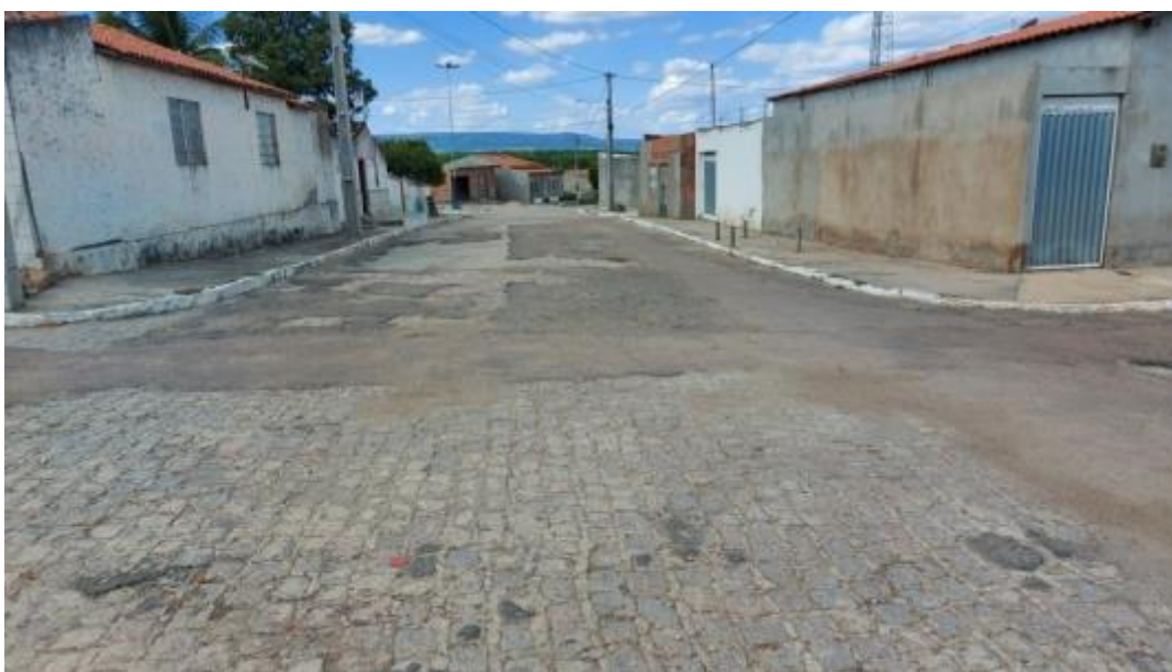
Figura 339 – Aspecto Geral de Vias no Distrito de Volta do Moxotó Fonte: INSTITUTO GESOIS, 2020.
