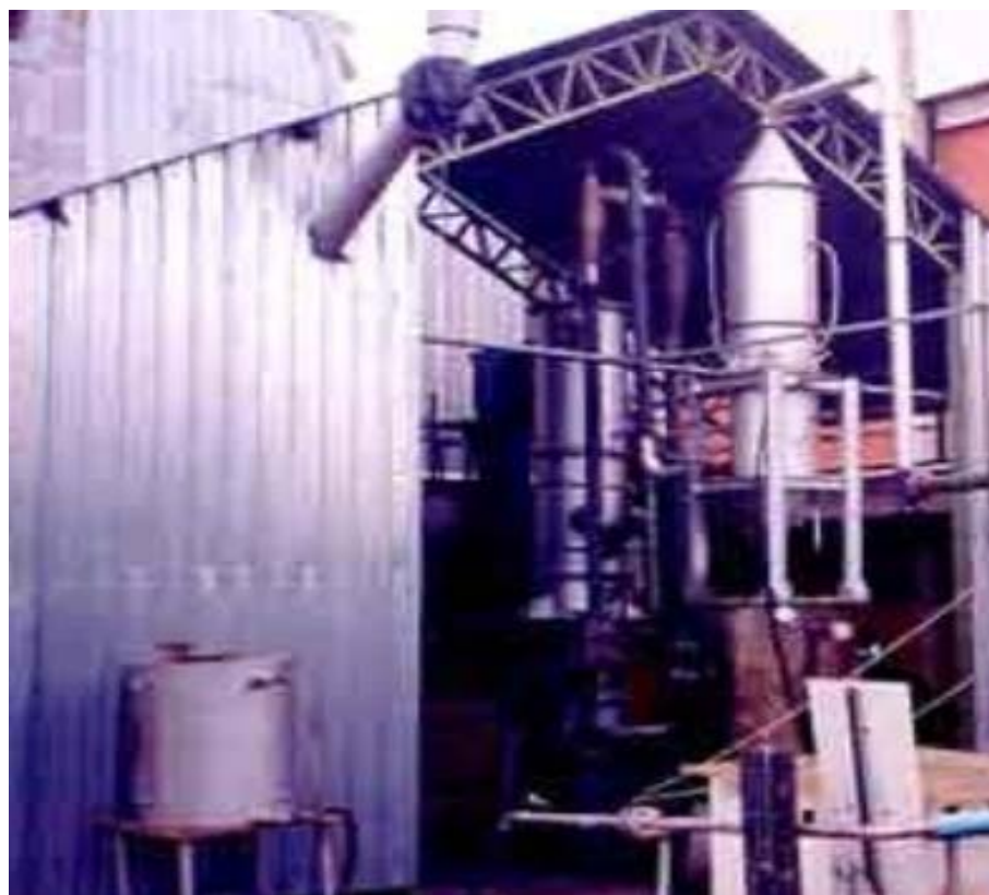
Figura 258– Planta de Pirólise com Tecnologia da UNICAMP Fonte: AMBIENTE BRASIL, 2017.
