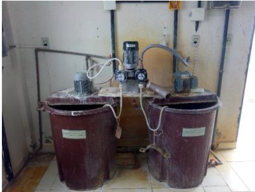
Figura 60 – ETA na Localidade Volta do Moxotó Fonte: INSTITUTO GESOIS, 2021.
