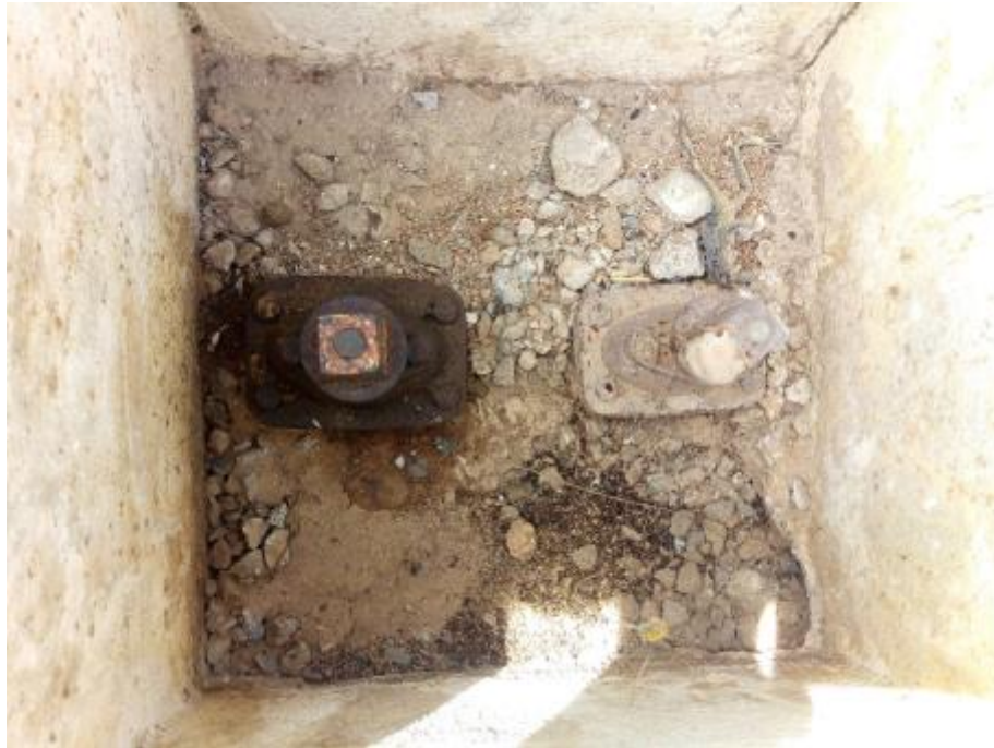
Figura 136 – Reservatório D'água no Alto da Serra Fonte: INSTITUTO GESOIS, 2021.
