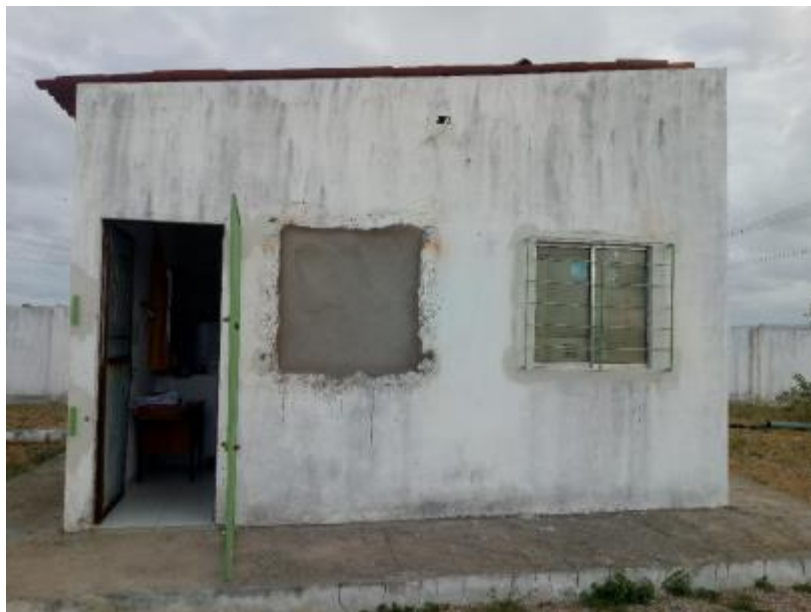
Figura 65 – ETA na Localidade Volta do Moxotó Fonte: INSTITUTO GESOIS, 2021.
