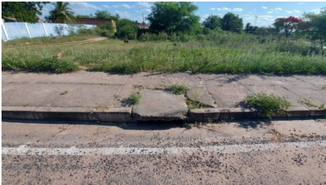
Figura 327 – Detalhe da Boca de Lobo Fonte: INSTITUTO GESOIS, 2020.
