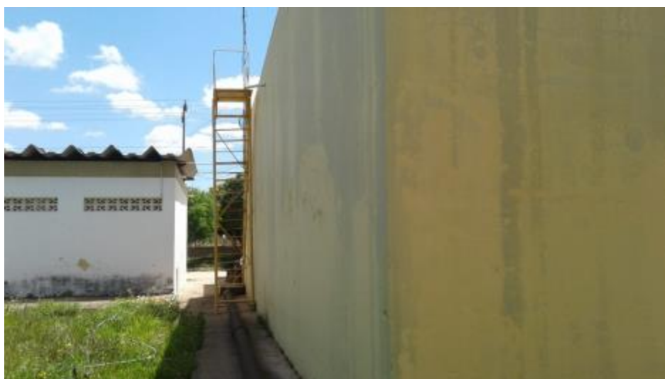
Figura 40 – Reservatório R0 Fonte: INSTITUTO GESOIS, 2021.
