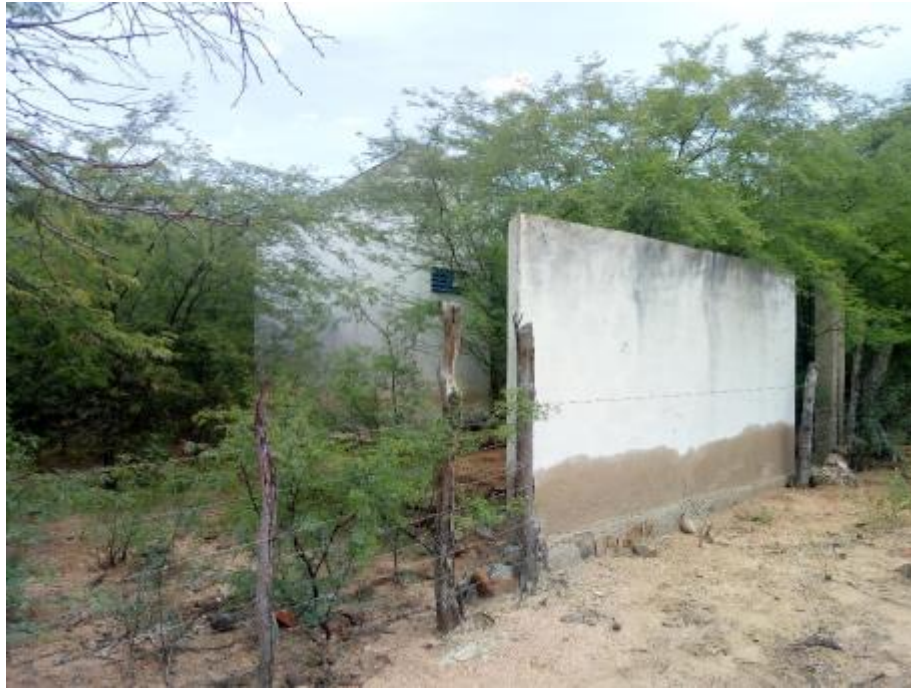
Figura 210 – Captação do SAA CODEVASF Desativada Fonte: INSTITUTO GESOIS, 2021.
