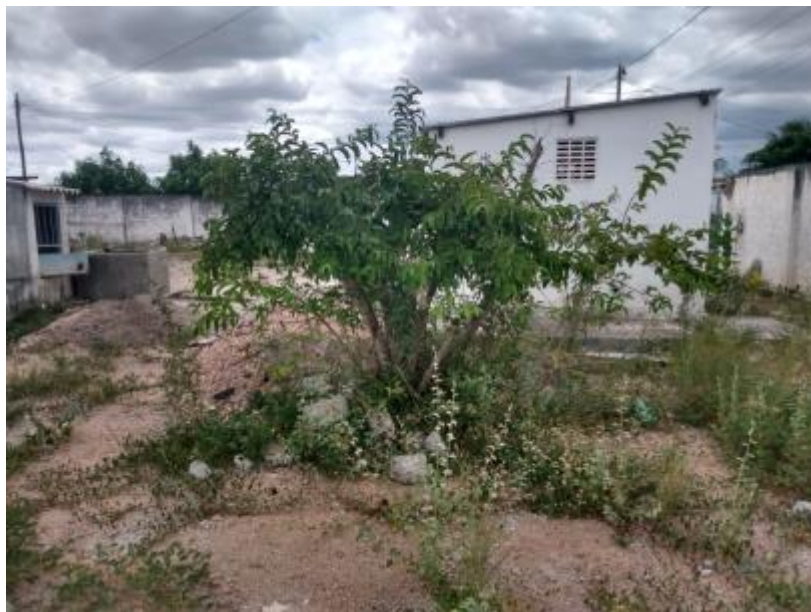
Figura 82 – Caixa D'água Inoperante da Localidade Volta do Moxotó Fonte: INSTITUTO GESOIS, 2021.
