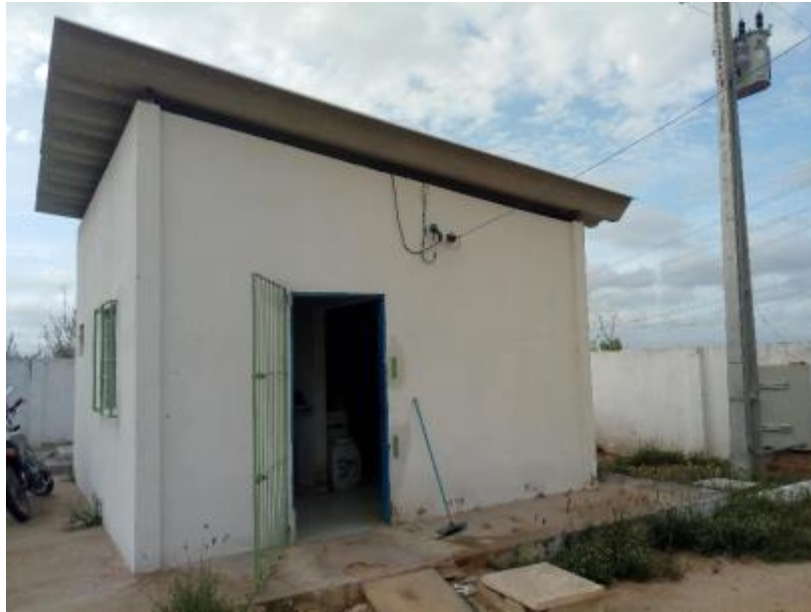
Figura 58 – ETA na Localidade Volta do Moxotó Fonte: INSTITUTO GESOIS, 2021.
