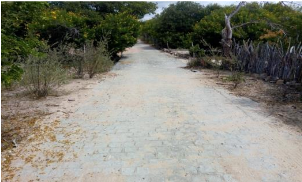
Figura 354 – Via pavimentada em Paralelepípedo na Localidade Martelo Fonte: INSTITUTO GESOIS, 2020.
