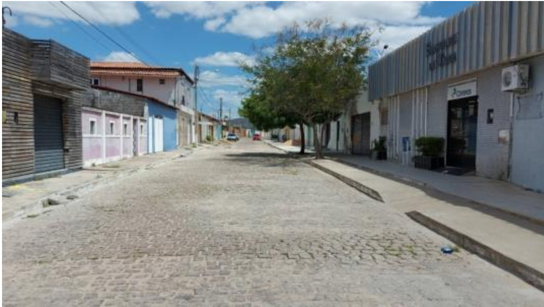
Figura 310 – Presença de Sarjeta apenas do Lado Esquerdo da Via Fonte: INSTITUTO GESOIS, 2020.
