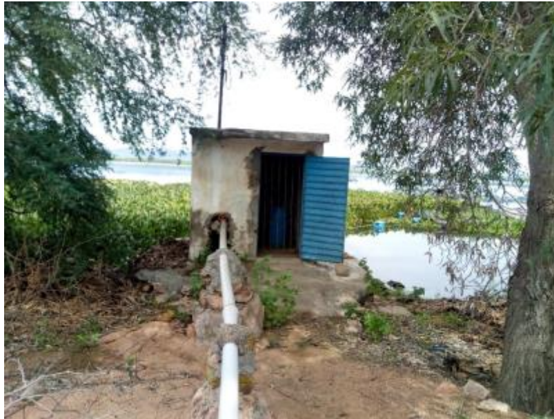
Figura 182 – Captação de Água Fonte: INSTITUTO GESOIS, 2021.
