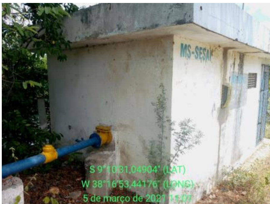
Figura 108 – Captação SESAI Desativada Fonte: INSTITUTO GESOIS, 2021.
