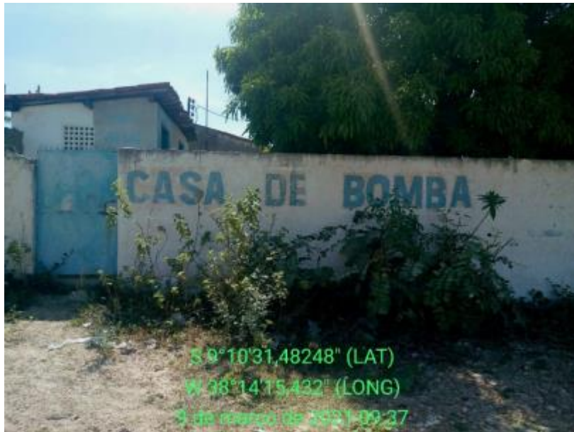
Figura 121 – Casa de Bombas da Aldeia Caxiado Fonte: INSTITUTO GESOIS, 2021.
