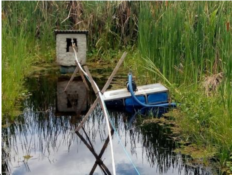
Figura 148 – Captação da Barra do Moxotó Fonte: INSTITUTO GESOIS, 2021.
