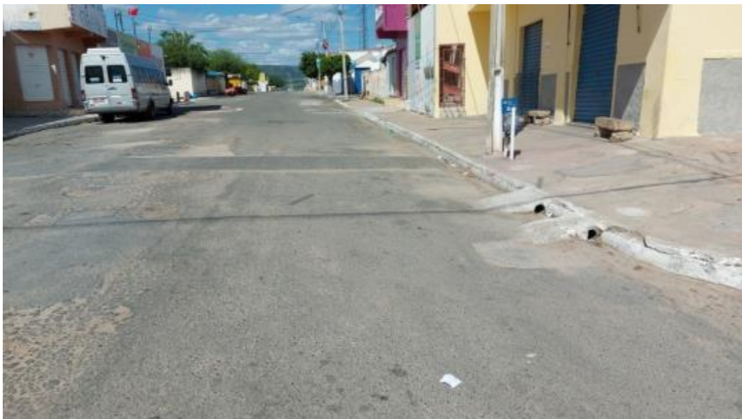
Figura 313 – Detalhe da Via Fonte: INSTITUTO GESOIS, 2020.
