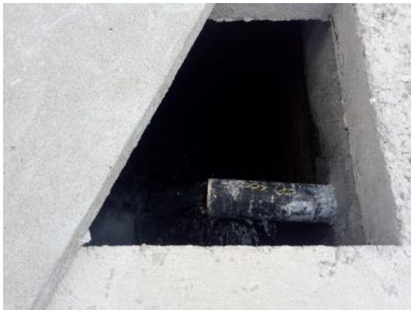
Figura 67 – ETA na Localidade Volta do Moxotó Fonte: INSTITUTO GESOIS, 2021.
