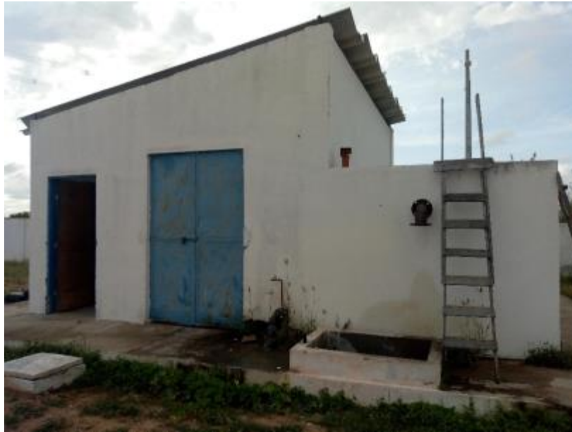
Figura 56 – ETA na Localidade Volta do Moxotó Fonte: INSTITUTO GESOIS, 2021.
