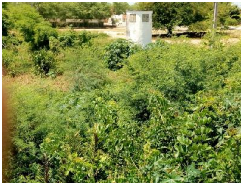
Figura 228 – Captação e Lançamento de Esgoto no Rio Moxotó na Volta do Moxotó
