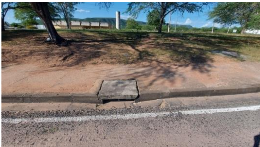
Figura 322 – Canteiro Central sem Cobertura Vegetal Fonte: INSTITUTO GESOIS, 2020.
