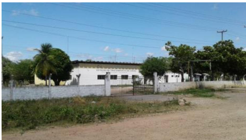
Figura 30 – Captação COMPESA Fonte: INSTITUTO GESOIS, 2021.
