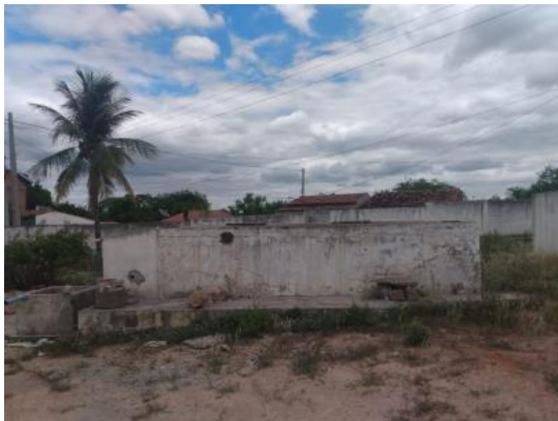
Figura 74 – Reservatório Inoperante da Volta do Moxotó Fonte: INSTITUTO GESOIS, 2021.
