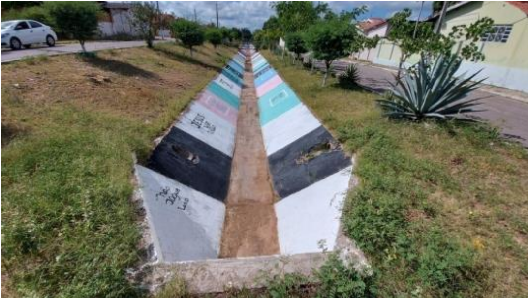
Figura 335 – Canal de Drenagem (Bairro Itaparica) Fonte: INSTITUTO GESOIS, 2020.
