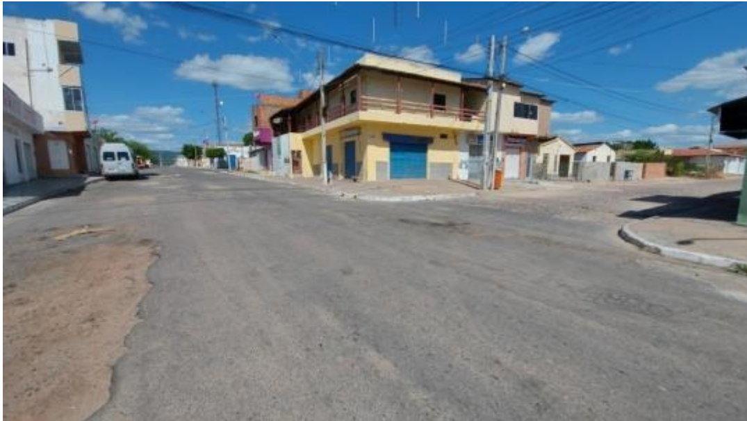
Figura 312 – Vista Ampla de Vias da Sede com Ausência de Microdrenagem Fonte: INSTITUTO GESOIS, 2020.
