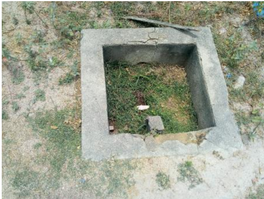
Figura 205 – Registro do Reservatório COMPESA Desativado Fonte: INSTITUTO GESOIS, 2021.
