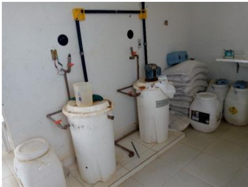
Figura 61 – ETA na Localidade Volta do Moxotó Fonte: INSTITUTO GESOIS, 2021.
