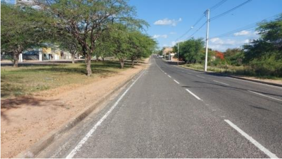
Figura 319 – Aspecto Geral da Pavimentação e Sarjeta na Av. Eletrobrás Norte Fonte: INSTITUTO GESOIS, 2020.
