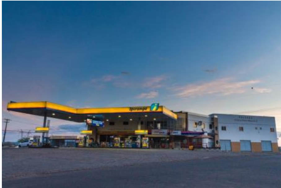
Figura 297 – Posto de Gasolina Fonte: INSTITUTO GESOIS, 2021.
