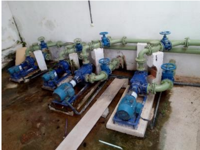
Figura 64 – ETA na Localidade Volta do Moxotó Fonte: INSTITUTO GESOIS, 2021.
