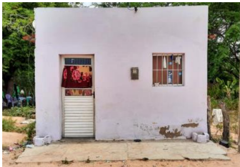
Figura 75 – Residência Comunidade Maçu Fonte: INSTITUTO GESOIS, 2021.
