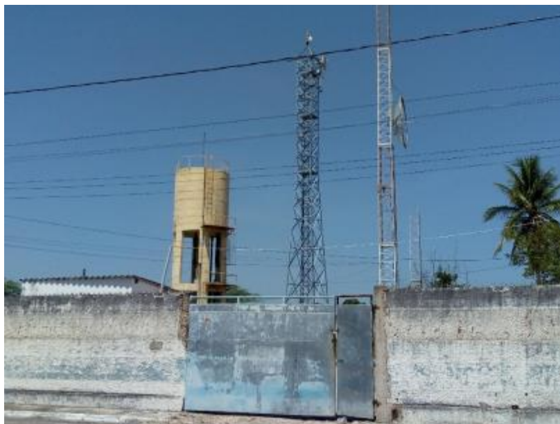
Figura 83 – Caixa D'água Inoperante da Localidade Volta do Moxotó Fonte: INSTITUTO GESOIS, 2021.
