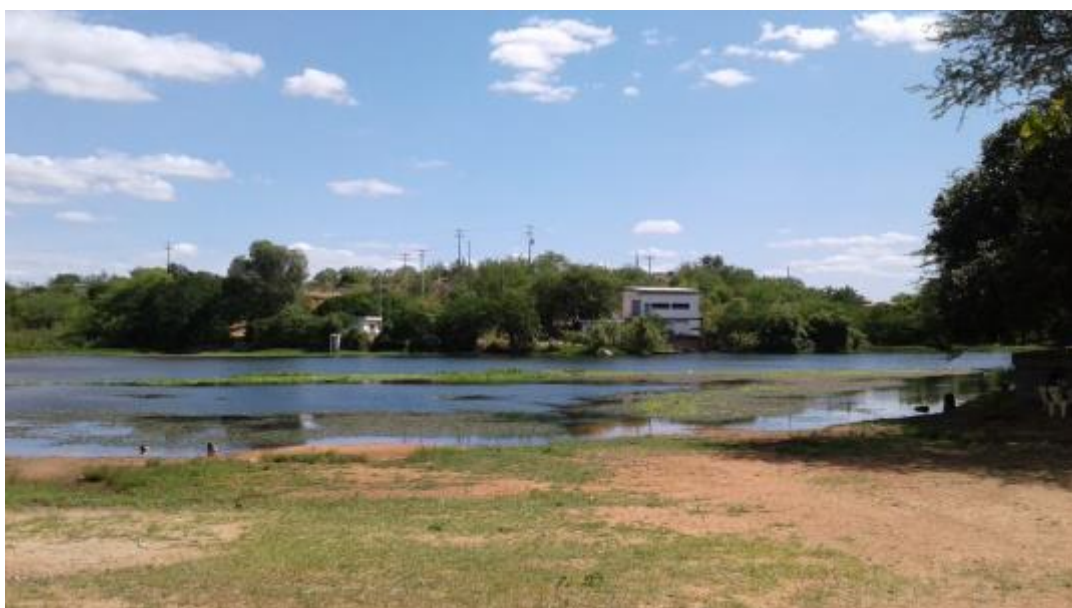
Figura 26 – Captação COMPESA Fonte: INSTITUTO GESOIS, 2021.
