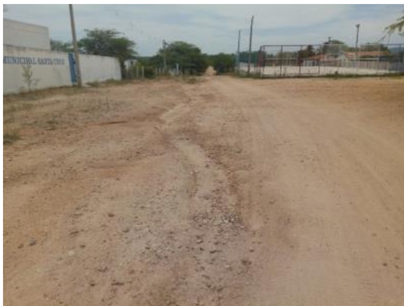
Figura 195 – Arruamento Fonte: INSTITUTO GESOIS, 2021.
