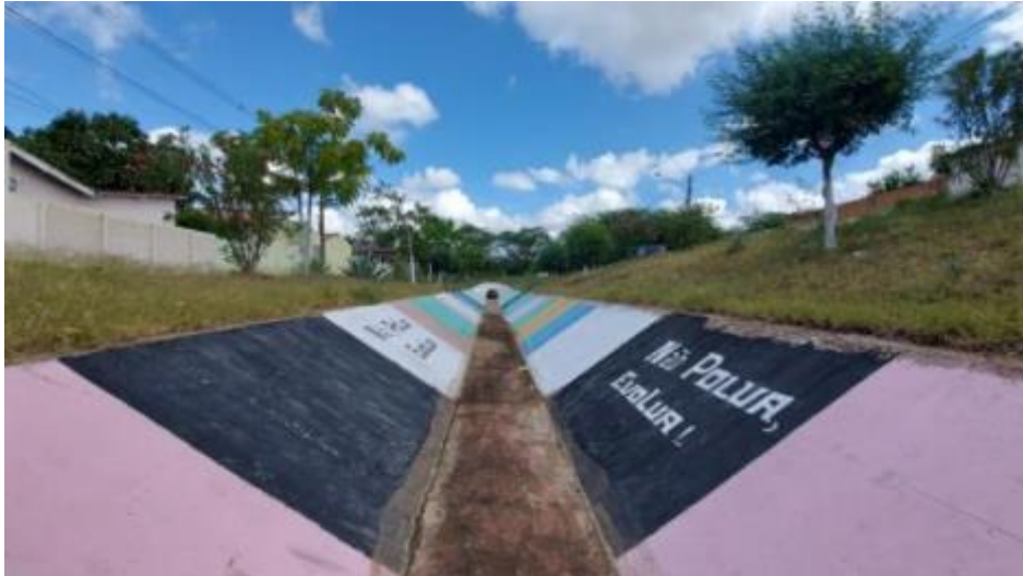
Figura 337 – Detalhe do Canal de Drenagem no Bairro Itaparica Fonte: INSTITUTO GESOIS, 2020.
