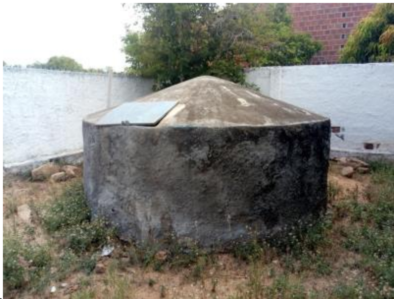
Figura 181 – Cisterna Desativada Fonte: INSTITUTO GESOIS, 2021.
