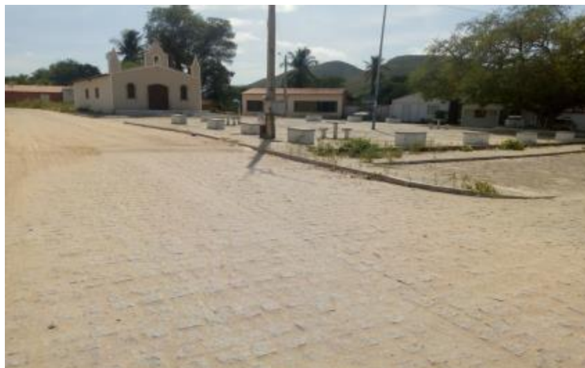
Figura 370 – Via Principal Pavimentada em Partes na Localidade Aldeia Bem-Querer de Cima Fonte: INSTITUTO GESOIS, 2020.
