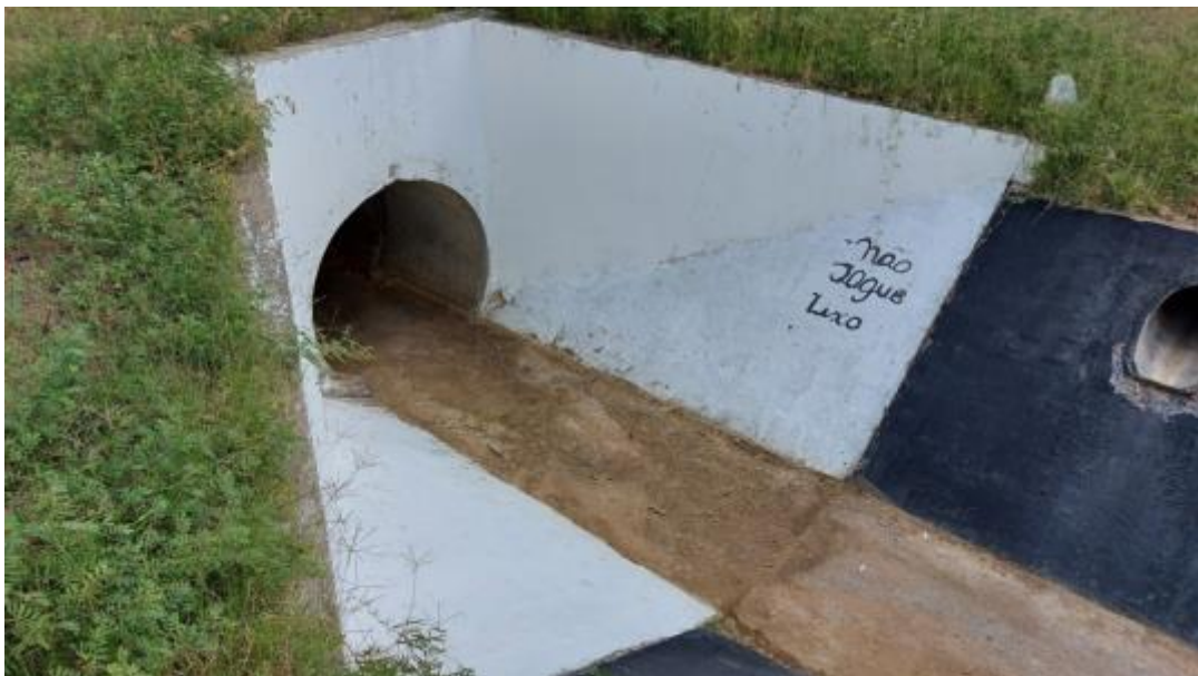
Figura 336 – Detalhe do Canal de Drenagem no Bairro Itaparica, com Presença de Material Sólido Fonte: INSTITUTO GESOIS, 2020.
