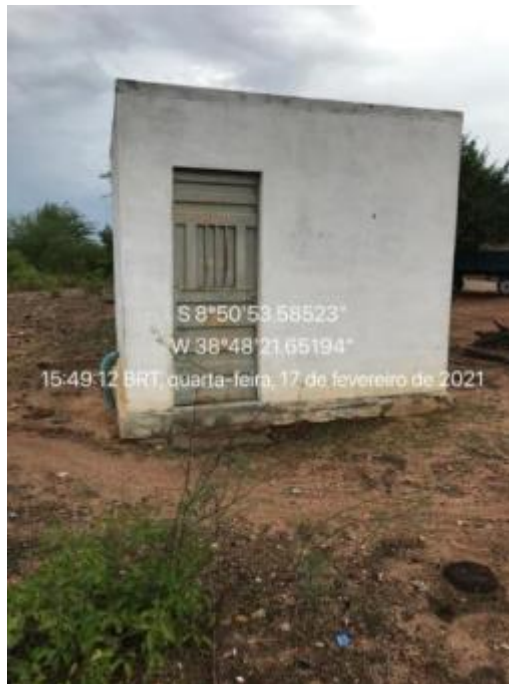
Figura 76 – Estrutura da rede geral de distribuição desativada. Fonte: INSTITUTO GESOIS, 2021.
