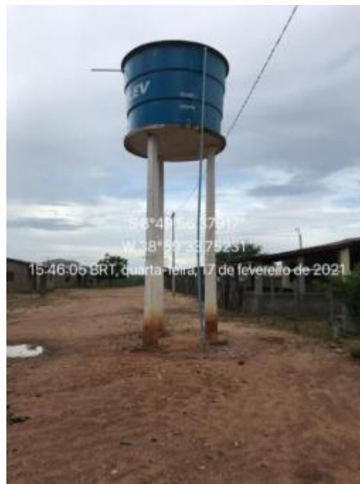
Figura 75 – Reservatório elevado. Fonte: INSTITUTO GESOIS, 2021.
