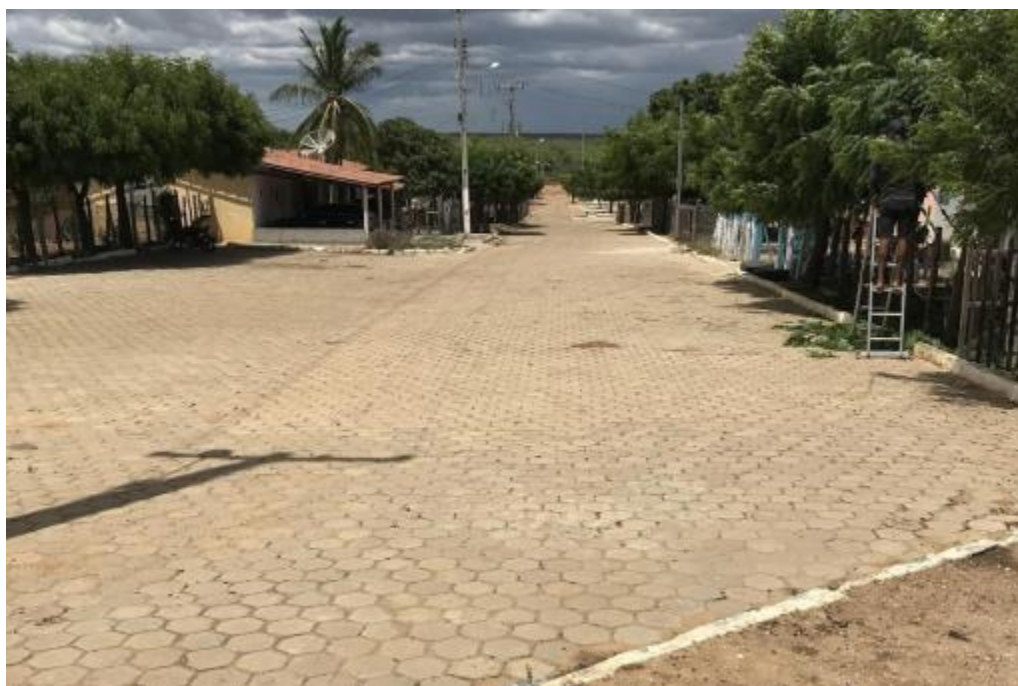
Figura 167 - Revestimento Agrovila Coité Fonte: INSTITUTO GESOIS, 2020.
