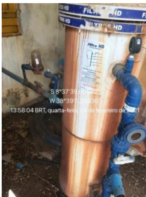
Figura 66 – Componente(filtro) do SAA, sem uso Fonte: INSTITUTO GESOIS, 2021.
