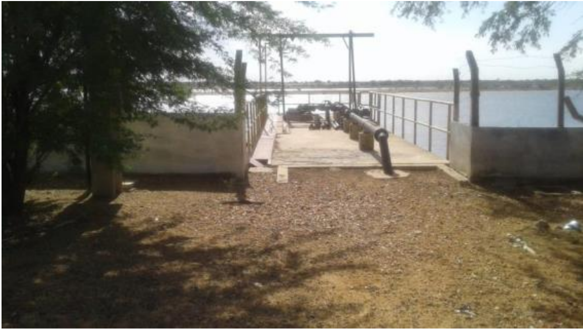
Figura 25 - Captação no Rio São Francisco Fonte: INSTITUTO GESOIS, 2021.
