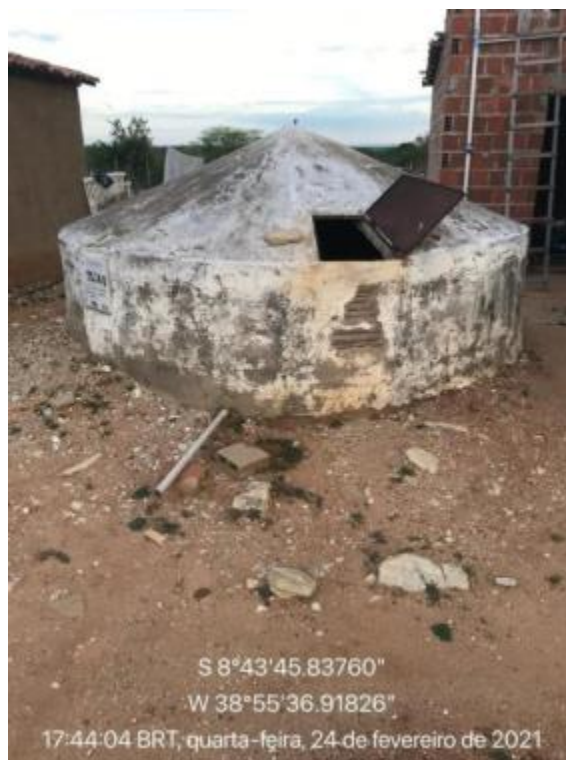
Figura 73 – Cisterna individual Assentamento Maria Preta. Fonte: INSTITUTO GESOIS, 2021.
