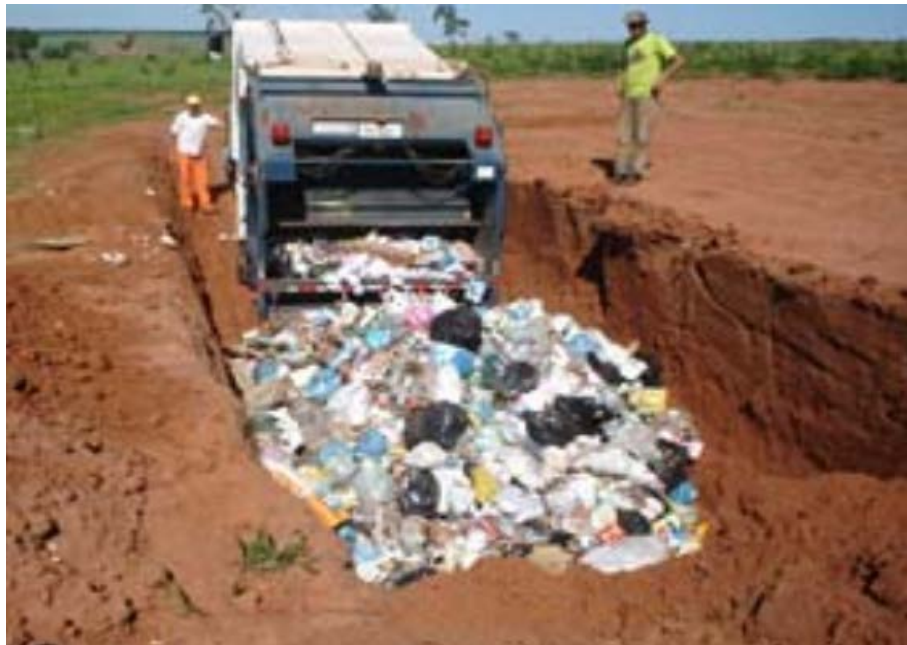
Figura 133 – Aterro Controlado. Fonte: INSTITUTO GESOIS, 2017.
