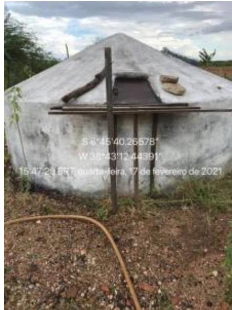
Figura 74 – Cisterna em alvenaria. Fonte: INSTITUTO GESOIS, 2021.
