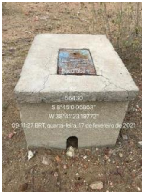
Figura 82 – Estrutura de SAA desativado Fonte: INSTITUTO GESOIS, 2021.
