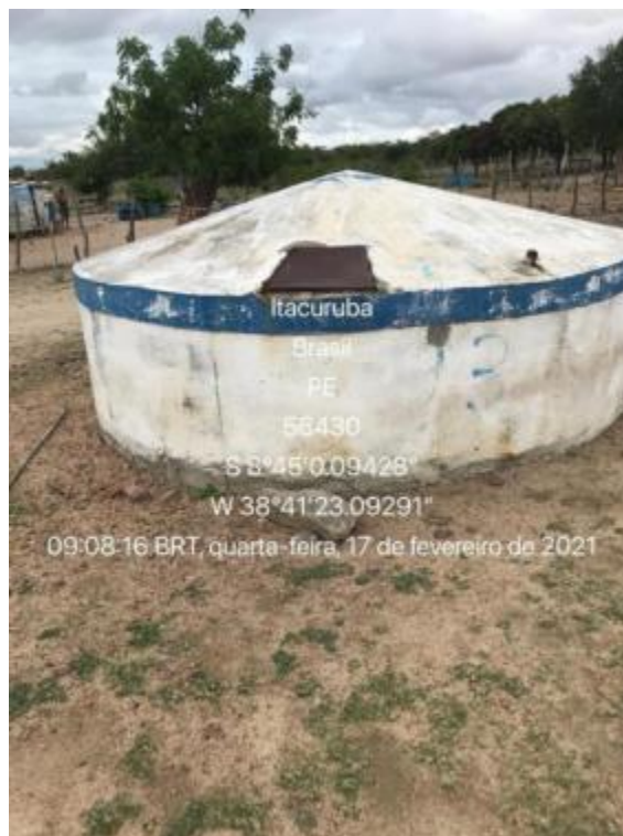
Figura 80 – Cisterna, em alvenaria
