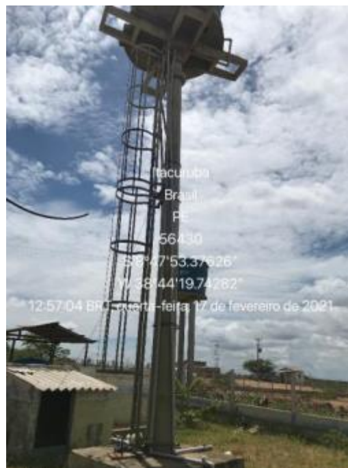
Figura 88 – Reservatório elevado Fonte: INSTITUTO GESOIS, 2021.
