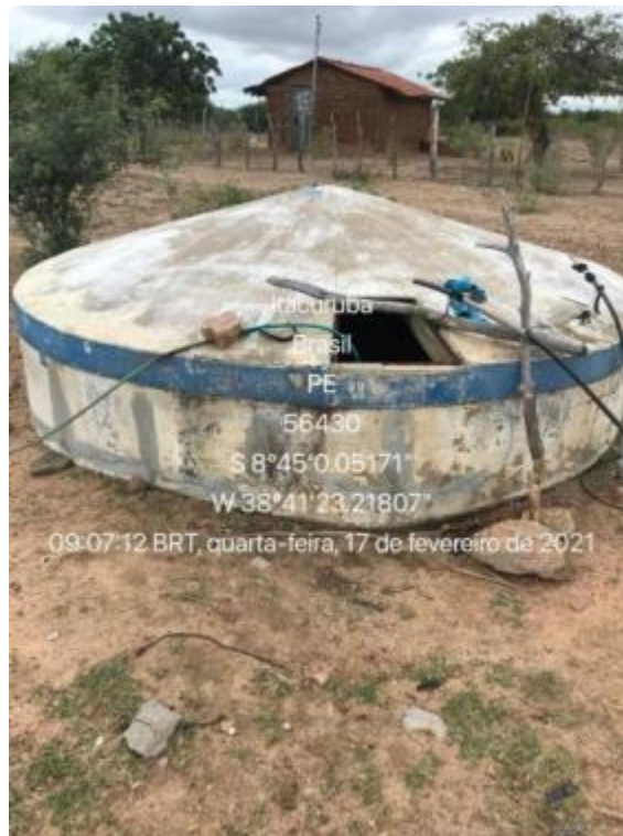
Figura 79 – Cisterna, em alvenaria Fonte: INSTITUTO GESOIS, 2021.
