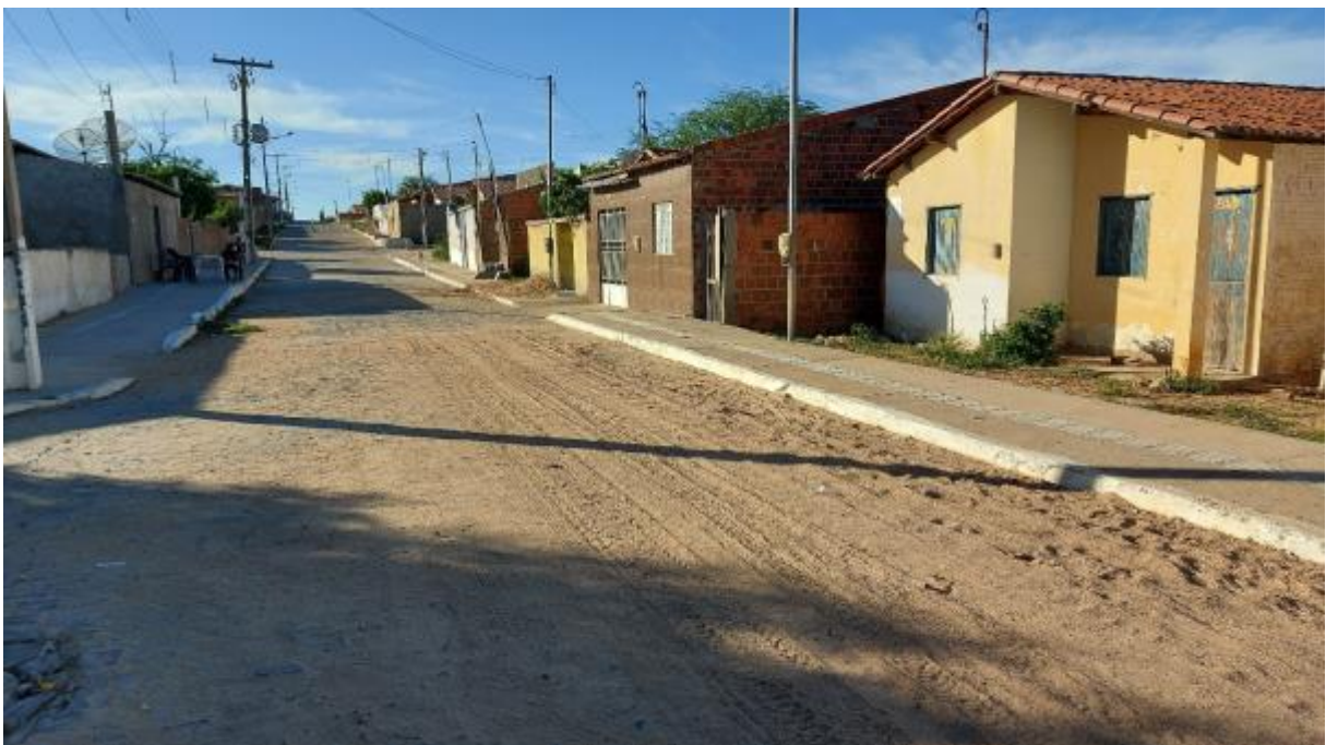
Figura 165 - Acúmulo de areia na via Fonte: INSTITUTO GESOIS, 2020.
