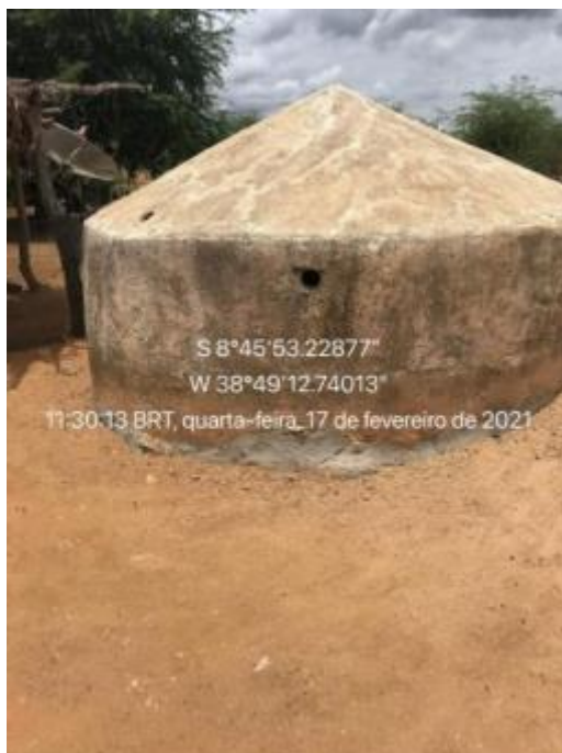
Figura 39 – Cisterna coletiva, em alvenaria Fonte: INSTITUTO GESOIS, 2021.
