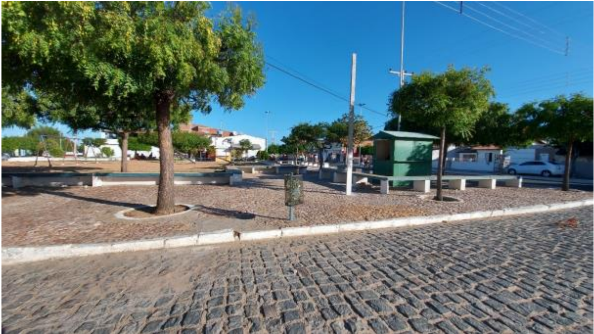
Figura 162 - Aspecto da via e pavimentação poliédrica Fonte: INSTITUTO GESOIS, 2020.
