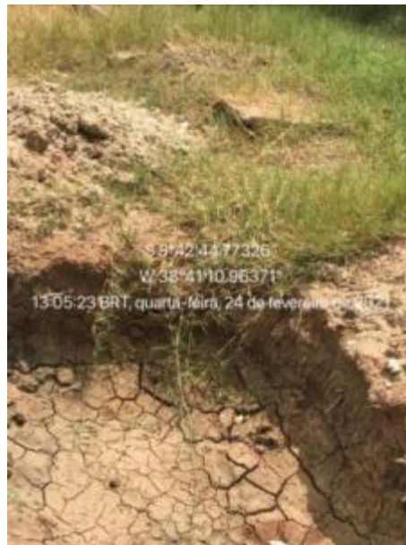
Figura 100 – Fossa séptica de uso coletivo no Assentamento Angico I (Paulo Freire)
