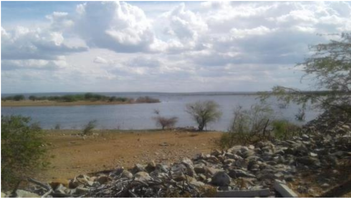
Figura 23 - Captação no Rio São Francisco Fonte: INSTITUTO GESOIS, 2021.
