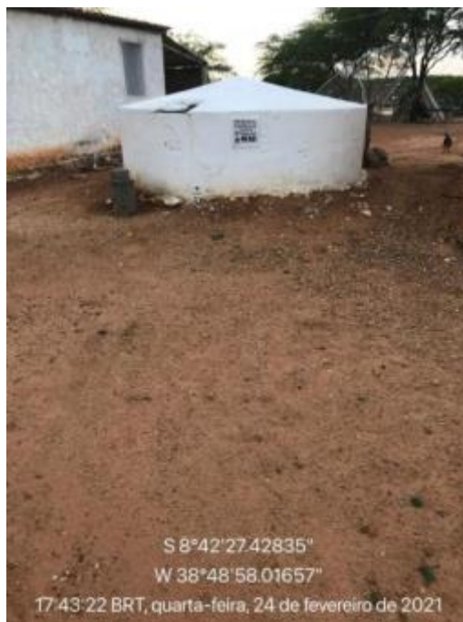
Figura 72 – Cisterna individual Assentamento Maria Preta. Fonte: INSTITUTO GESOIS, 2021.
