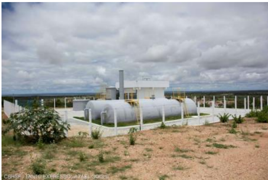
Figura 53 – ETA, vista geral Fonte: INSTITUTO GESOIS, 2021.
