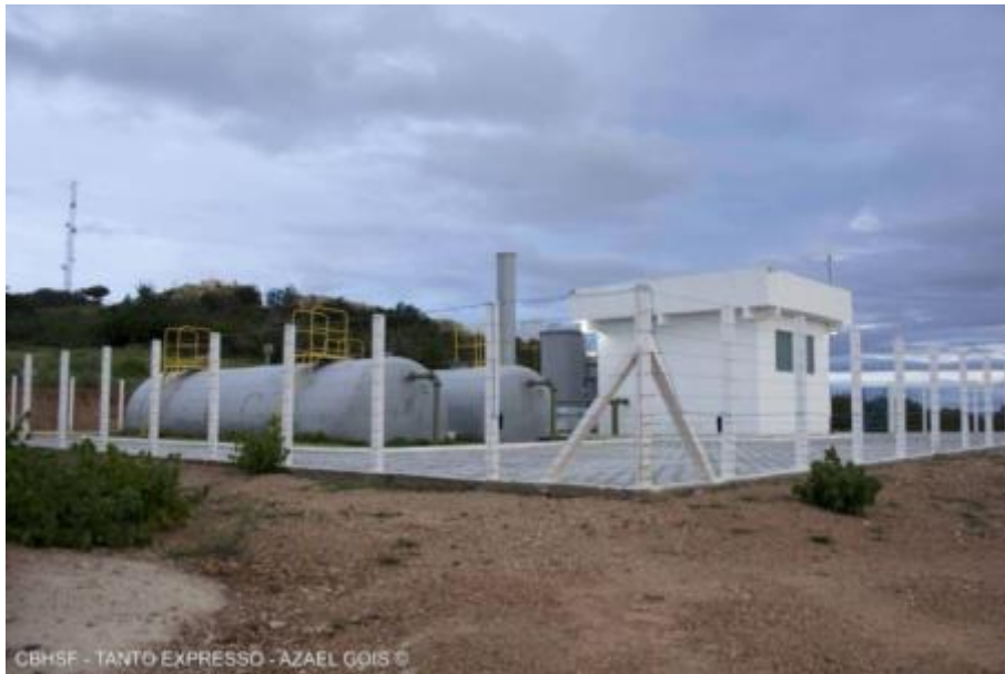
Figura 52 – ETA, vista geral Fonte: INSTITUTO GESOIS, 2021.
