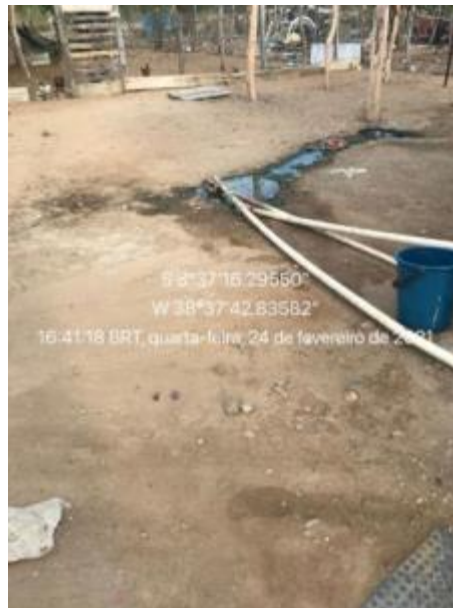
Figura 96 –Esgoto a Céu Aberto na Comunidade Quilombola Ingazeira Fonte: INSTITUTO GESOIS, 2021.
