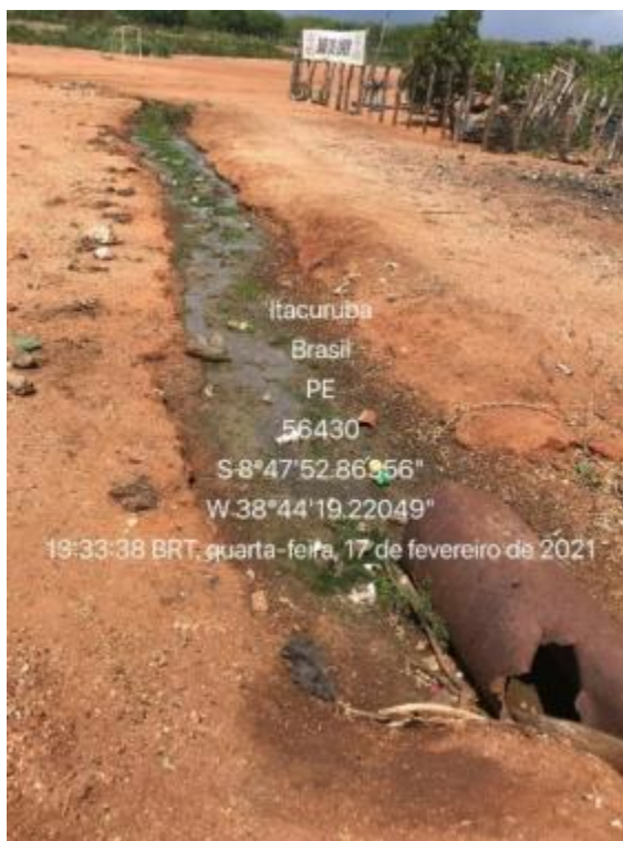
Figura 110 – Esgoto a céu aberto da Agrovila Coité. Fonte: INSTITUTO GESOIS, 2021.
