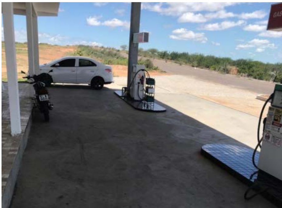
Figura 150 – Posto de Gasolina Fonte: INSTITUTO GESOIS, 2021.
