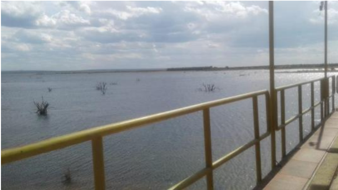
Figura 27 – Captação do Município de Itacuruba/PE Fonte: INSTITUTO GESOIS, 2021.
