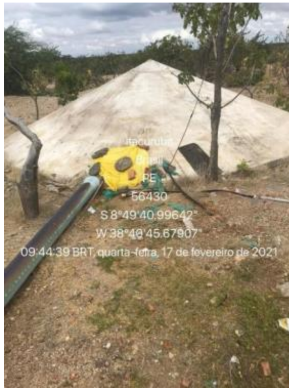
Figura 77 – Cisterna, em alvenaria Fonte: INSTITUTO GESOIS, 2021.
