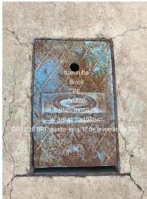
Figura 81 – Estrutura de SAA desativado Fonte: INSTITUTO GESOIS, 2021.
