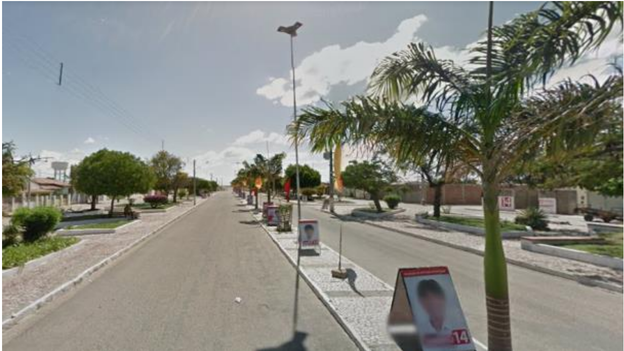
Figura 159 - Vias principais de Itacuruba sem presença de microdrenagem Fonte: INSTITUTO GESOIS, 2020.
