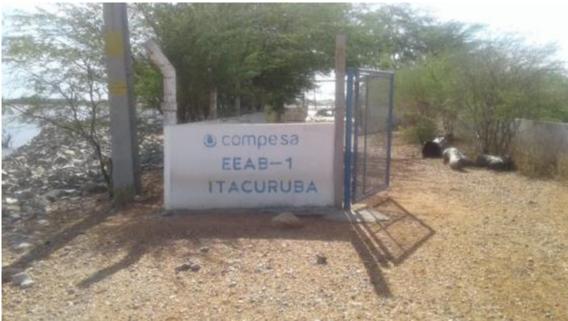
Figura 24 – Captação EEAB-1 no Rio São Francisco Fonte: INSTITUTO GESOIS, 2021.
