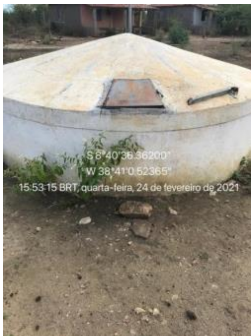
Figura 67 – Cisterna coletiva, em alvenaria Fonte: INSTITUTO GESOIS, 2021.
