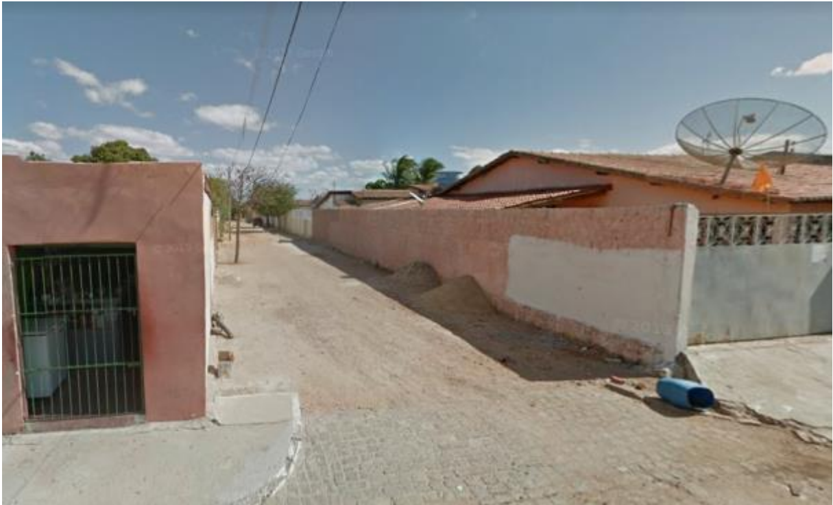
Figura 156 - Aspecto de via sem pavimentação na sede municipal Fonte: INSTITUTO GESOIS, 2020.
