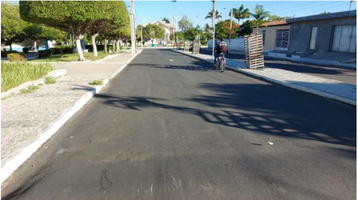
Figura 157 - Vias asfálticas no centro de Itacuruba Fonte: INSTITUTO GESOIS, 2020.
