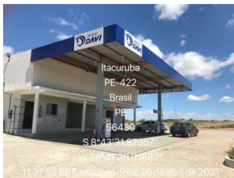
Figura 149 – Posto de Gasolina Fonte: INSTITUTO GESOIS, 2021.
