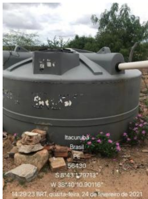
Figura 64 – Cisterna de uso coletivo, em PVC Fonte: INSTITUTO GESOIS, 2021.
