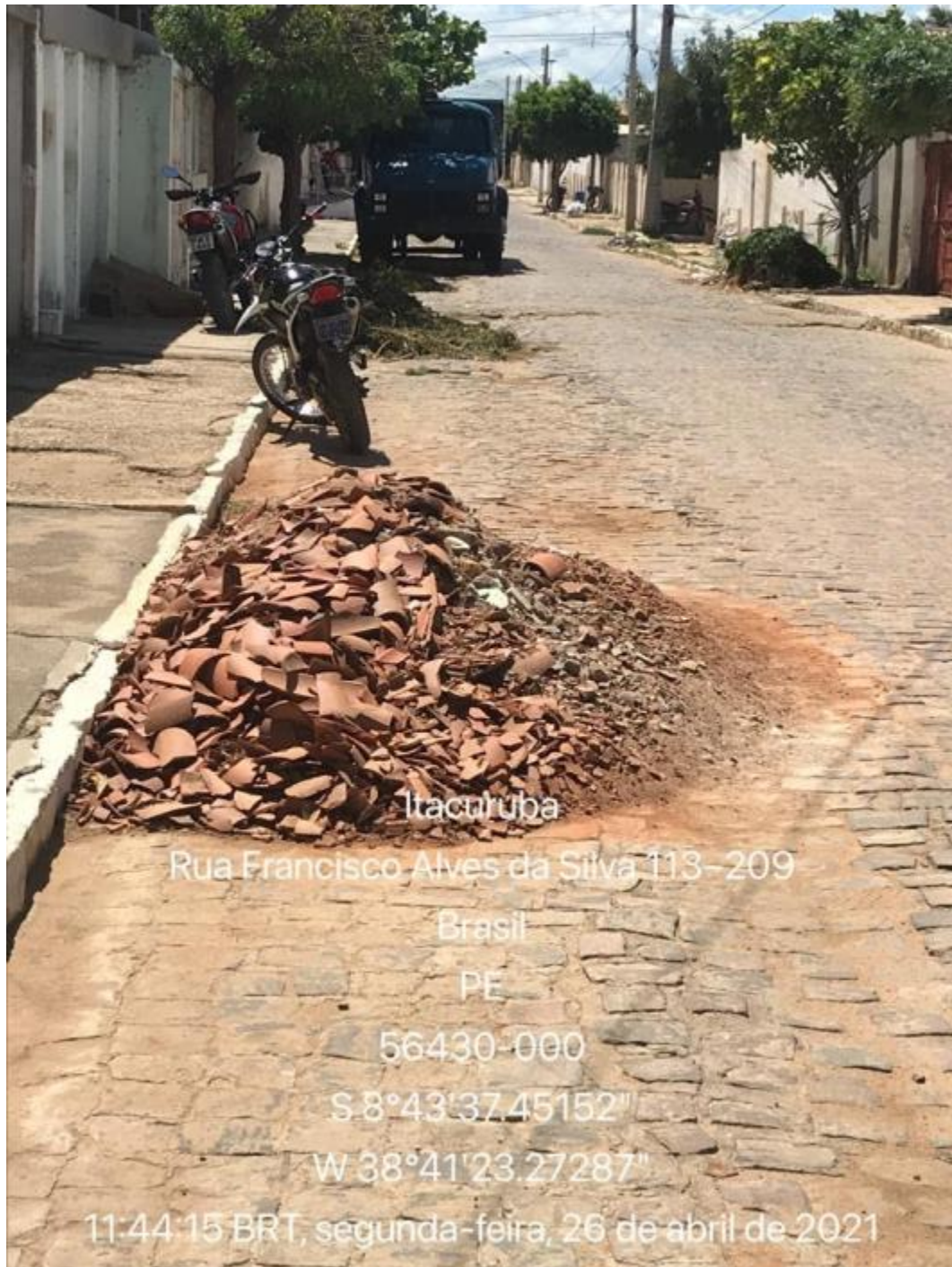
Figura 136 – RCC Lançados Inadequadamente em Via Pública. Fonte: INSTITUTO GESOIS, 2021.
