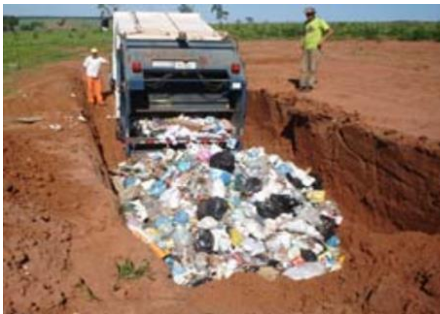
Figura 270 – Aterro Controlado. Fonte: INSTITUTO GESOIS, 2017.
