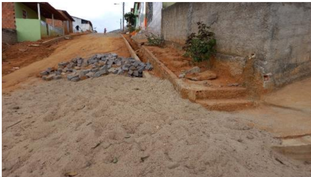
Figura 301 – Pavimentação rua Enoque Gomes em Água Branca Fonte: INSTITUTO GESOIS, 2020.
