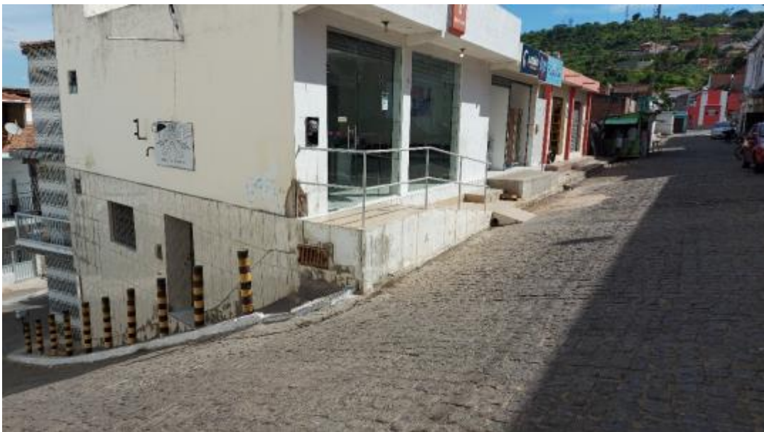
Figura 297 – Rua central pavimentada e com sarjeta Fonte: INSTITUTO GESOIS, 2020.
