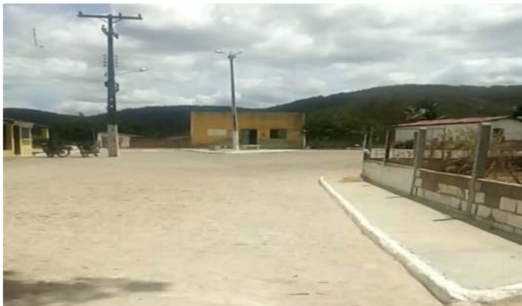
Figura 306 – Pavimentação poliédrica na região central do distrito Papa Terra Fonte: INSTITUTO GESOIS, 2020.
