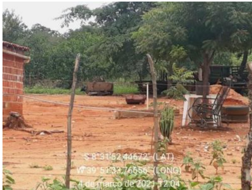
Figura 136 – Fossa Negra Fonte: INSTITUTO GESOIS, 2021.
