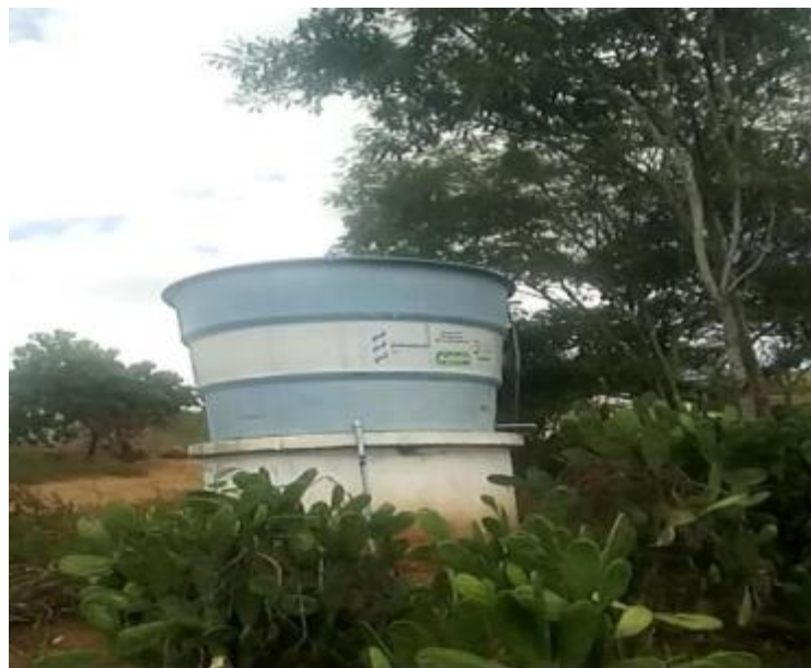
Figura 175 – Reservatório Fonte: INSTITUTO GESOIS, 2021.
