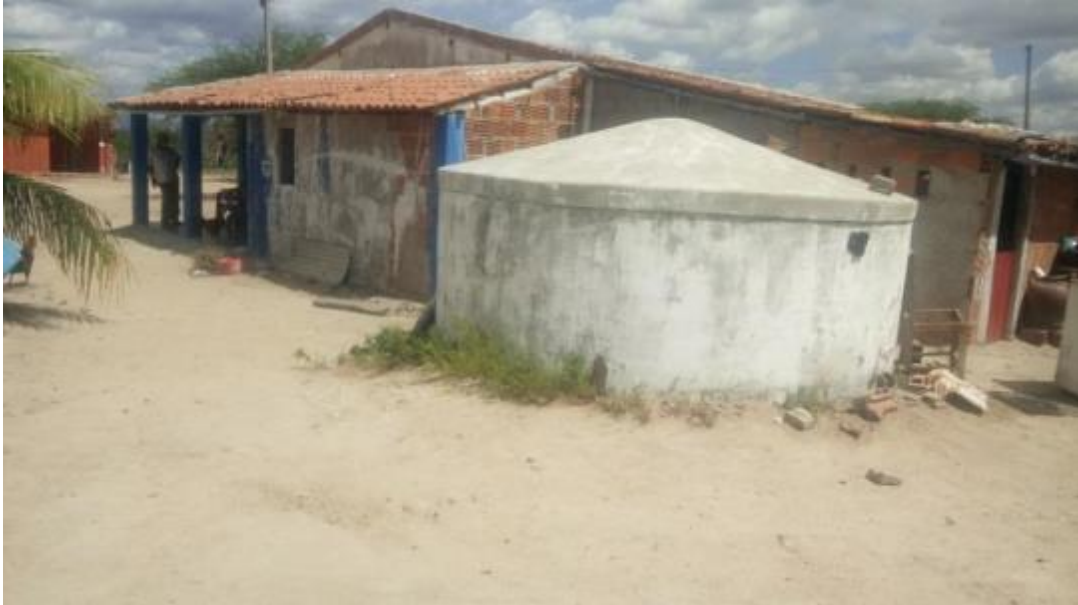
Figura 182 – Cisterna Fonte: INSTITUTO GESOIS, 2021.
