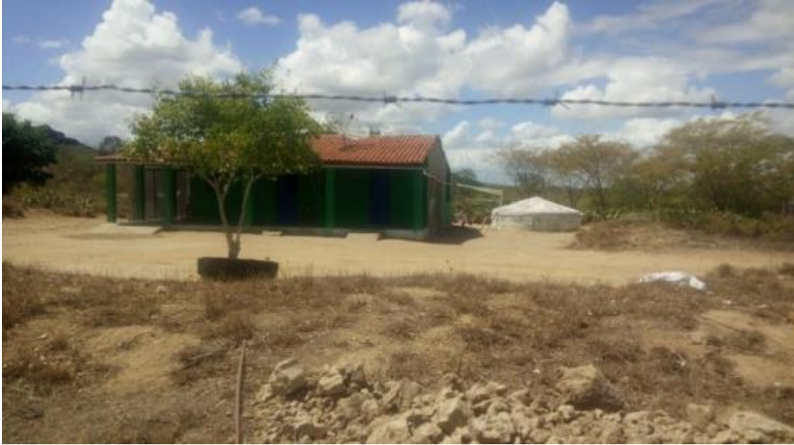
Figura 164 – Cisterna Fonte: INSTITUTO GESOIS, 2021.
