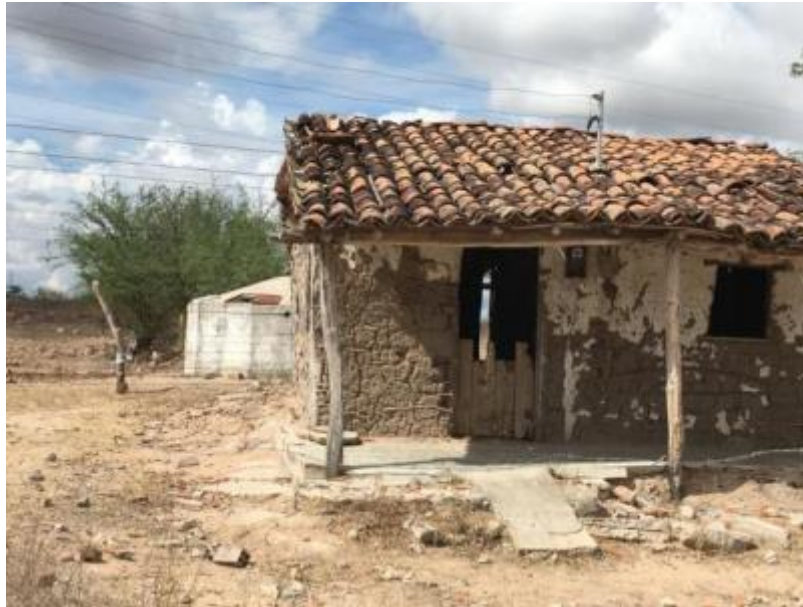
Figura 145 – Cisterna Fonte: INSTITUTO GESOIS, 2021.
