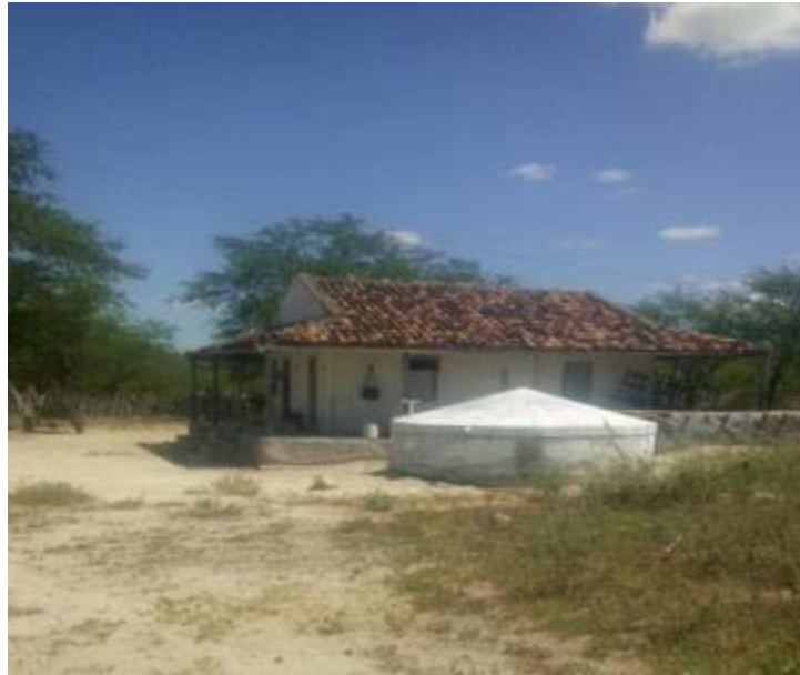
Figura 139 – Cisterna Fonte: INSTITUTO GESOIS, 2021.
