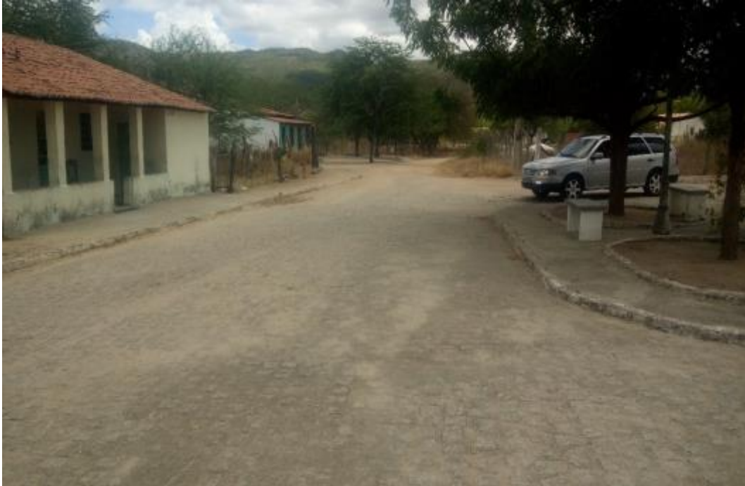
Figura 310 – Rua pavimentada com paralelepípedo na comunidade Conceição Fonte: INSTITUTO GESOIS, 2020.
