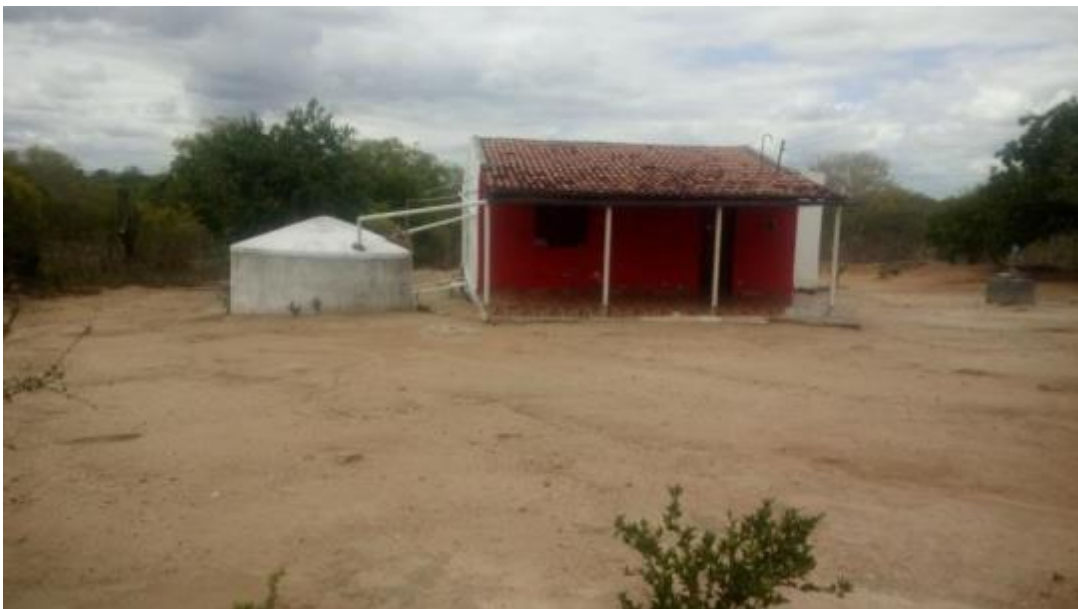
Figura 161 – Cisterna Fonte: INSTITUTO GESOIS, 2021.
