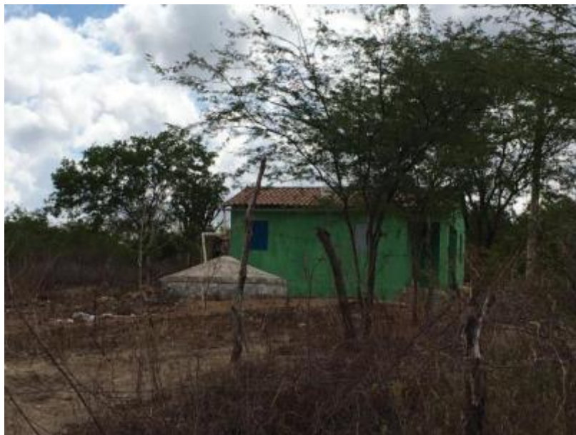
Figura 150 – Cisterna Fonte: INSTITUTO GESOIS, 2021.
