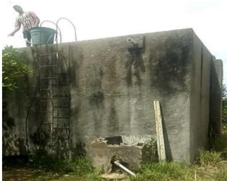
Figura 130 – Caixa d'água Fonte: INSTITUTO GESOIS, 2021.
