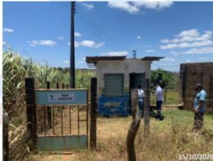
Figura 56 – Estação Elevatória de Ouricuri Fonte: ARSAL, 2020.
