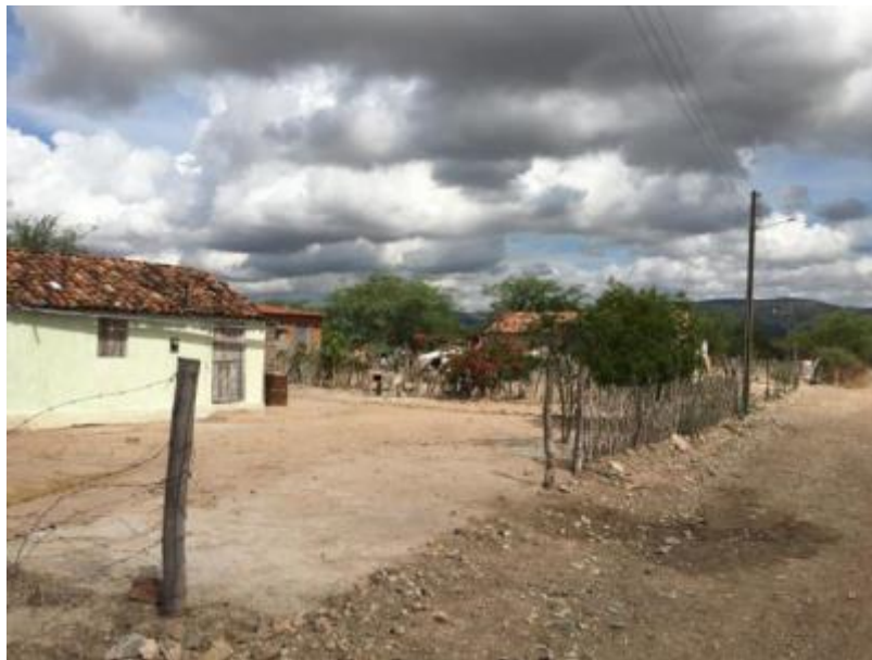
Figura 146 – Captação de água de chuva Fonte: INSTITUTO GESOIS, 2021.
