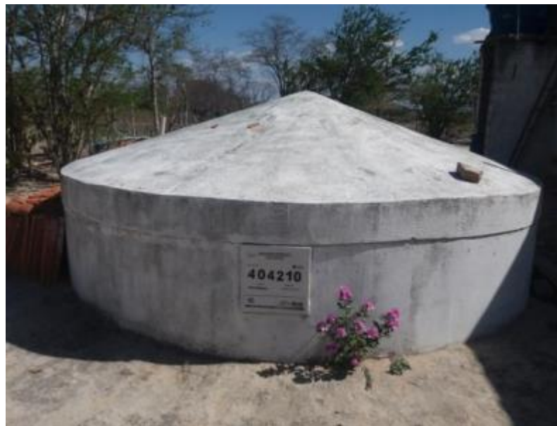
Figura 205 – Cisterna Fonte: INSTITUTO GESOIS, 2021.
