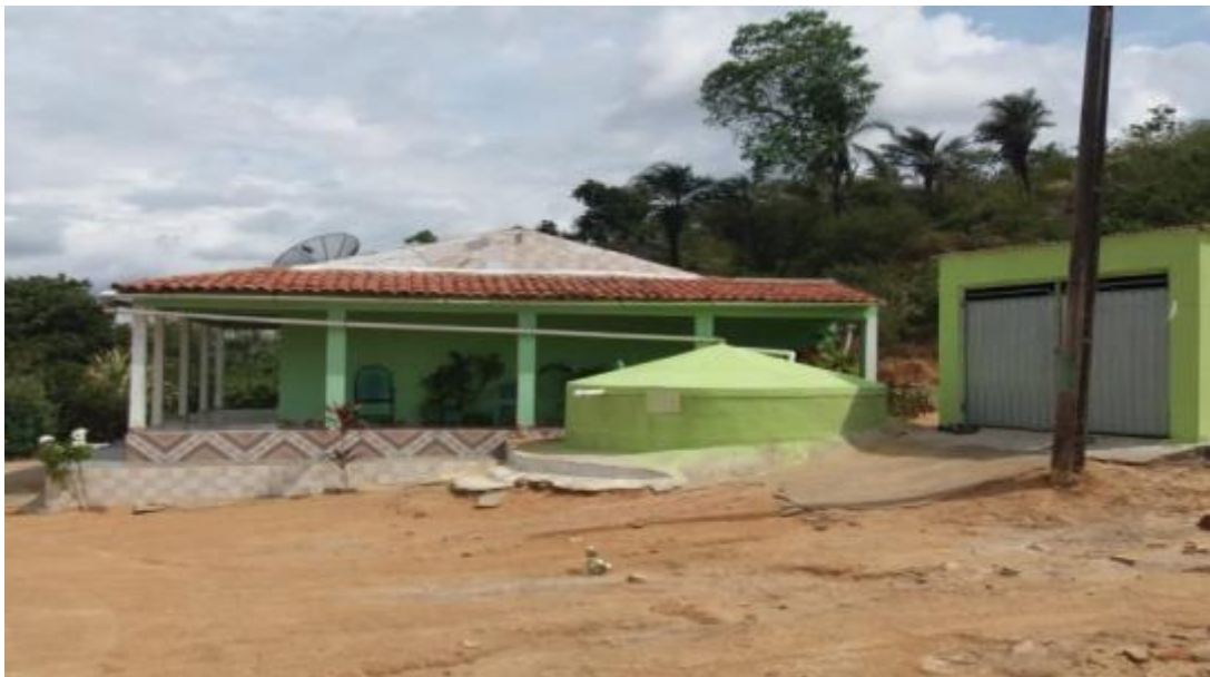
Figura 202 – Cisterna Fonte: INSTITUTO GESOIS, 2021.
