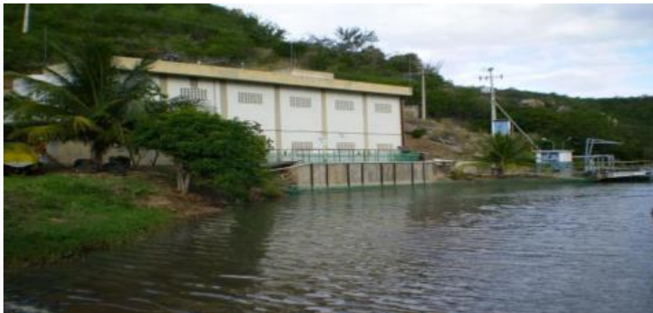
Figura 18 – Captação em Delmiro Gouveia Fonte: PMAB, 2020.
