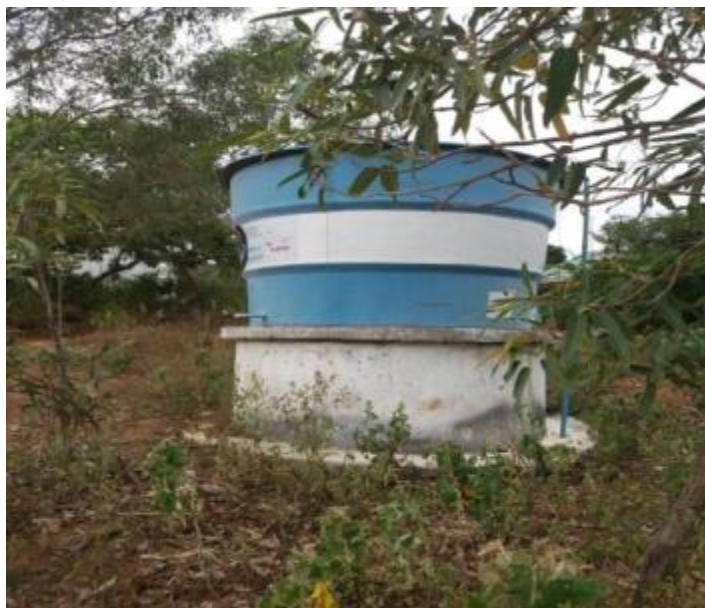
Figura 230 – Reservatório Fonte: INSTITUTO GESOIS, 2021.
