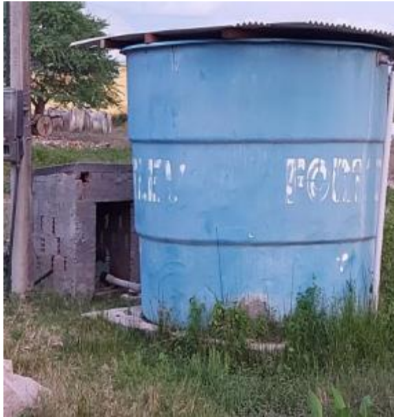
Figura 101 – Cx d'água Distrito Fonte: INSTITUTO GESOIS, 2021.
