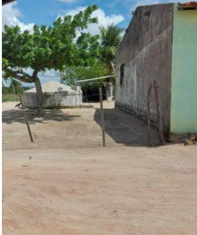
Figura 151 – Cisterna Fonte: INSTITUTO GESOIS, 2021.
