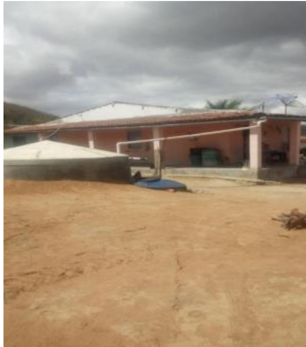
Figura 195 – Cisterna Fonte: INSTITUTO GESOIS, 2021.
