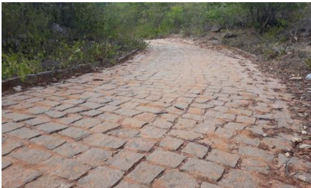
Figura 312 – Estrada que dá acesso à comunidade Serra do Paraíso pavimentada Fonte: INSTITUTO GESOIS, 2020.
