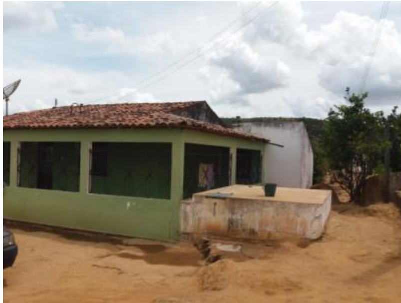
Figura 239 – Cisterna Fonte: INSTITUTO GESOIS, 2021
