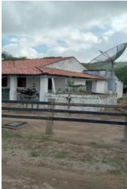
Figura 76 – Caixa coletora de água de chuvas e pipas Fonte: INSTITUTO GESOIS, 2021.
