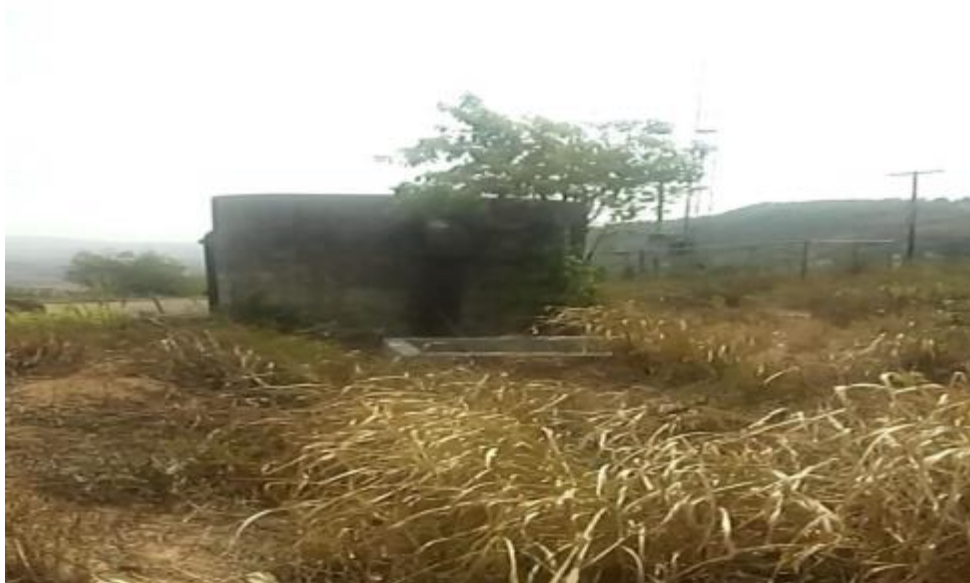
Figura 67 – Estação Elevatória de Água Tratada-EEAT Fonte: INSTITUTO GESOIS, 2021.
