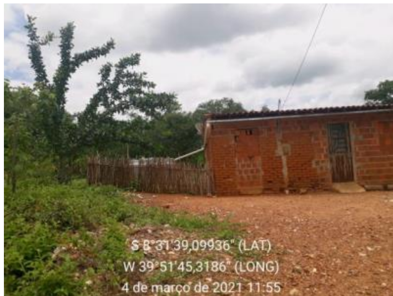
Figura 137 – Captação de Água de Chuva Fonte: INSTITUTO GESOIS, 2021.
