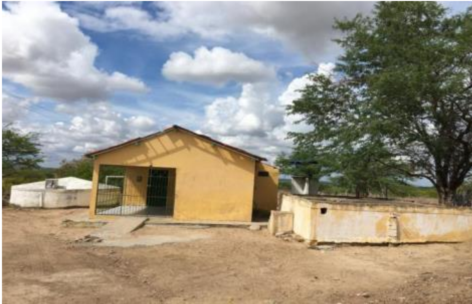
Figura 154 – Escola Municipal e Cisternas Fonte: INSTITUTO GESOIS, 2021.
