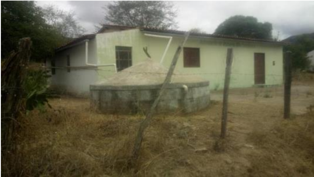
Figura 78 – Cisterna Fonte: INSTITUTO GESOIS, 2021.
