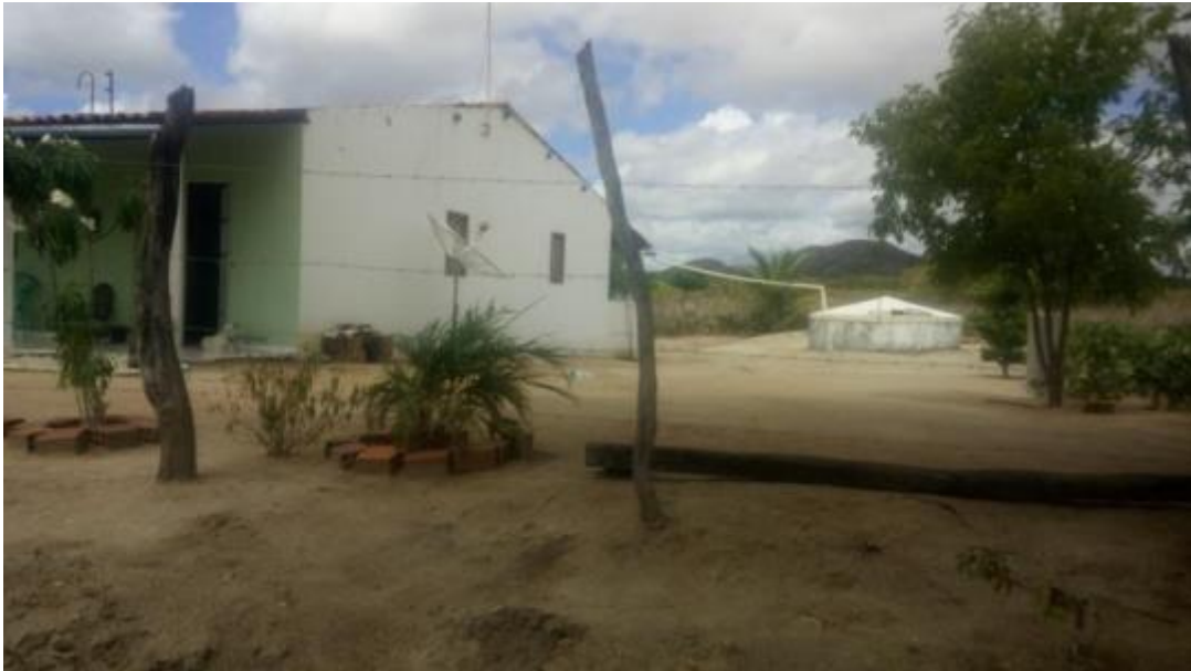
Figura 124 – Cisterna Fonte: INSTITUTO GESOIS, 2021.
