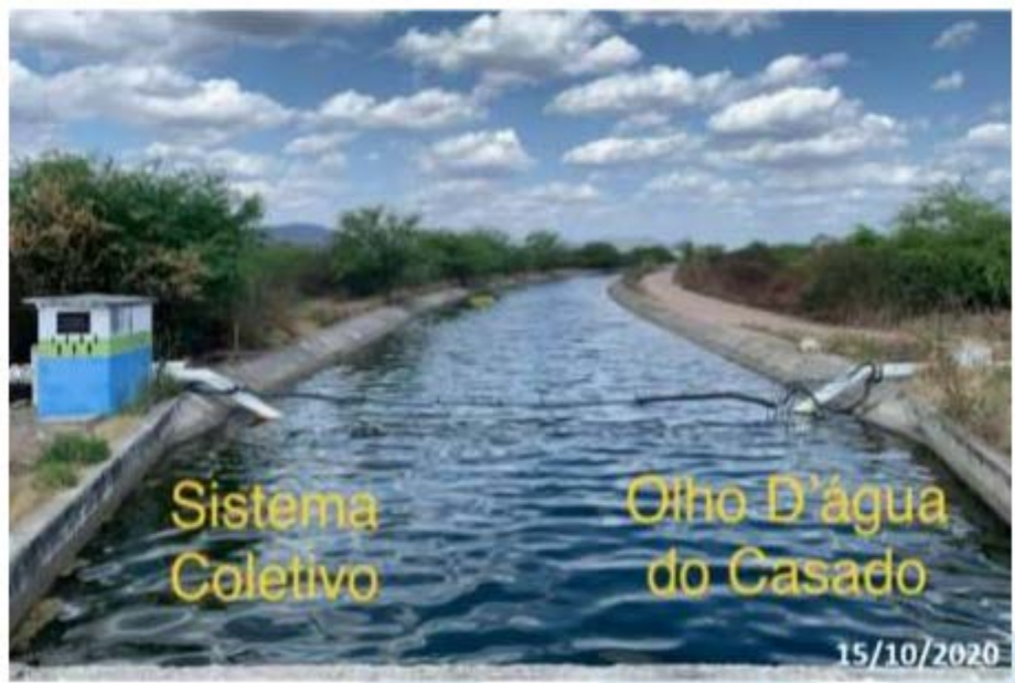
Figura 25 – Captação no Canal do Sertão Fonte: ARSAL, 2020.
