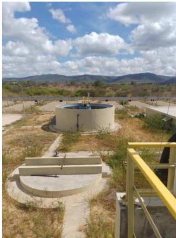
Figura 37 – Tanques Fonte: INSTITUTO GESOIS, 2021.
