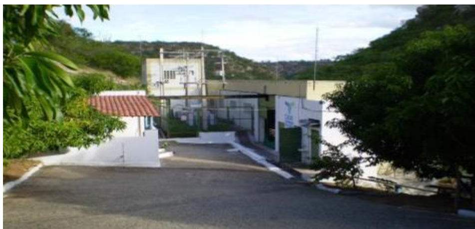
Figura 19 – Captação em Delmiro Gouveia Fonte: PMAB, 2020.
