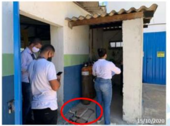
Figura 49 – Casa de Química EEAT- 05 Fonte: ARSAL, 2020.
