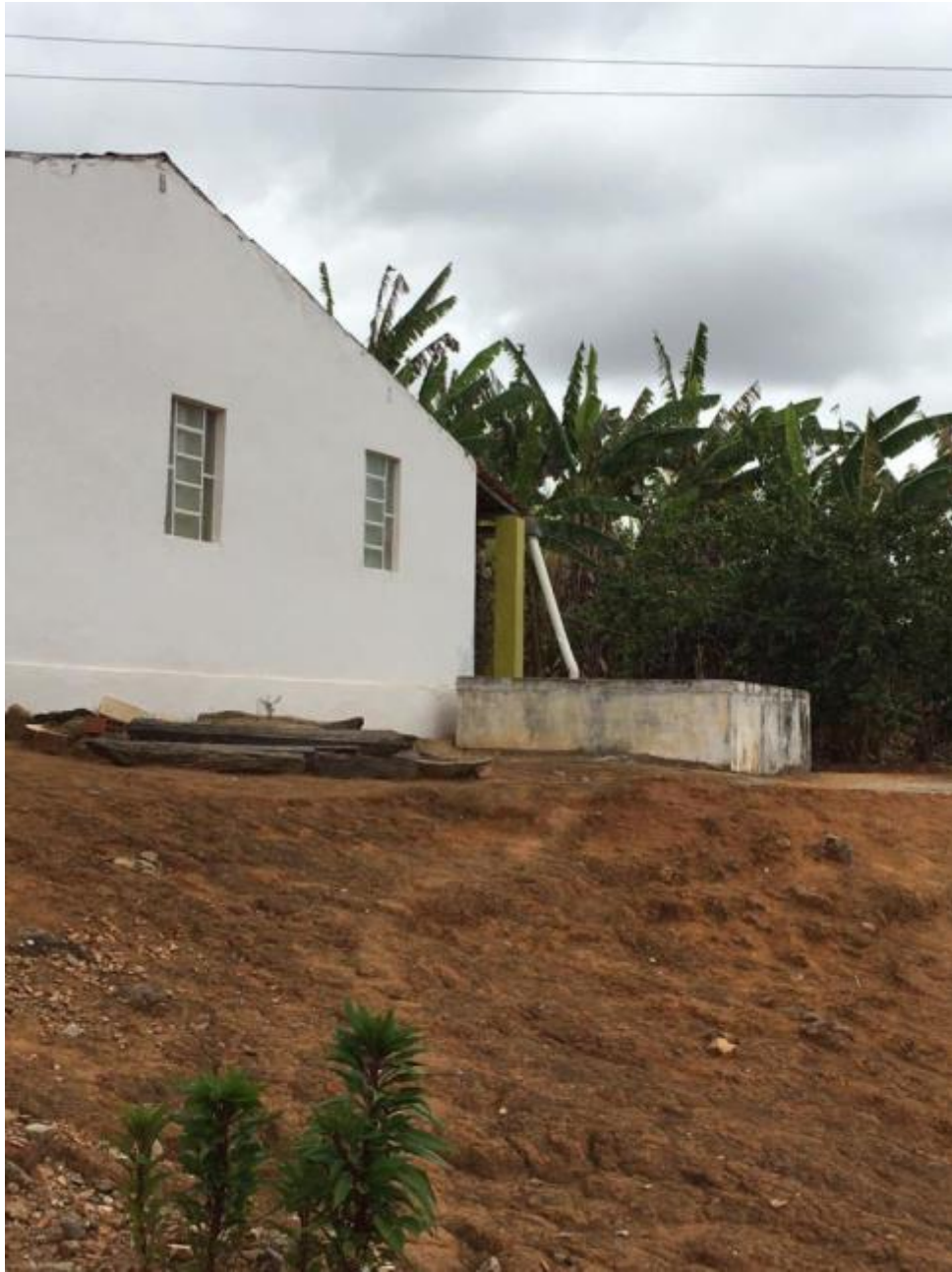
Figura 179 – Cisterna Fonte: INSTITUTO GESOIS, 2021.
