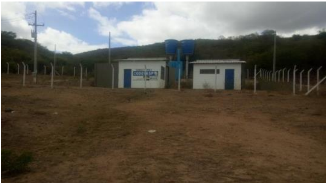
Figura 86 – Tratamento da Água CODEVASF Fonte: INSTITUTO GESOIS, 2021.
