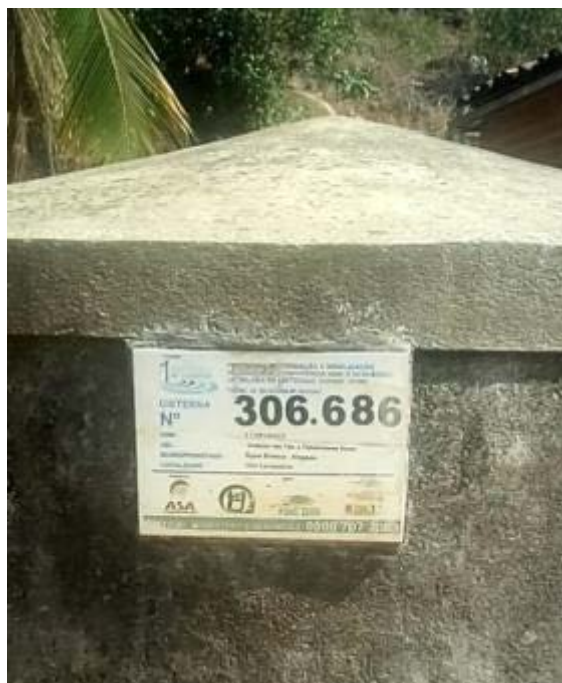
Figura 232 – Cisterna Fonte: INSTITUTO GESOIS, 2021.
