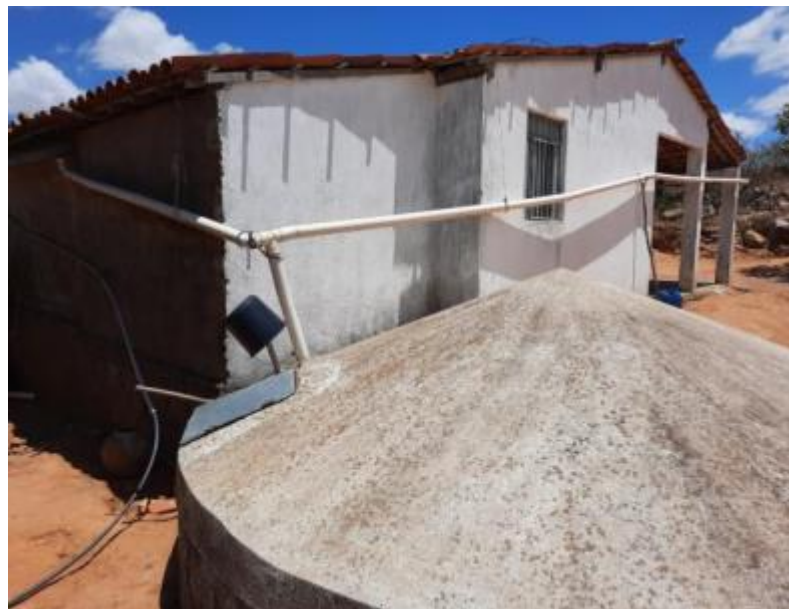
Figura 213 – Cisterna Fonte: INSTITUTO GESOIS, 2021
