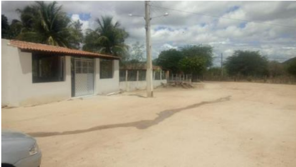
Figura 90 – Esgoto a céu aberto Fonte: INSTITUTO GESOIS, 2021.
