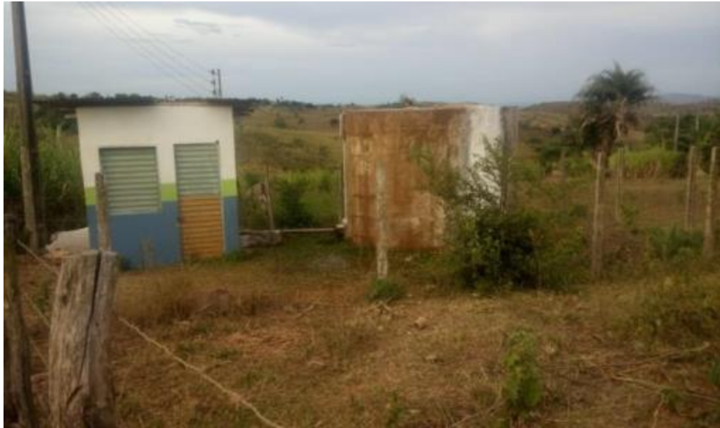
Figura 113 – Captação Boa Vista Fonte: INSTITUTO GESOIS, 2021.
