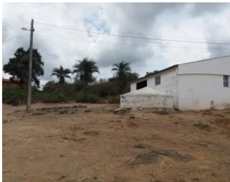
Figura 238 – Cisterna Fonte: INSTITUTO GESOIS, 2021
