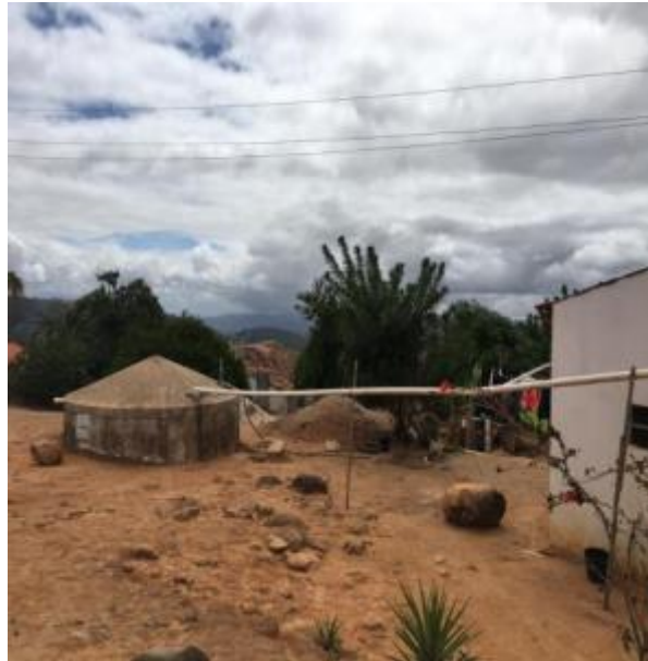
Figura 170 – Caixa d'Água Fonte: INSTITUTO GESOIS, 2021.
