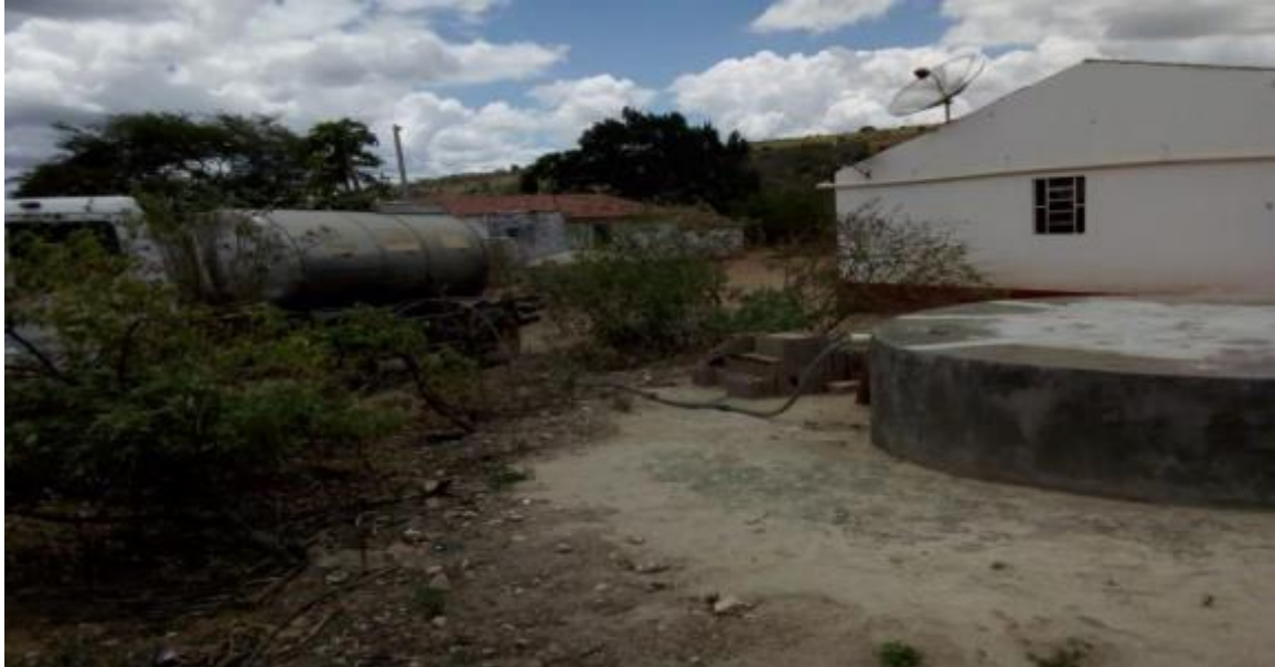
Figura 106 – Cisterna Fonte: INSTITUTO GESOIS, 2021.
