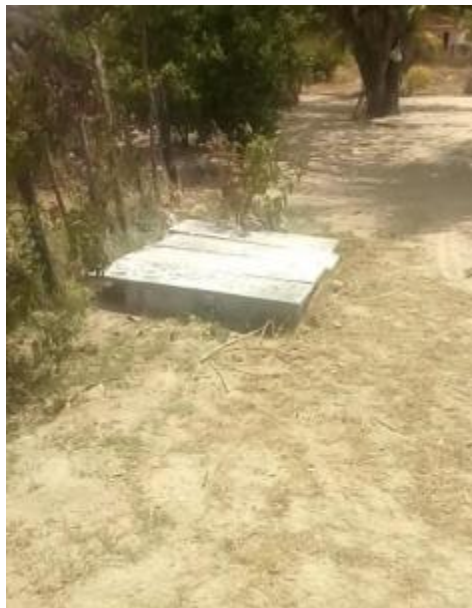
Figura 74 – Fossa negra Fonte: INSTITUTO GESOIS, 2021.
