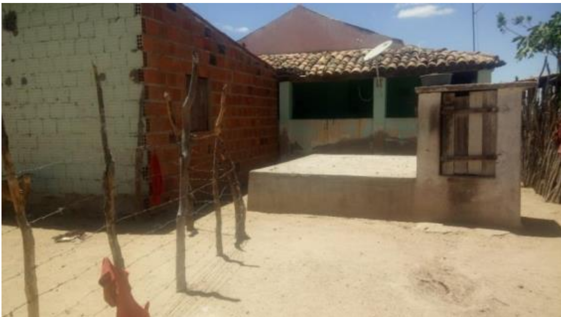
Figura 188 – Cisterna Fonte: INSTITUTO GESOIS, 2021.
