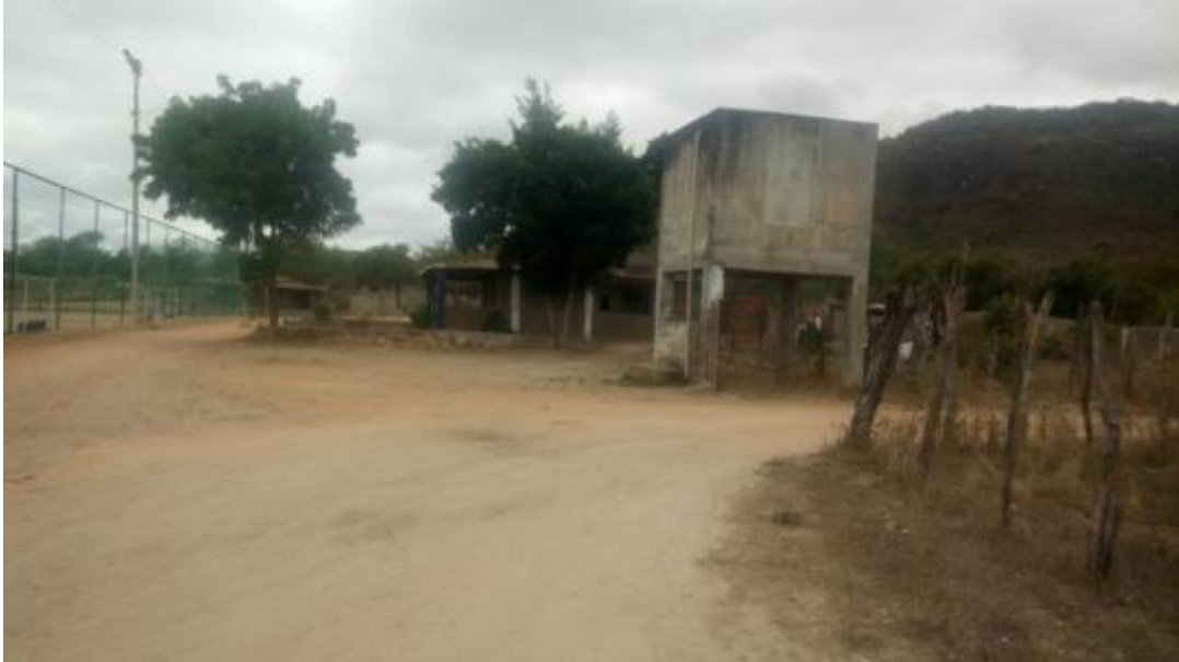
Figura 89 – Reservatório Fonte: INSTITUTO GESOIS, 2021.
