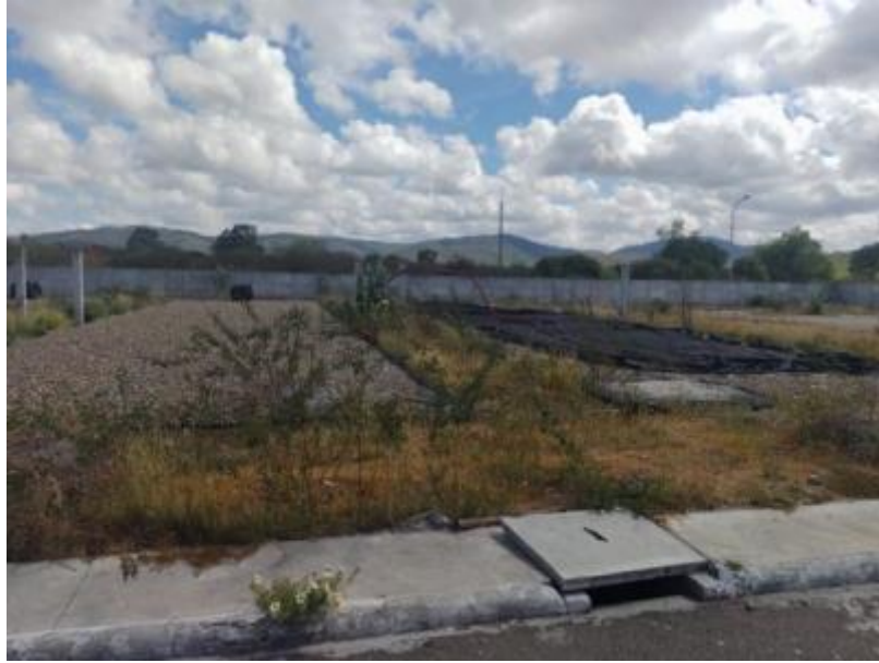
Figura 36 – Leito de secagem de lodo Fonte: INSTITUTO GESOIS, 2021.
