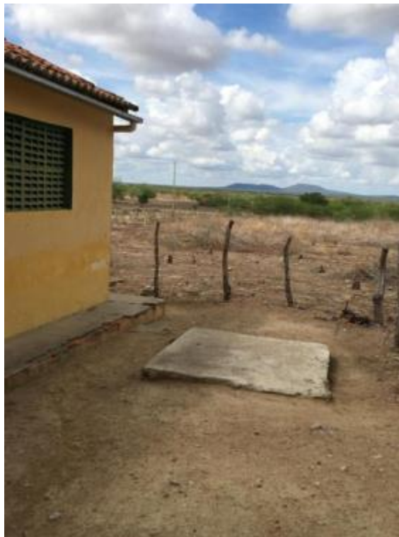
Figura 155 – Fossa Negra Fonte: INSTITUTO GESOIS, 2021.
