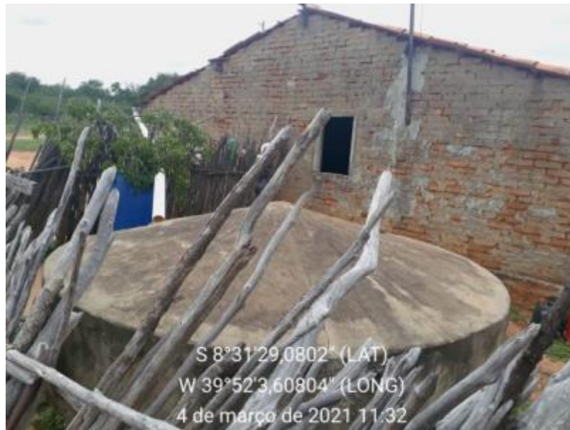
Figura 134 – Cisterna Fonte: INSTITUTO GESOIS, 2021.
