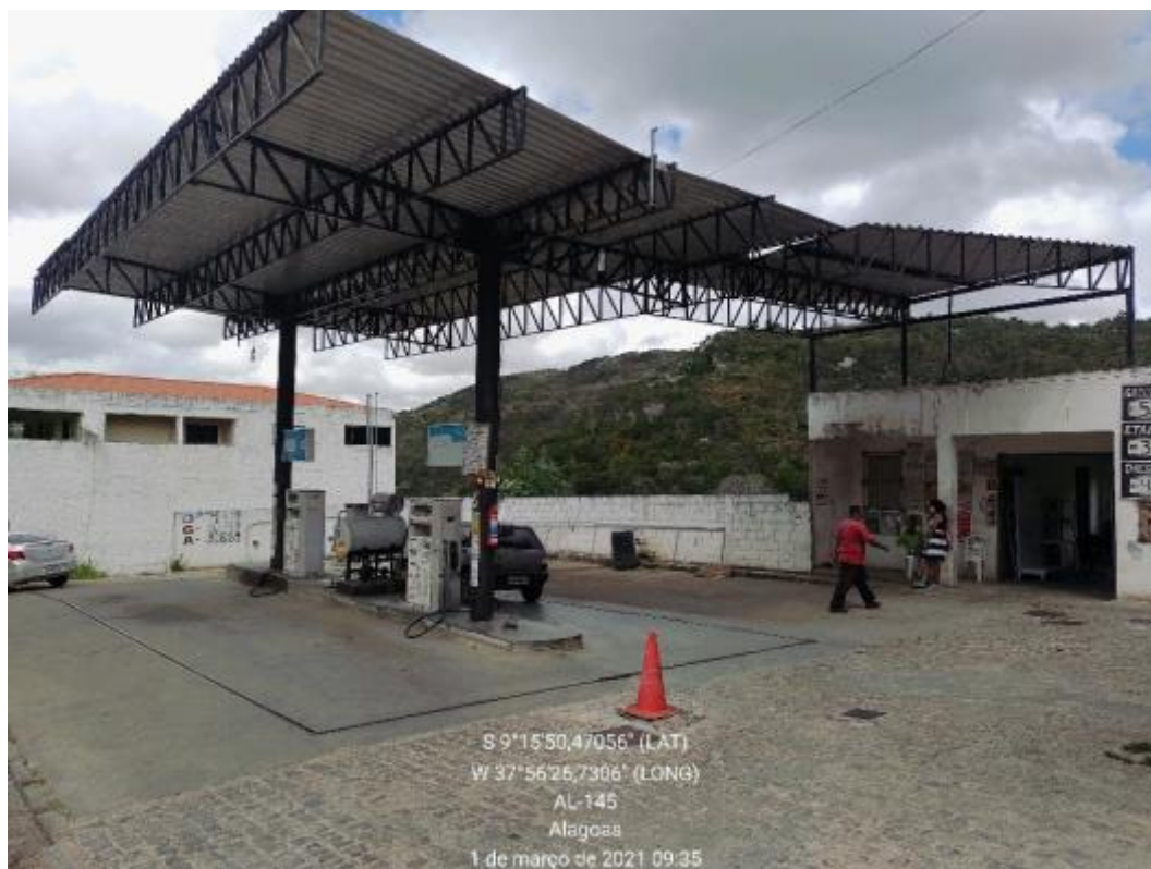
Figura 292 – Posto de Gasolina Fonte: INSTITUTO GESOIS, 2021.
