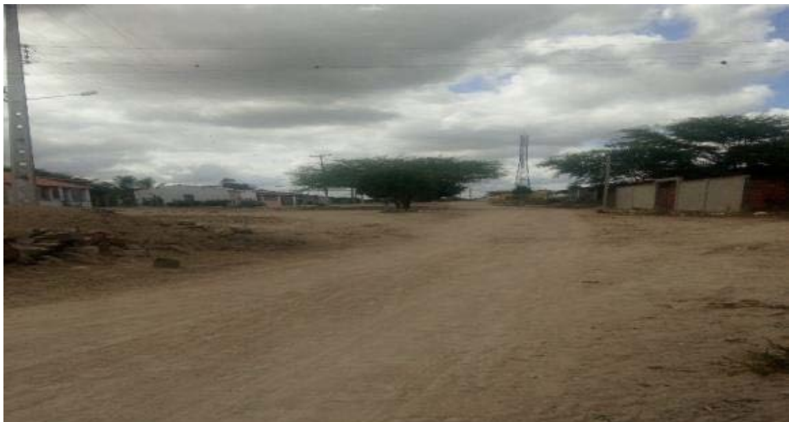
Figura 305 – Acesso sem pavimentação ao distrito Lagos das Pedras
