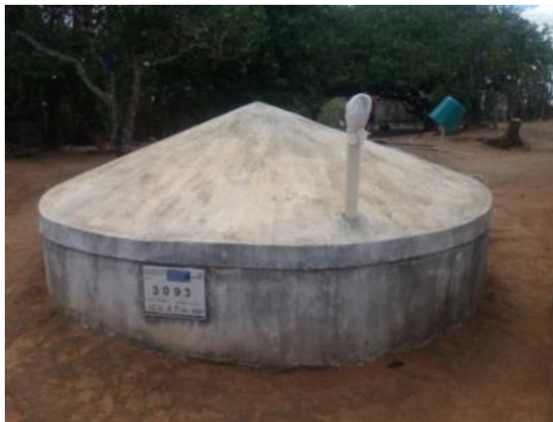
Figura 122 – Cisterna Fonte: INSTITUTO GESOIS, 2021.
