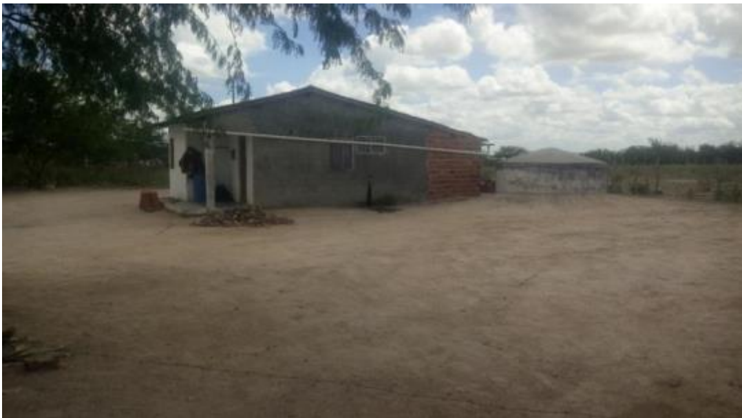
Figura 185 – Cisterna Fonte: INSTITUTO GESOIS, 2021.
