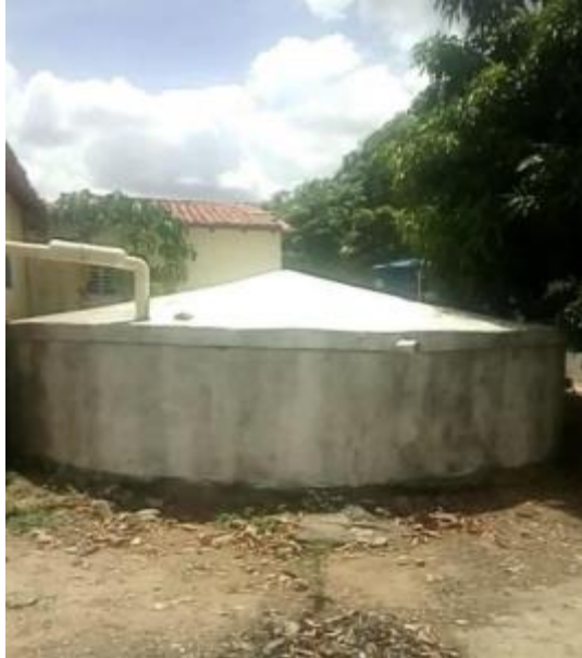
Figura 71 – Cisterna Fonte: INSTITUTO GESOIS, 2021.
