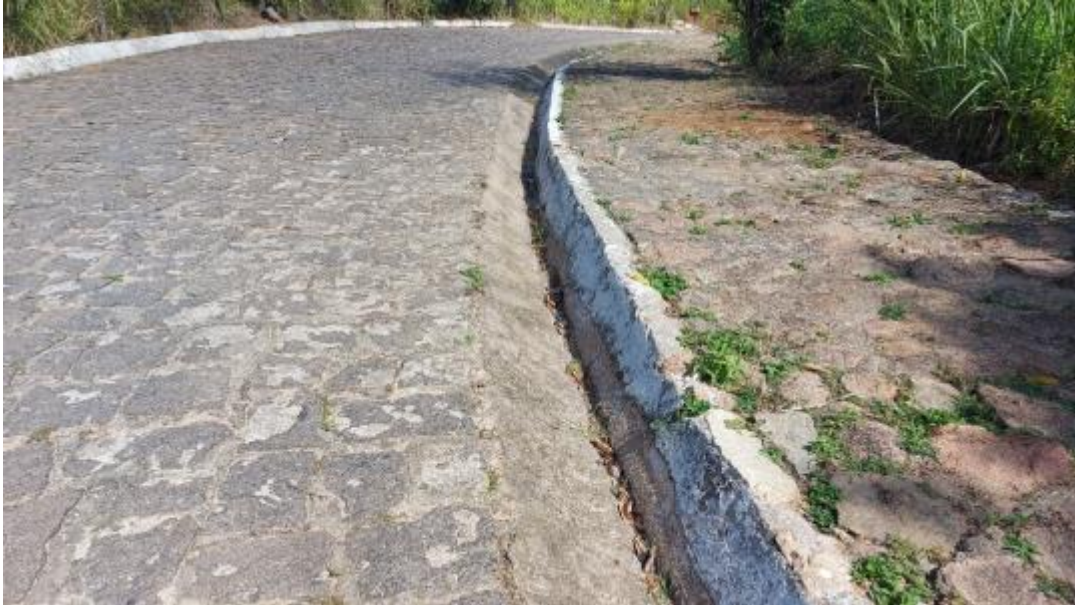
Figura 296 – Pavimentação poliédrica e sarjeta em rua localizada no Mirante Fonte: INSTITUTO GESOIS, 2020.
