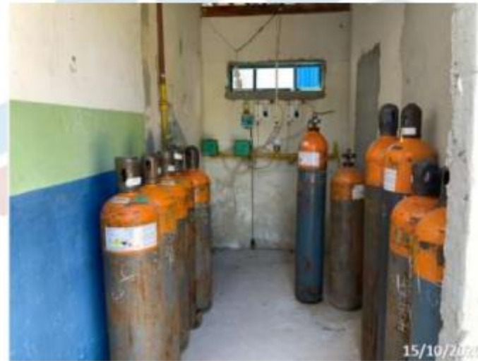
Figura 48 – Cilindros de Cloro EEAT- 05 Fonte: ARSAL, 2020.
