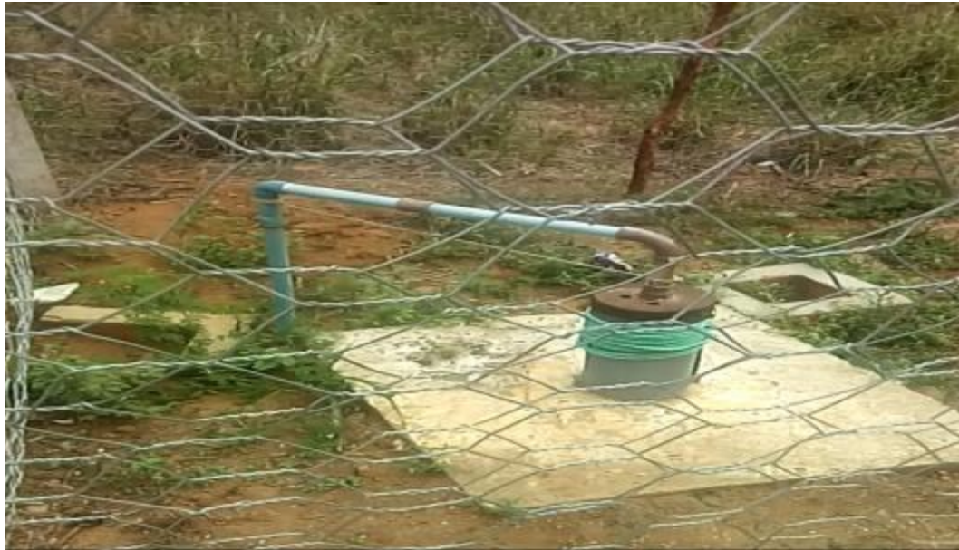
Figura 214 – Poço Subterrâneo Fonte: INSTITUTO GESOIS, 2021.
