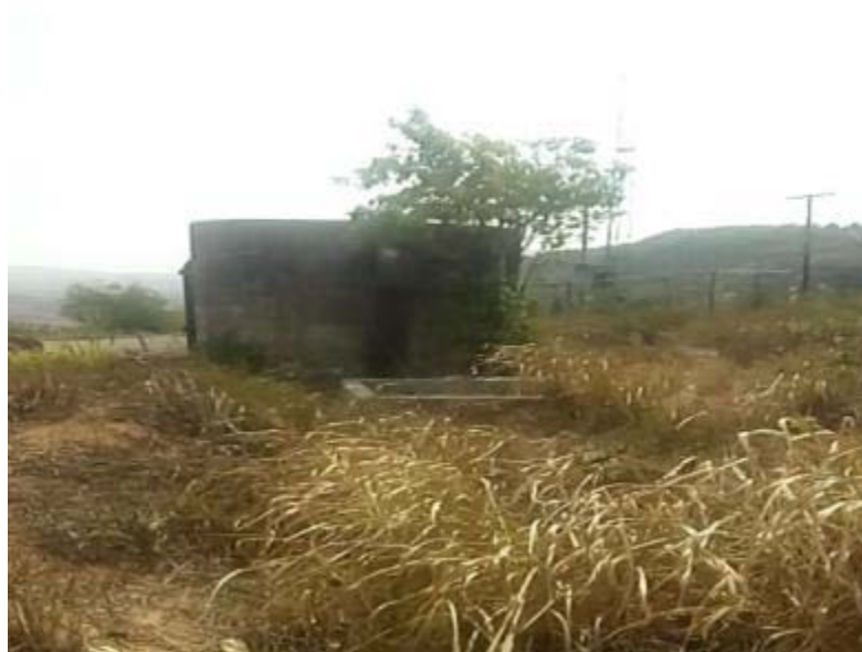
Figura 128 – Bombeamento Fonte: INSTITUTO GESOIS, 2021.
