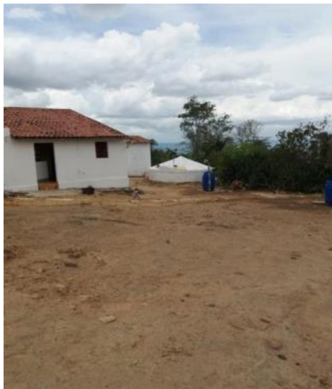
Figura 237 – Cisterna Fonte: INSTITUTO GESOIS, 2021.
