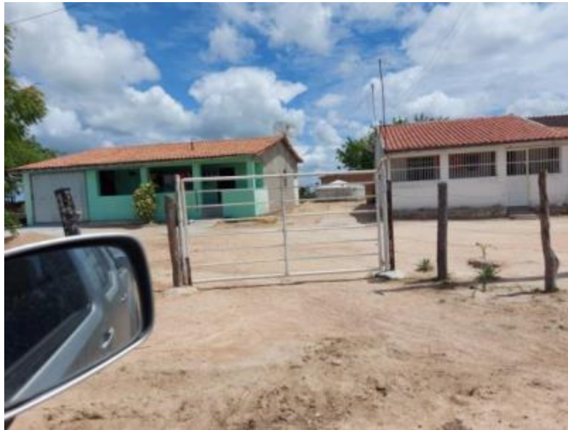
Figura 153 – Vista da Comunidade com Cisternas Fonte: INSTITUTO GESOIS, 2021.
