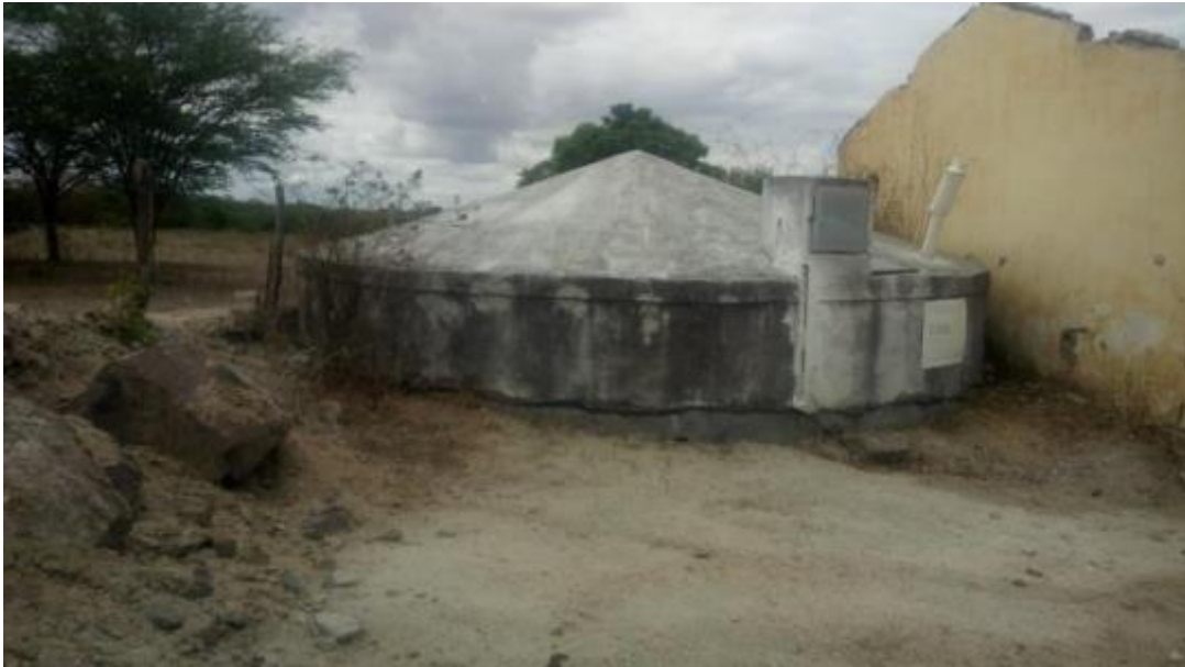
Figura 162 – Cisterna Fonte: INSTITUTO GESOIS, 2021.
