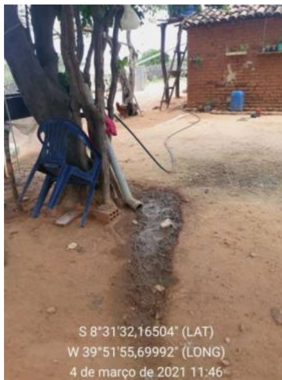
Figura 135 – Esgoto a céu aberto Fonte: INSTITUTO GESOIS, 2021.
