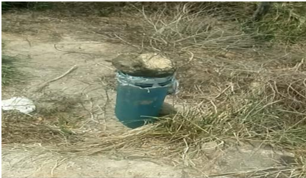
Figura 229 – Poço Subterrâneo em instalação Fonte: INSTITUTO GESOIS, 2021.
