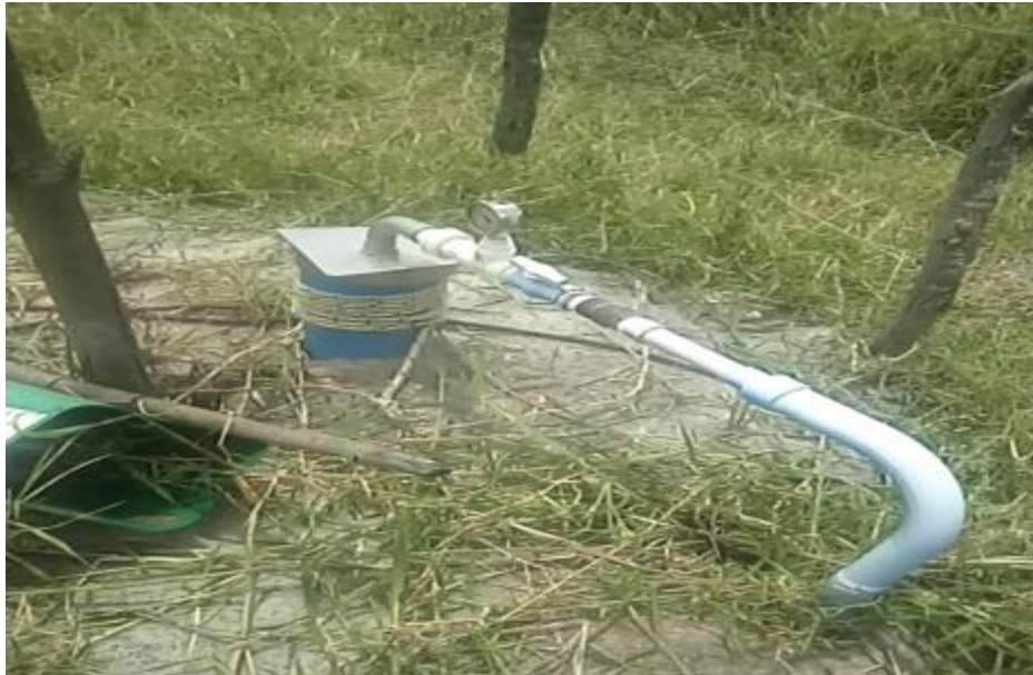
Figura 174 – Poço subterrâneo Fonte: INSTITUTO GESOIS, 2021.
