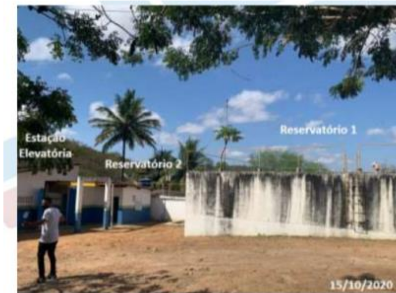
Figura 44 – Reservatório 1 EEAT-04 Fonte: ARSAL, 2020.
