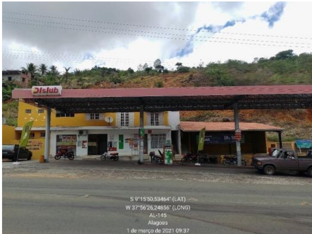
Figura 291 – Posto de Gasolina Fonte: INSTITUTO GESOIS, 2021.
