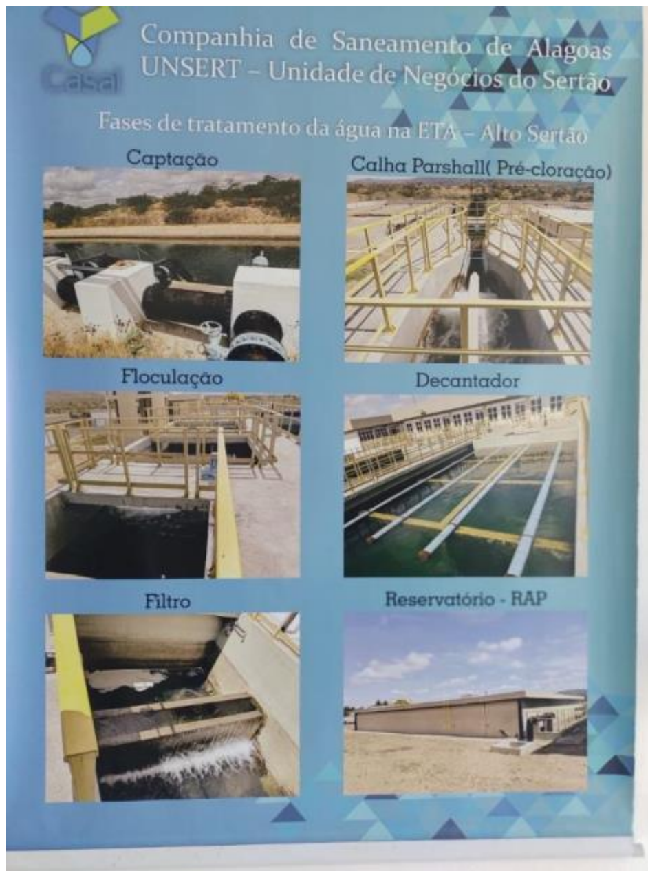
Figura 27 – Etapas de Tratamento ETA-Alto Sertão Fonte: ARSAL, 2020.
