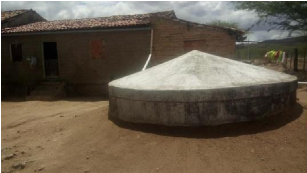
Figura 194 – Cisterna Fonte: INSTITUTO GESOIS, 2021.
