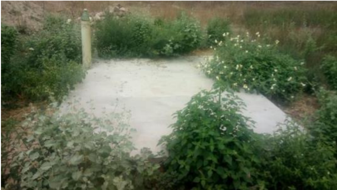
Figura 80 – Fossa Negra Fonte: INSTITUTO GESOIS, 2021.
