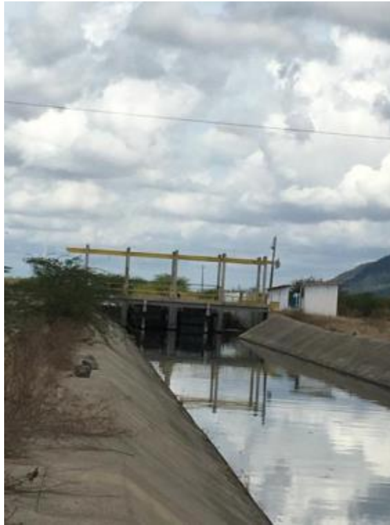
Figura 220 – Comporta no Canal do Sertão Fonte: INSTITUTO GESOIS, 2021.
