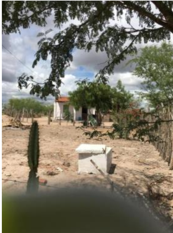
Figura 147 – Poço Subterrâneo Fonte: INSTITUTO GESOIS, 2021.
