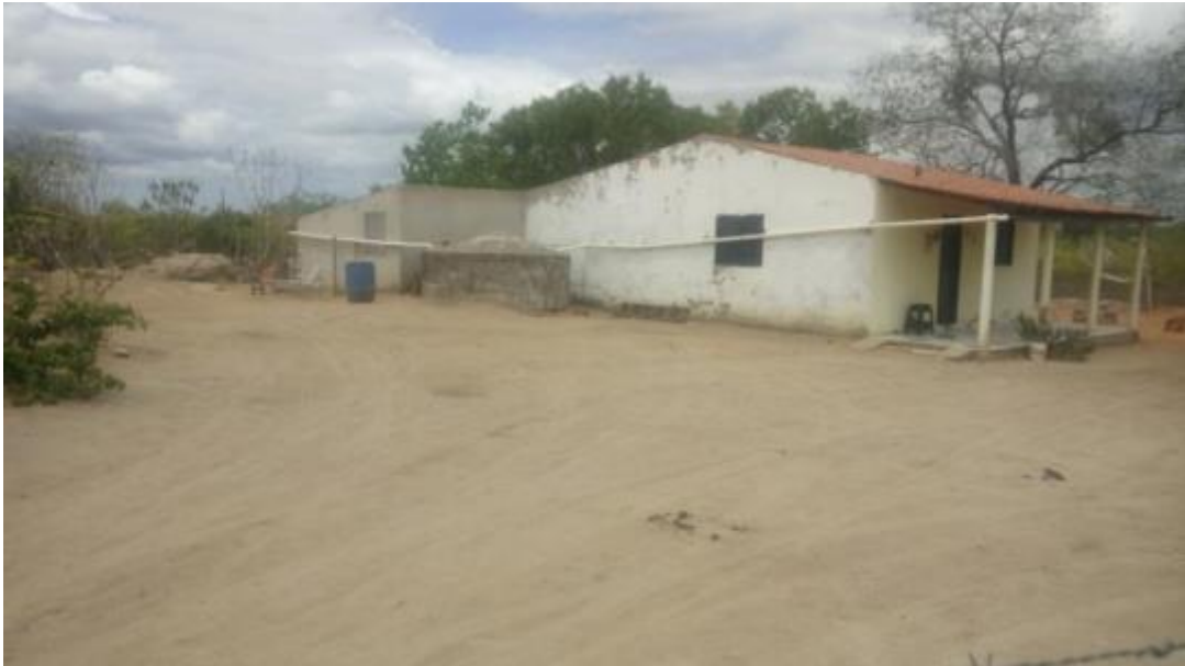
Figura 158 – Cisterna Fonte: INSTITUTO GESOIS, 2021.
