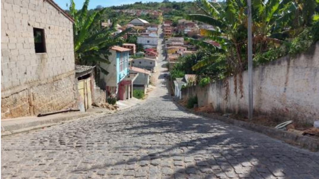
Figura 298 – Rua central pavimentada e com sarjeta Fonte: INSTITUTO GESOIS, 2020.
