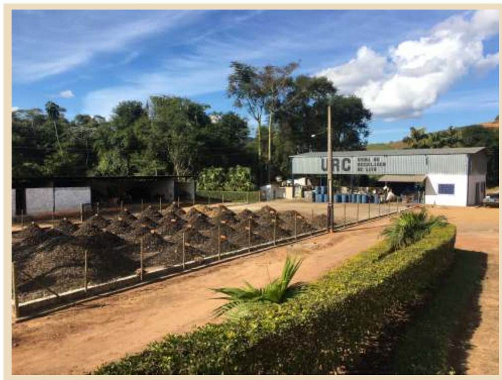
Figura 4 – Vista geral de uma UTC
