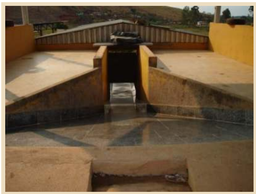
Figura 7 – Fosso de descarga dos RSU
