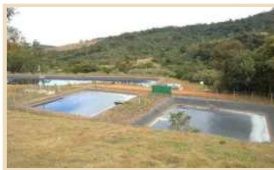
Figura 10 - Sistema de tratamento de lixiviados
