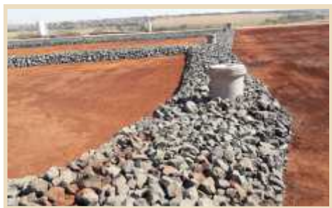
Figuras 8 e 9 - Dreno de lixiviados e de gases
