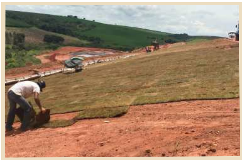
Figura 15 - Plantio de grama nos taludes
