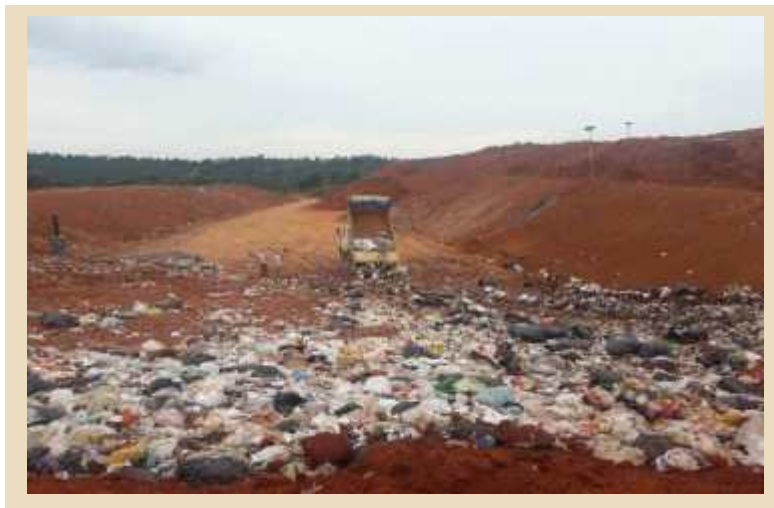
Figura 13 - Descarga dos rejeitos
