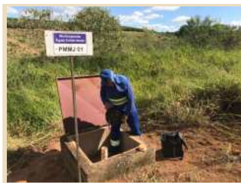
Figura 17 - Poço de monitoramento de água subterrânea
