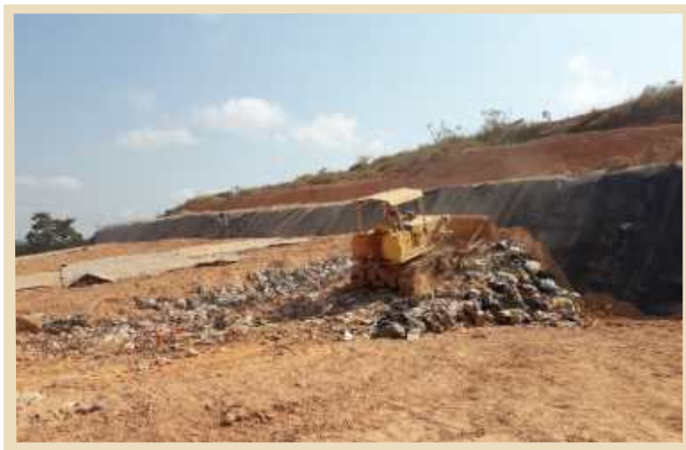
Figura 14 - Compactação dos rejeitos
