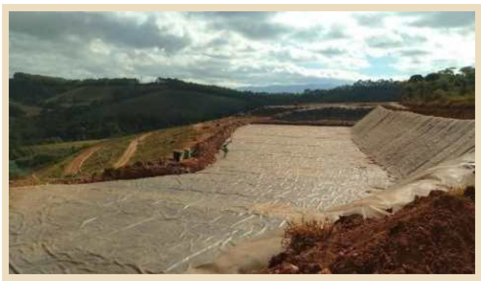
Figura 5 - Impermeabilização da camada da base
